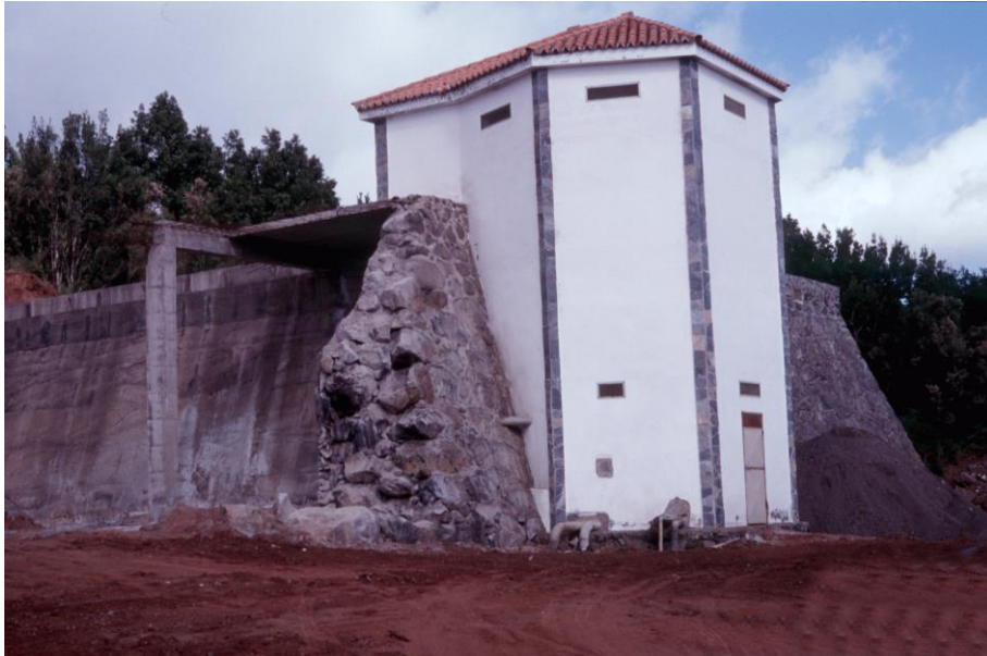
Depósito general de agua en el monte-verde de Puntallana.
