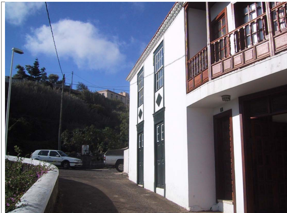
9.2 – Vista general del edificio desde la calle Procesiones en su fachada este
