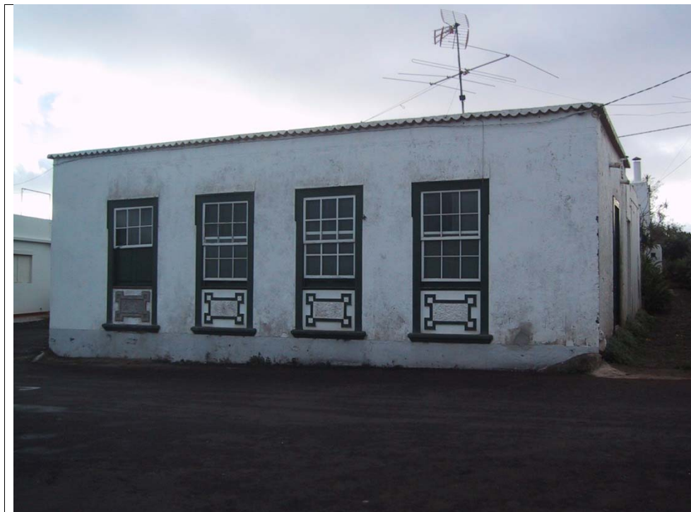
28.2 – Vista general del edificio. Fachada norte
