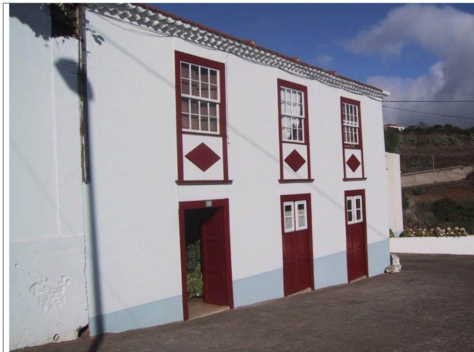
14.2 – Vista del edificio desde la calle Procesiones (fachada este)
