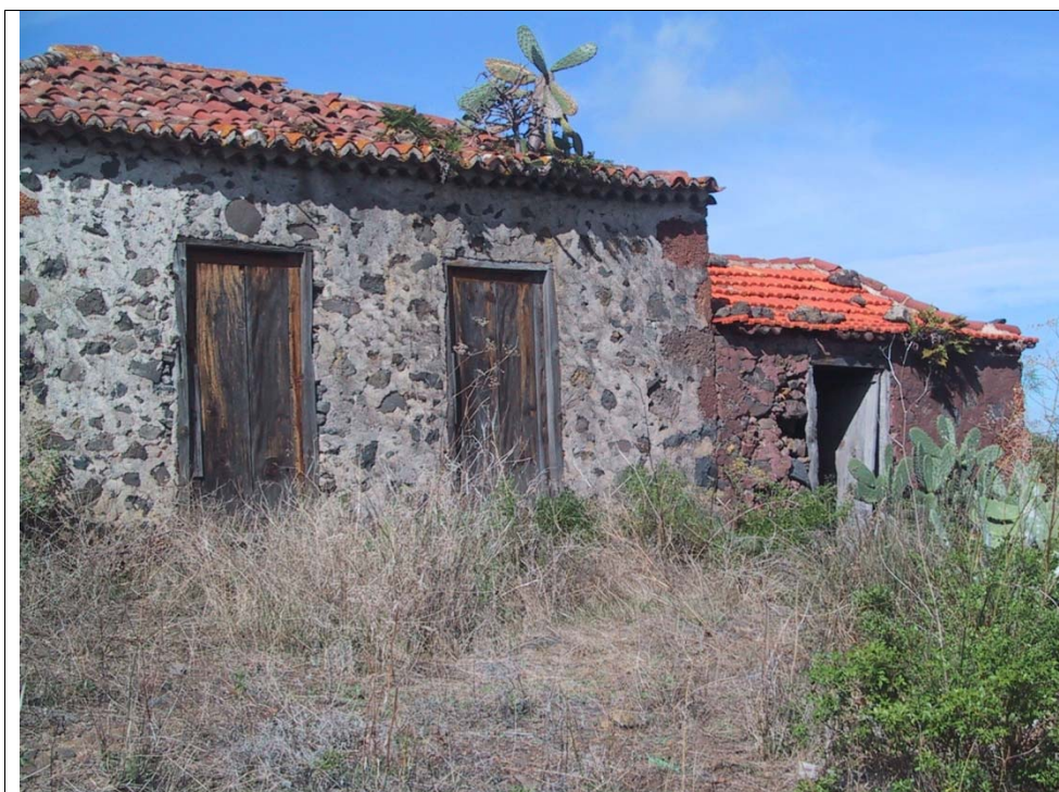
23.1 – Vista parcial de la edificación hacia el este
