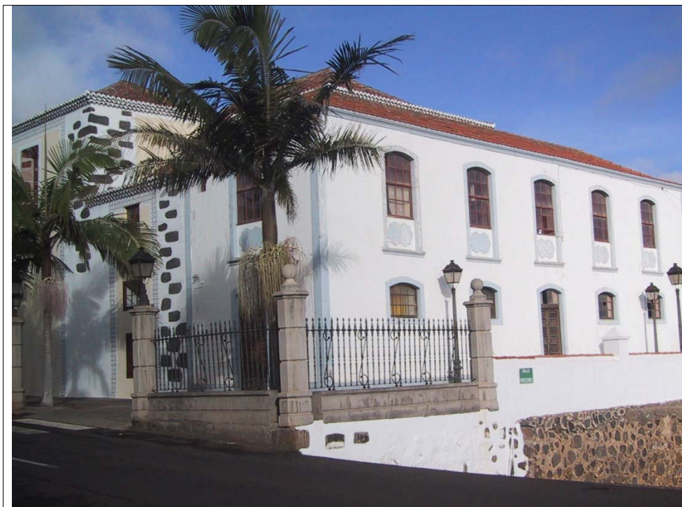
29.1 – Vista general del edificio. Fachada Este
