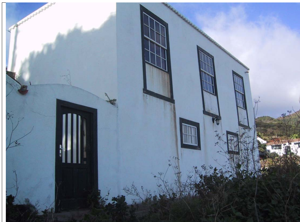
7.2 – Vista posterior de la edificación. Fachada Este
