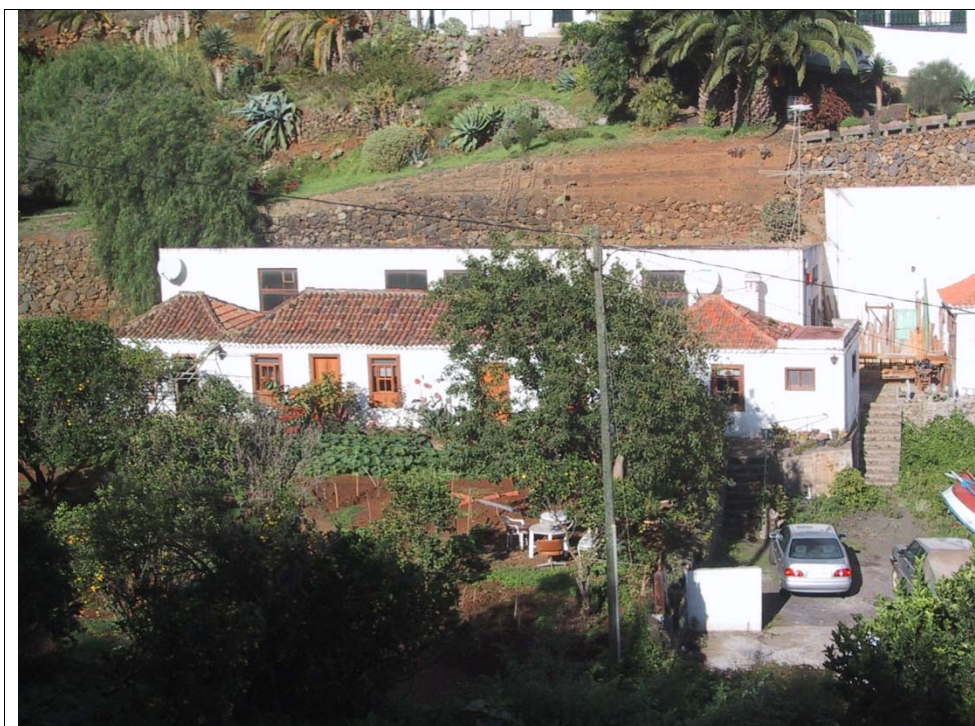
8.1 – Vista general del edificio
