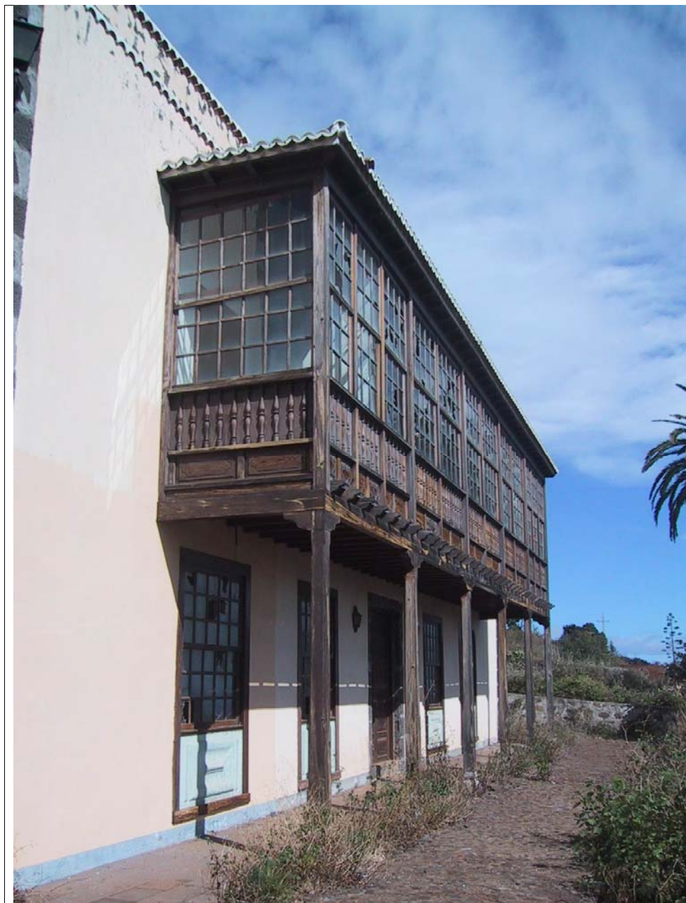
3.6 – Vista parcial de la balconada exterior hacia el este
