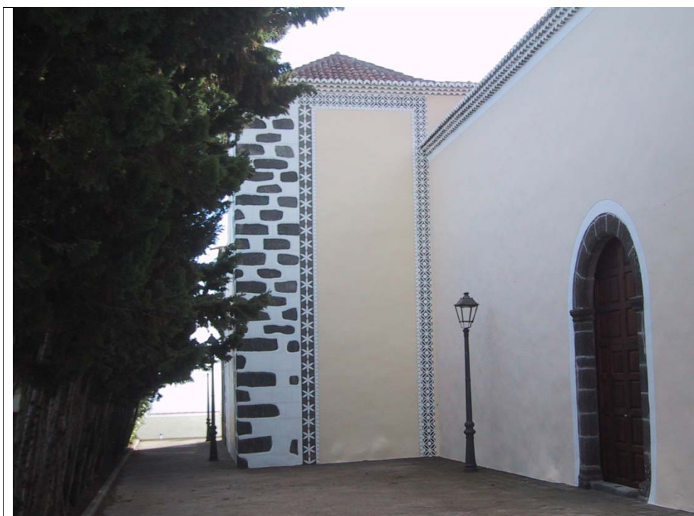
29.4 – Vista parcial. Fachada Norte
