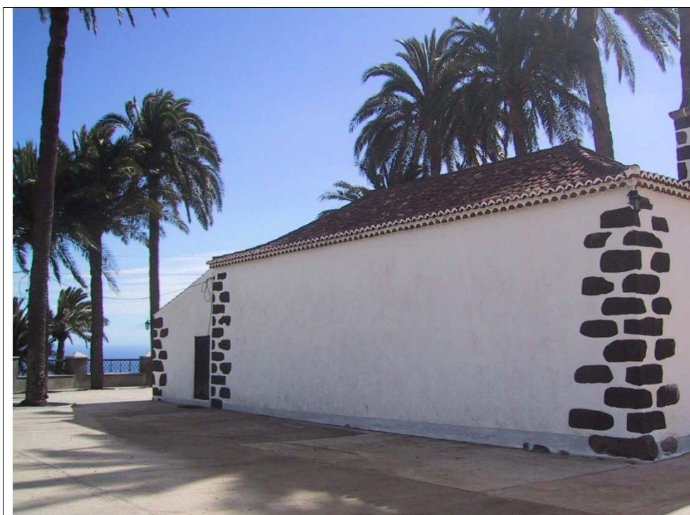
4.3 – Vista general fachada Norte
