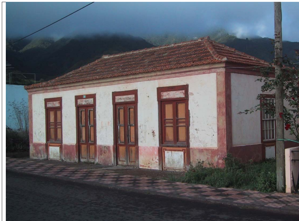
25.2 – Vista del edificio desde la calle San Bartolomé
