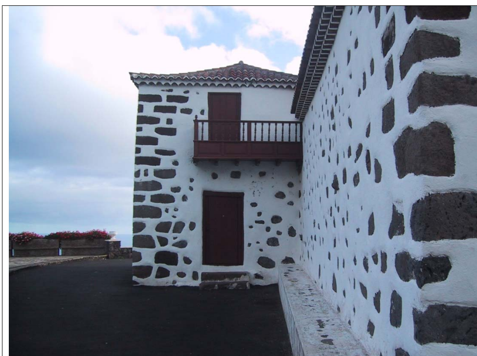
27.2 – Vista parcial de la fachada Norte
