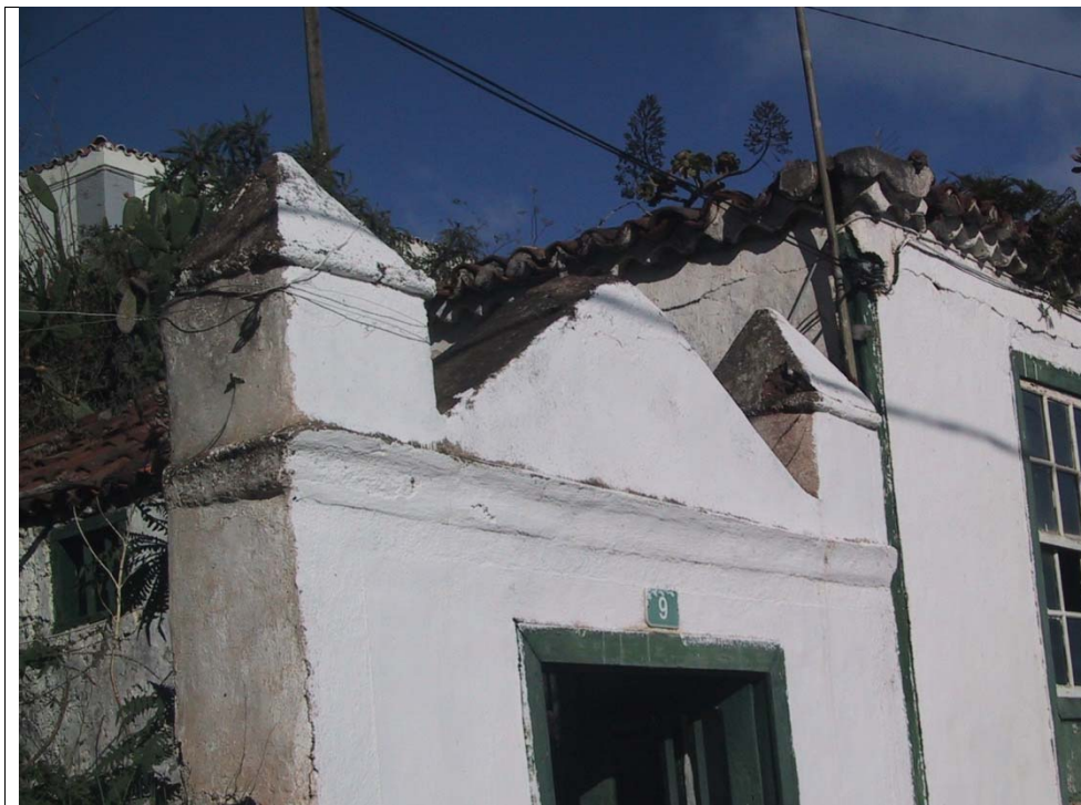
13.2 – Vista parcial de la portada de entrada
