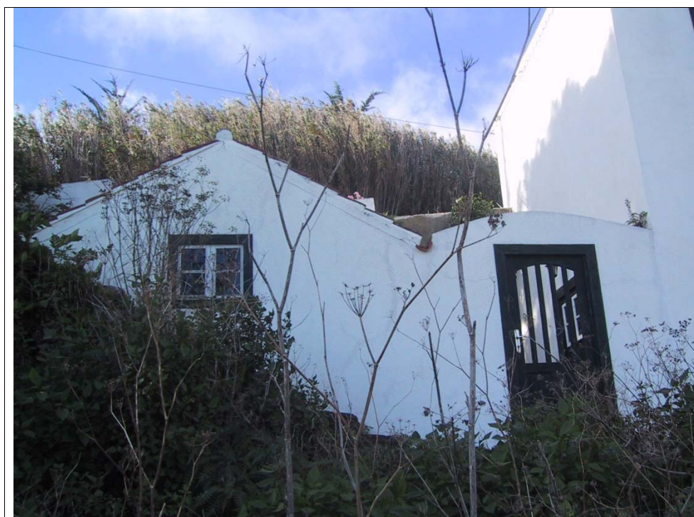
7.3 – Vista parcial del edificio
