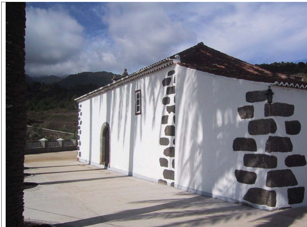
4.2 – Vista fachada Sur
