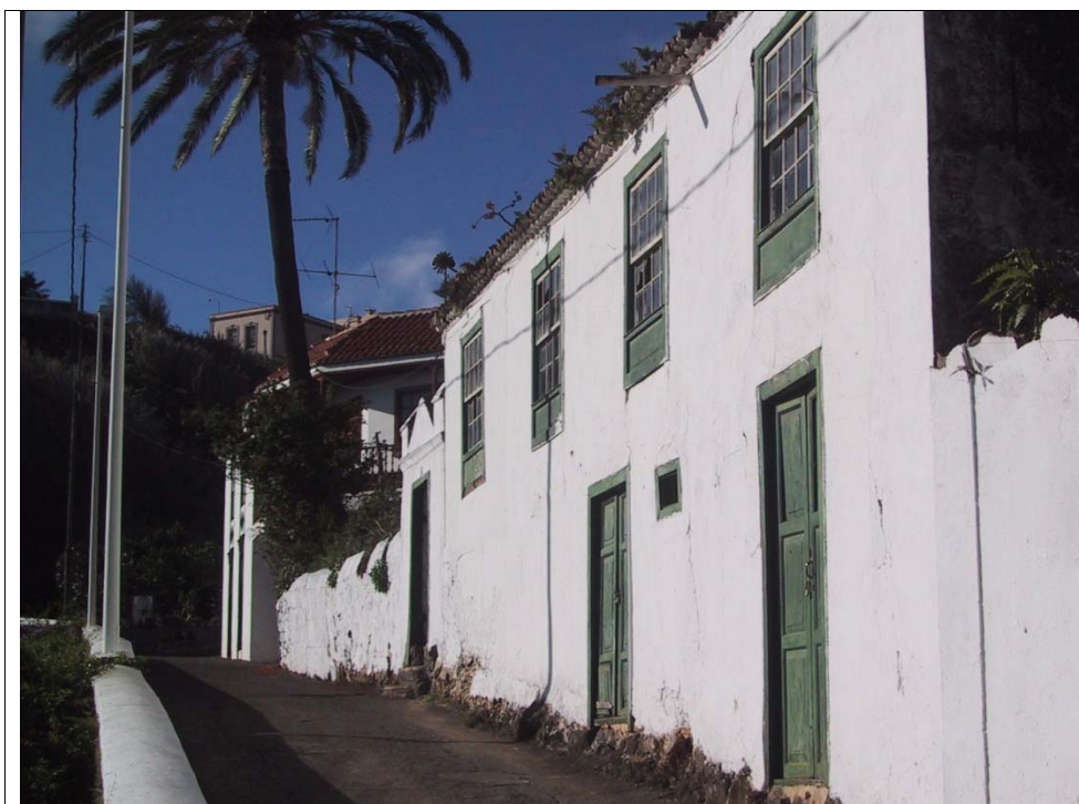
13.1 – Vista del edificio desde la calle Procesiones
