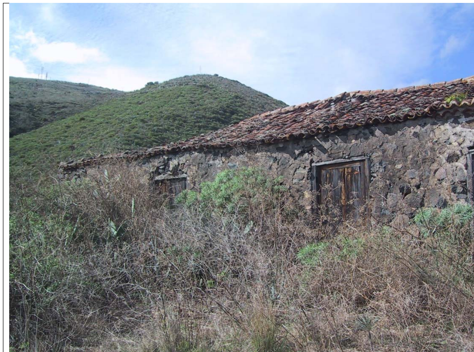
23.2 – Vista parcial de la edificación hacia el oeste
