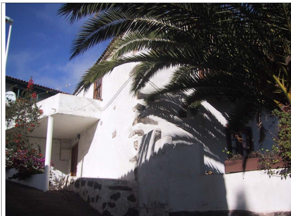
19.1 – Vista del edificio desde la calle Procesiones
