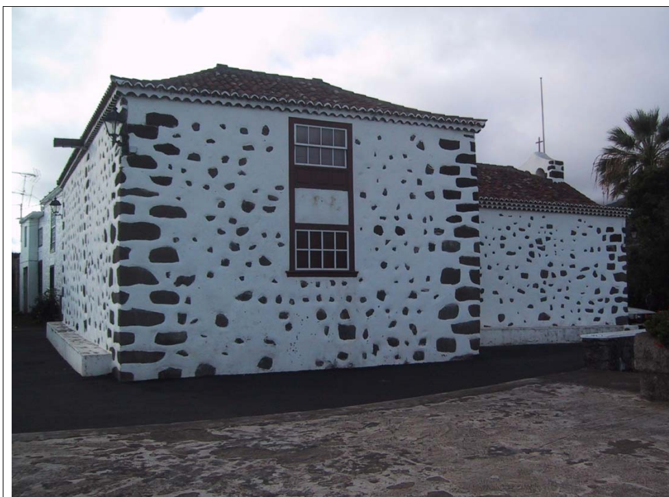
27.4 – Vista general del edificio. Fachada Este
