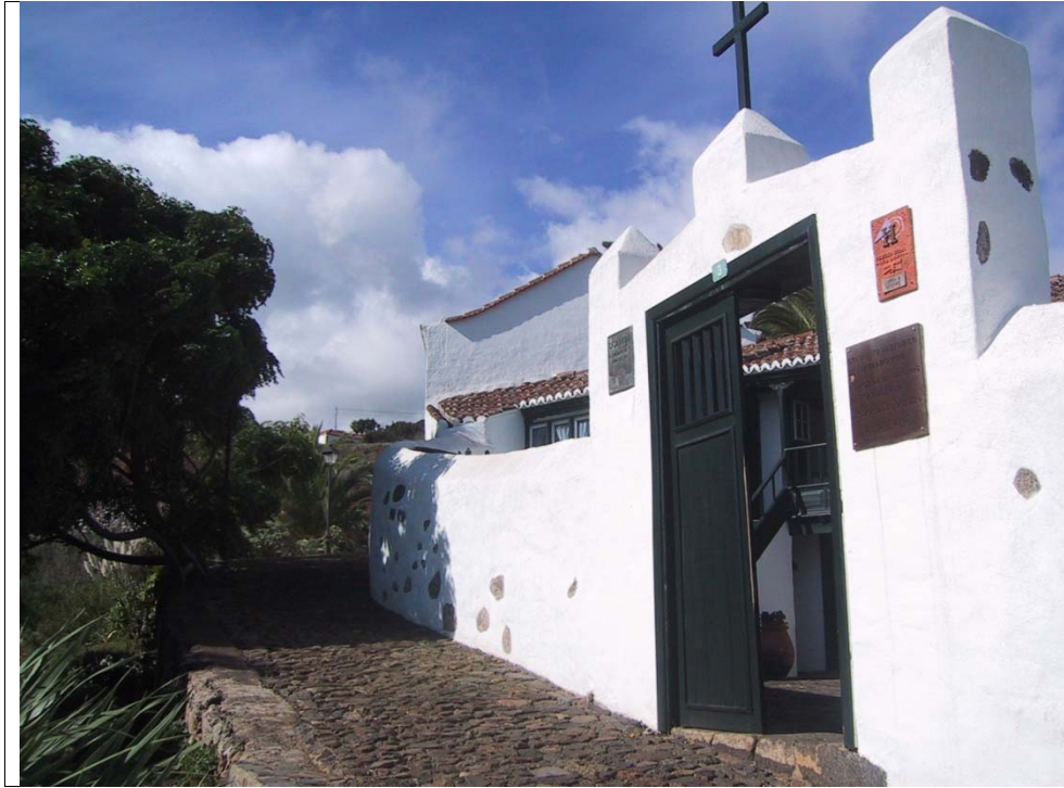
12.1 – Vista parcial. Acceso
