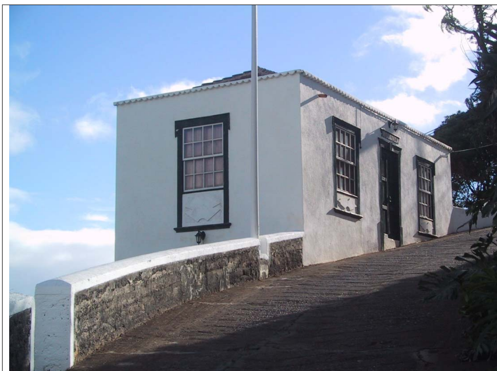
7.1 – Vista de la edificación desde la calle Procesiones
