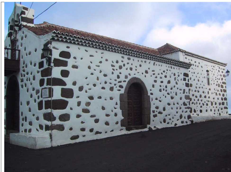
27.1 – Vista fachada Sur desde la calle San Bartolomé
