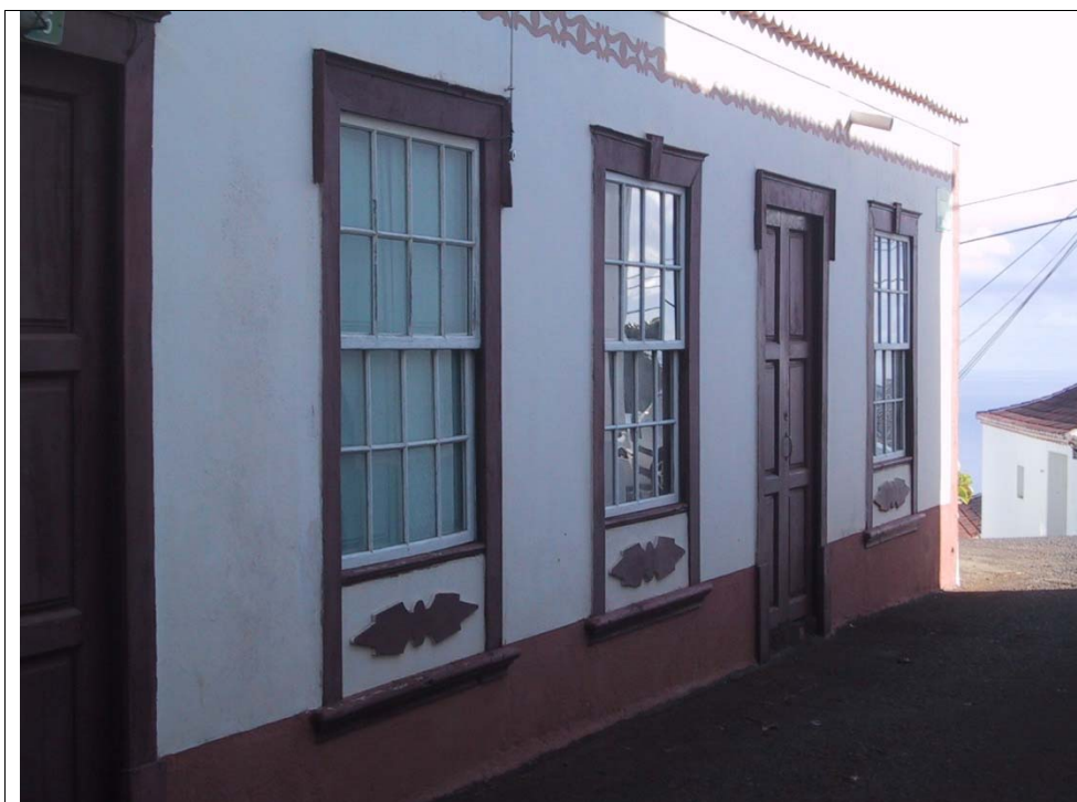
15.1 – Vista del edificio desde la calle La Fuenteña
