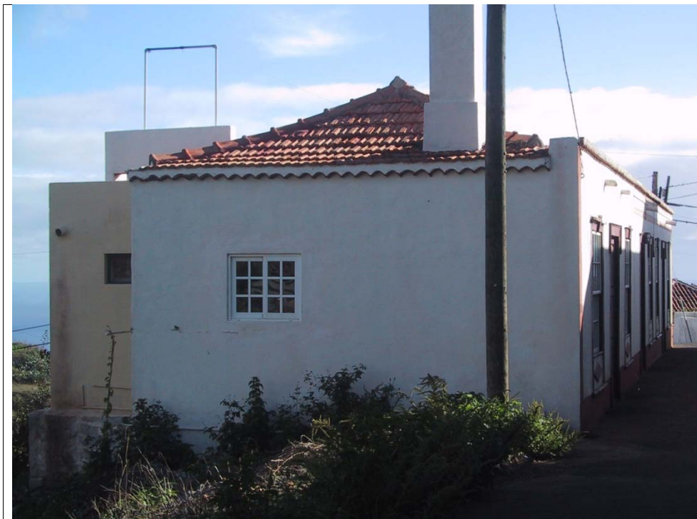
15.2 – Vista general del edificio desde la calle La Fuenteña
