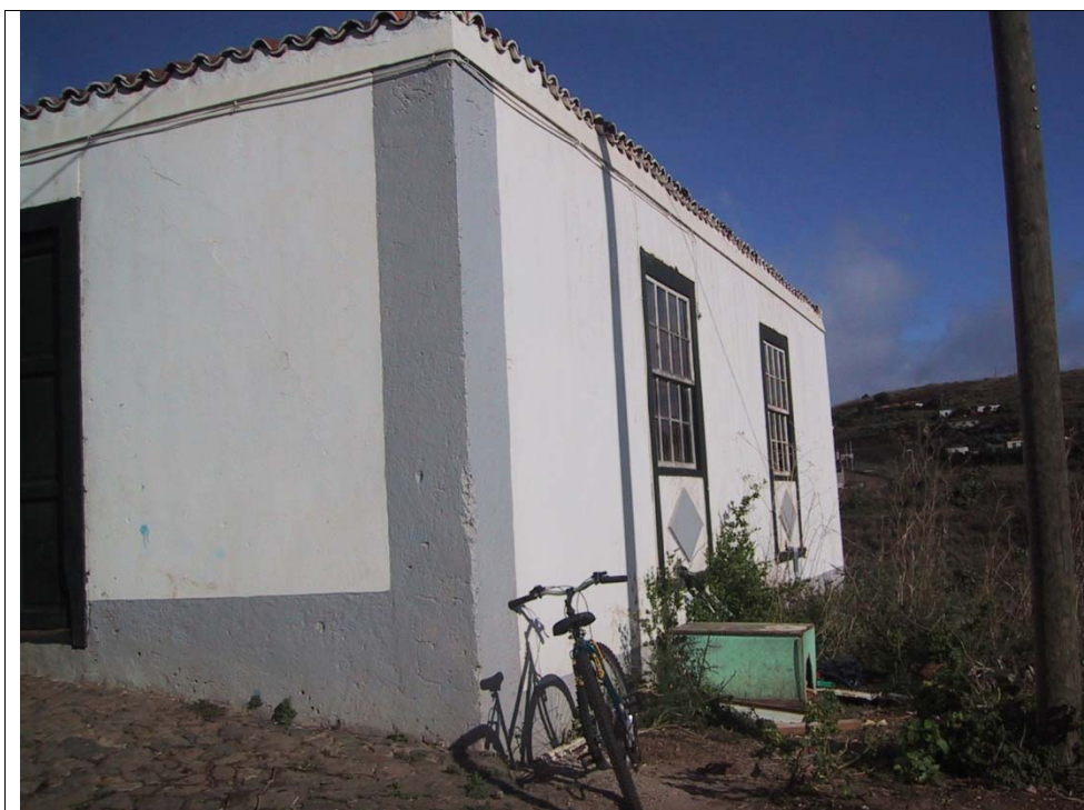
11.1 – Vista del edificio desde la calle El Posito
