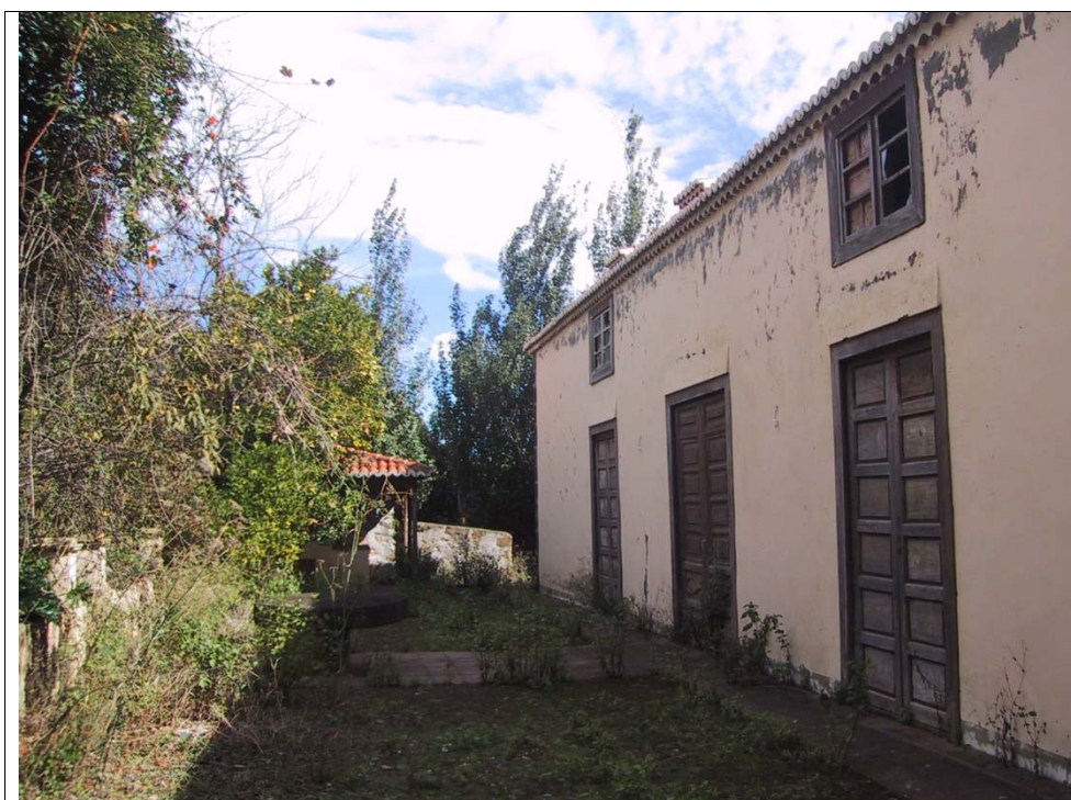
3.3 – Vista general fachada Oeste
