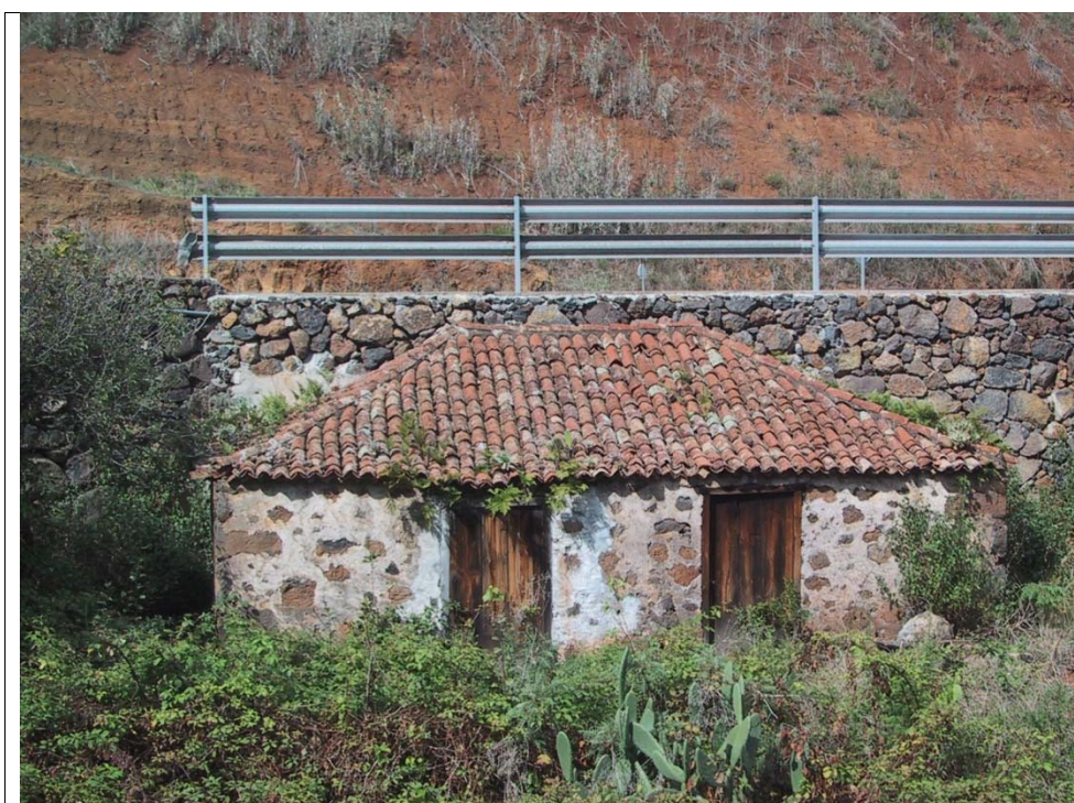
5.1 – Vista general del edificio-almacén desde el este
