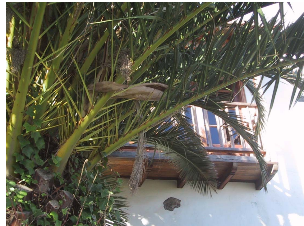
19.2 – Vista parcial de la balconada de madera
