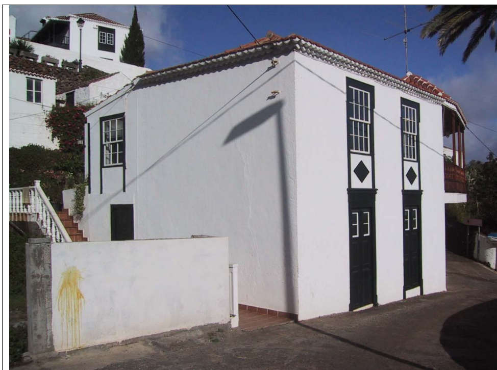
9.1 – Vista general de la fachada sur del edificio
