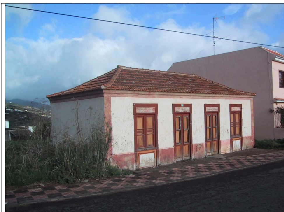
25.1 – Vista del edificio desde la calle San Bartolomé
