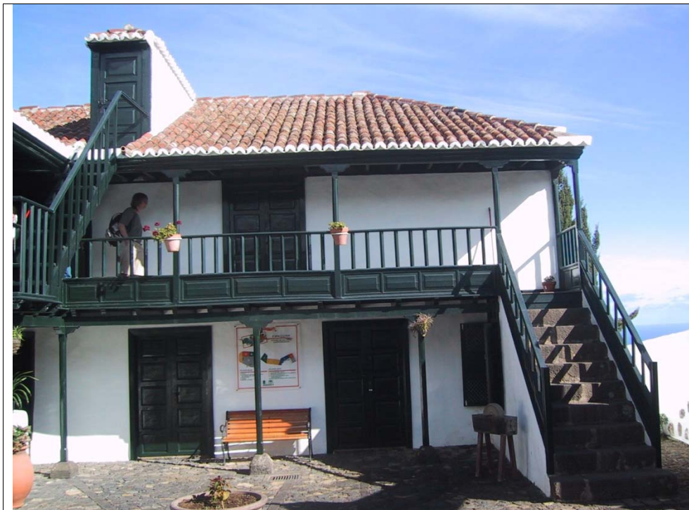
12.2 – Vista del patio interior
