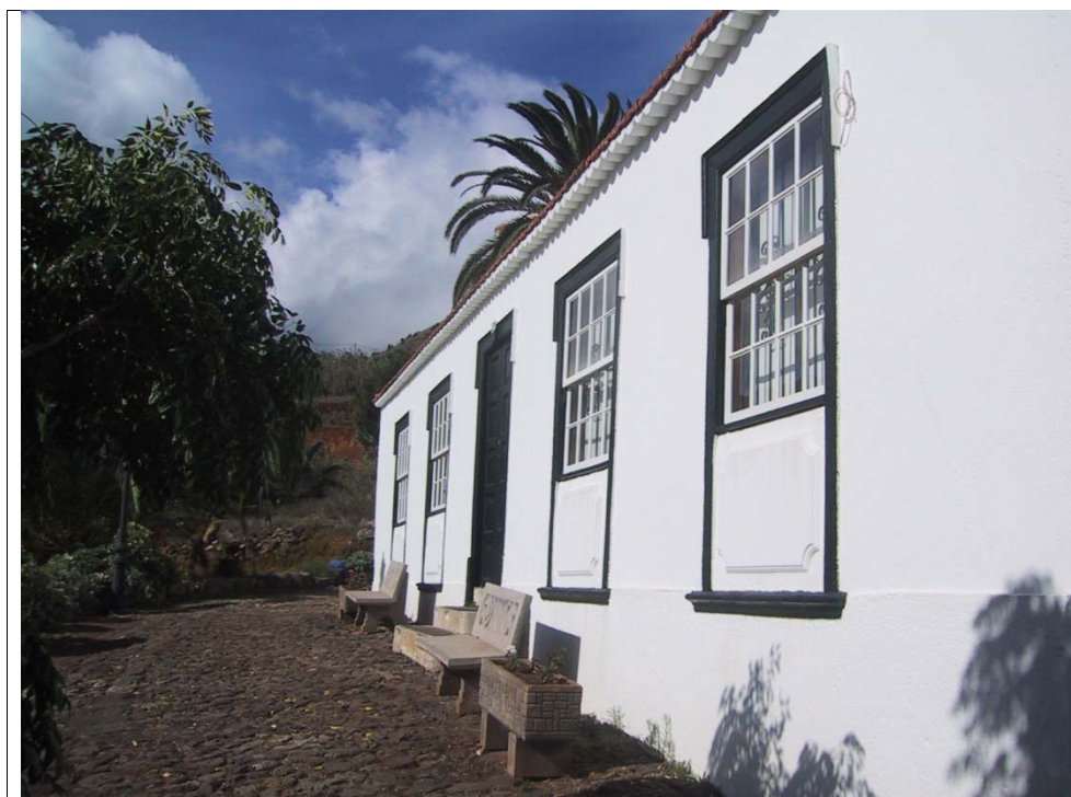
12.8 – Vista parcial edificio anexo
