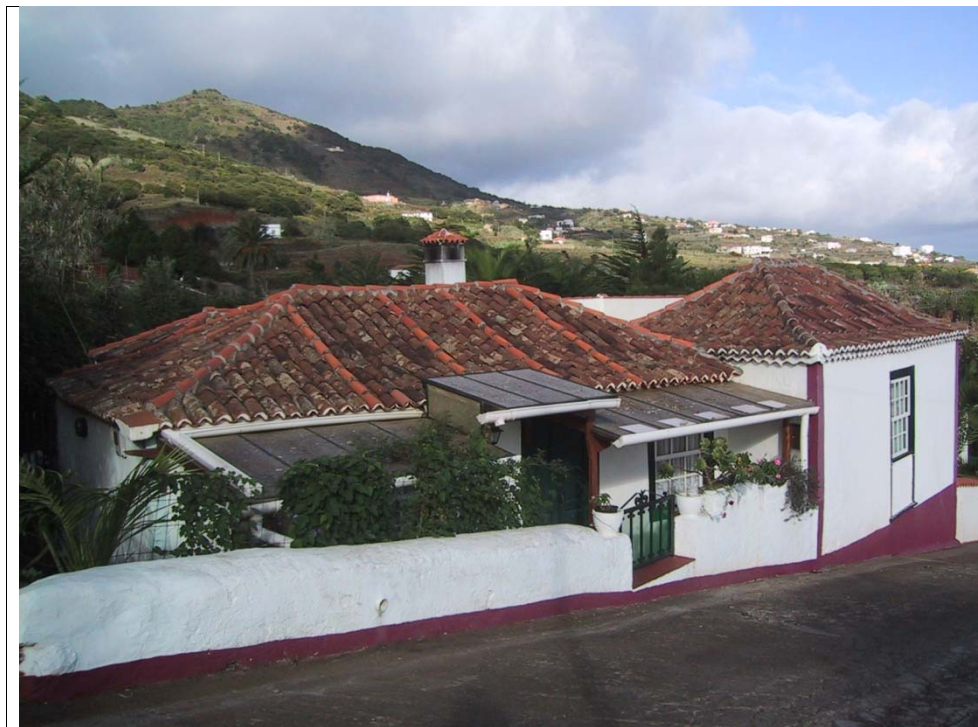
6.2 – Vista general desde la calle Procesiones en su fachada este
