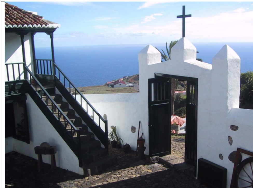
12.5 – Vista general del portón de entrada del edificio (por el interior)
