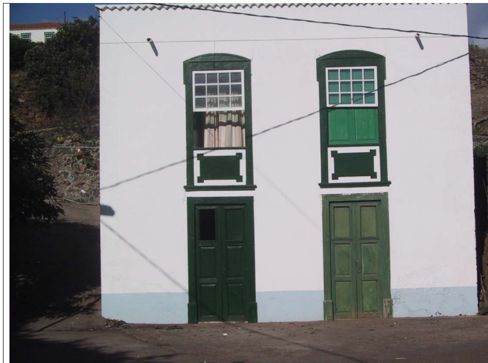
16.2 – Vista de la fachada este hacia la calle La Fuentiña
