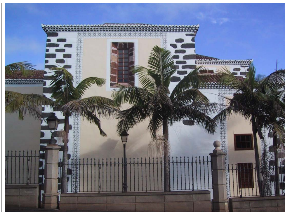
29.2 – Vista parcial del edificio desde calle Llano San Juan
