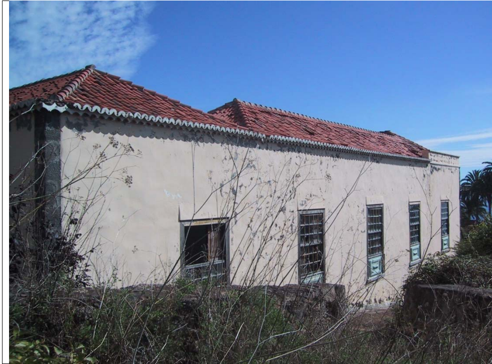
3.4 – Vista general fachada Sur
