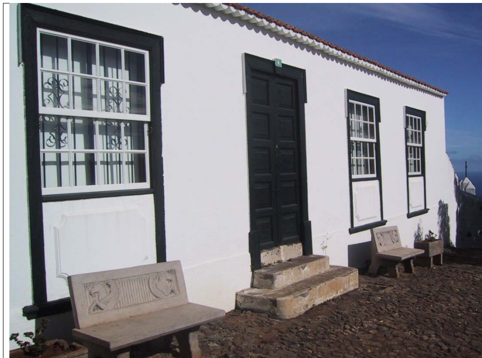
12.7 – Vista parcial edificio anexo
