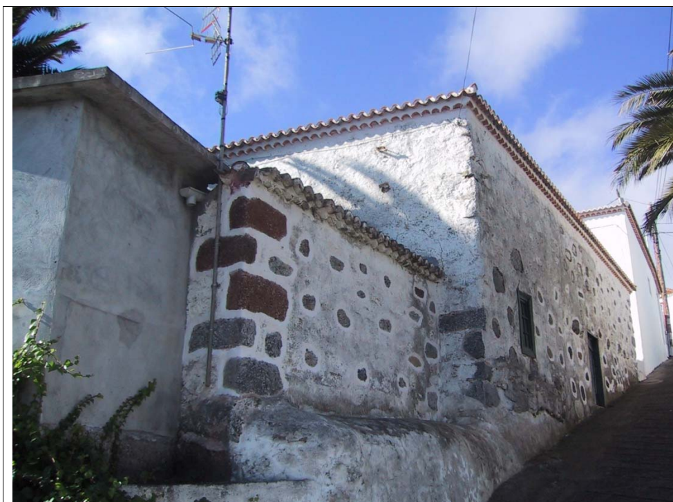
20.1 – Vista posterior del edificio desde la calle Procesiones
