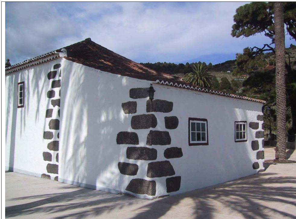
4.1 – Vista general fachada Este
