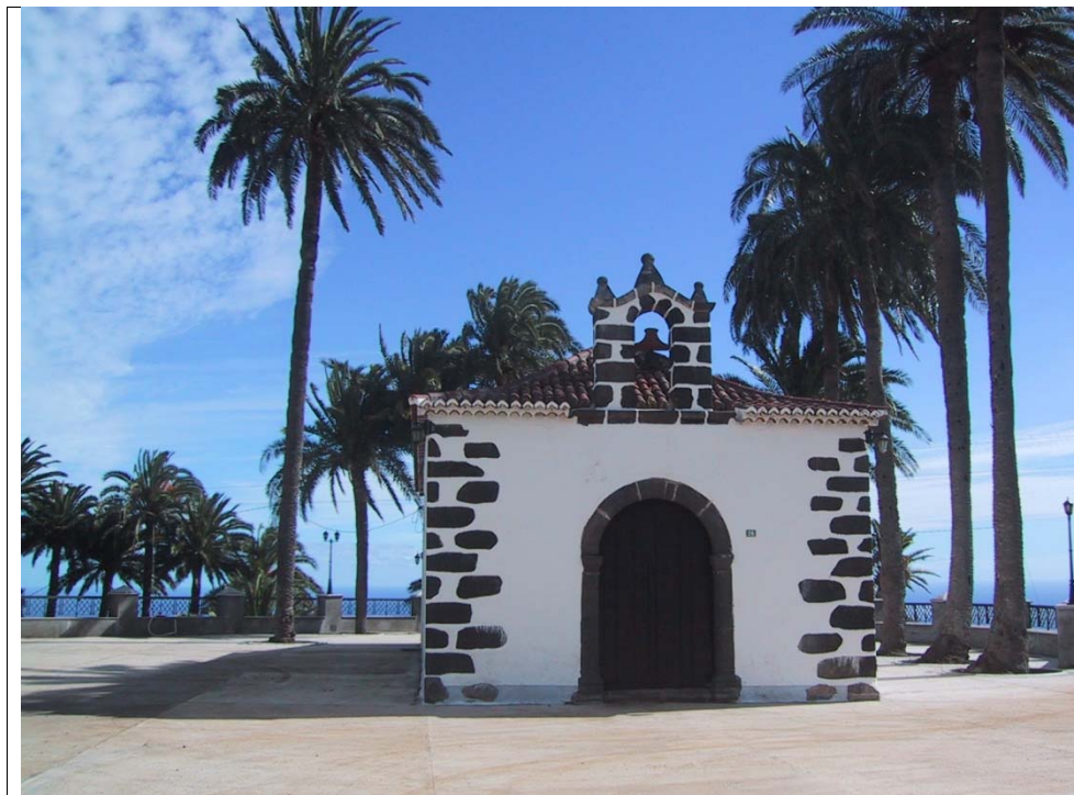
4.4 – Vista general fachada Oeste.
