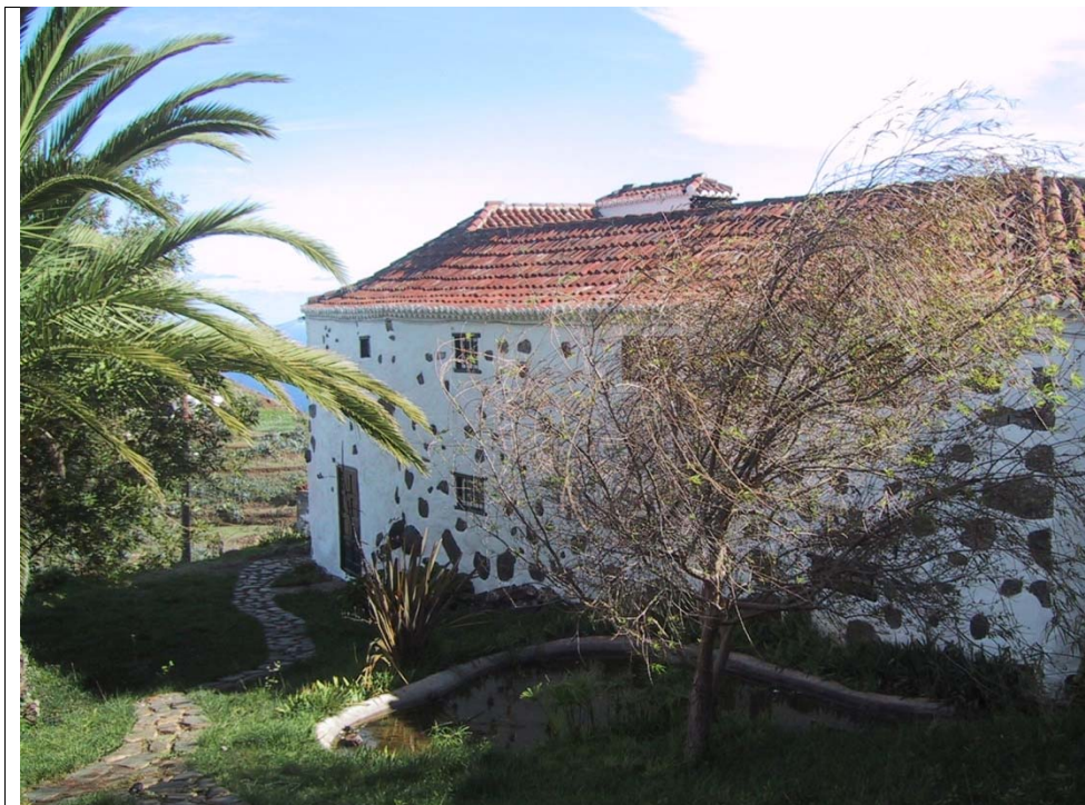
12.9 – Vista general fachada Norte del edificio
