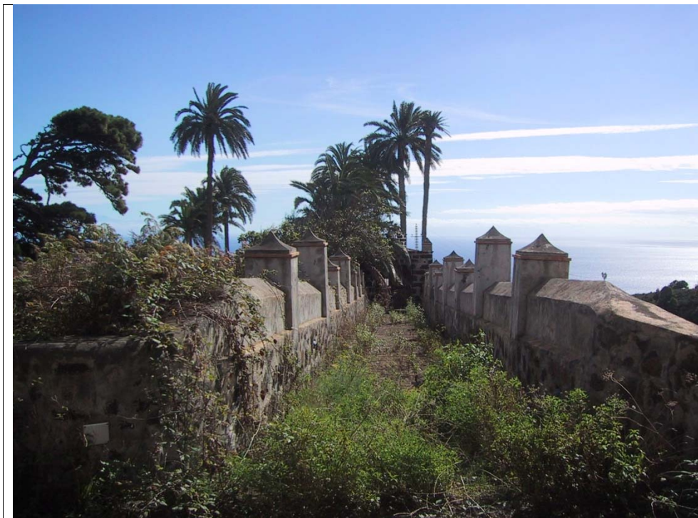
3.5 – Vista general del acceso.
