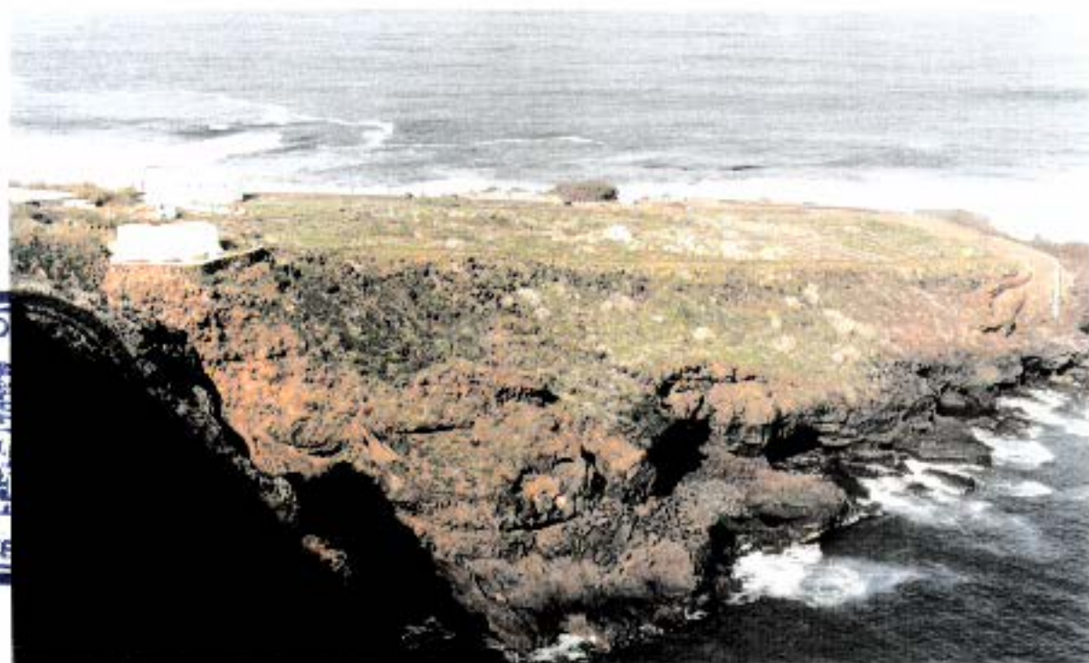
FOTO 46.- La Fajana. Las obras de acondicionamiento del litoral y las infraestructuras llevadas a cabo recientemente, aconsejan control y ordenación.
