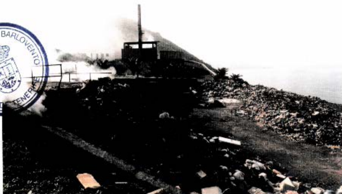
FOTO 32.- Impacto ambiental por humos y desperdicios en las inmediaciones del horno de incineración de Los Camachos.
