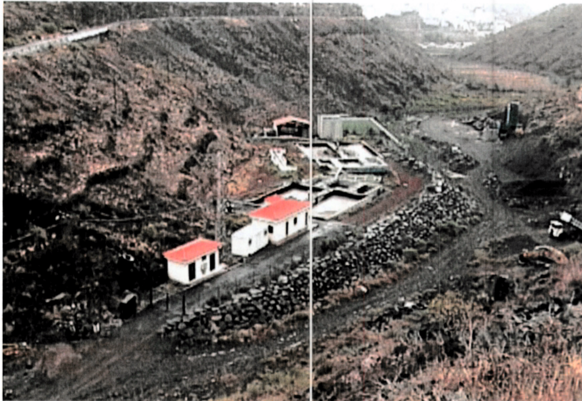
DEPURADORAS DE AGUA
