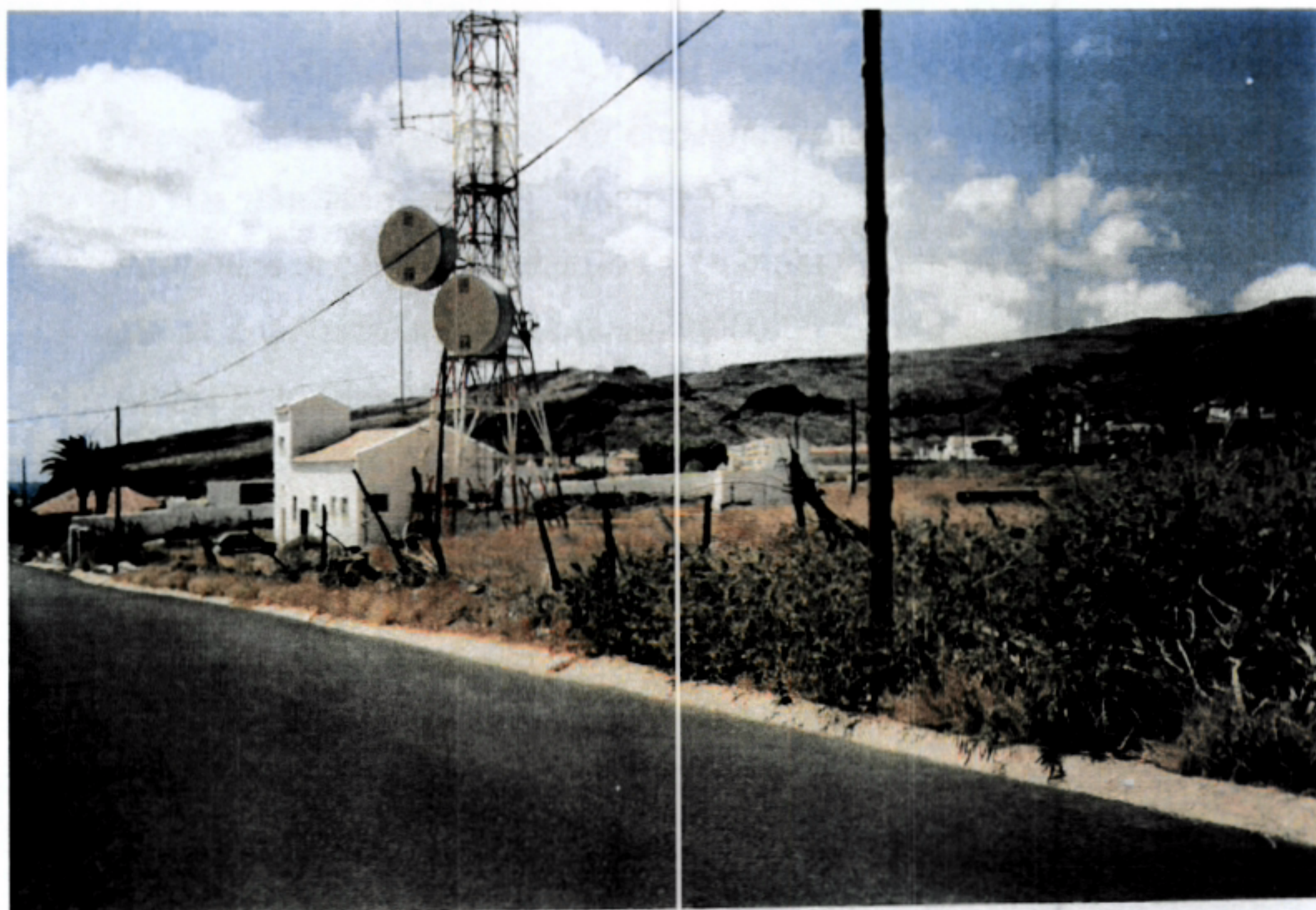
INSTALACIÓN DE ANTENA RECEPTORA
