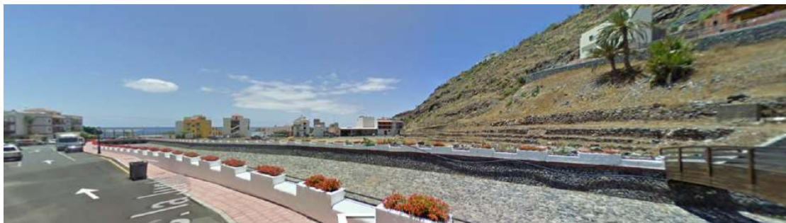
Panorámica del ámbito de estudio y su entorno desde la calle La Junta, a la altura del vértice septentrional de la superficie.
