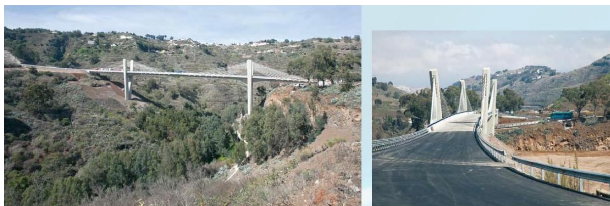
Viaducto ejecutado en Barranco de Teror. Fuente Revista de Consejería de Obras Públicas y Transportes del Gobierno de Canarias nº 42 octubre 2010
