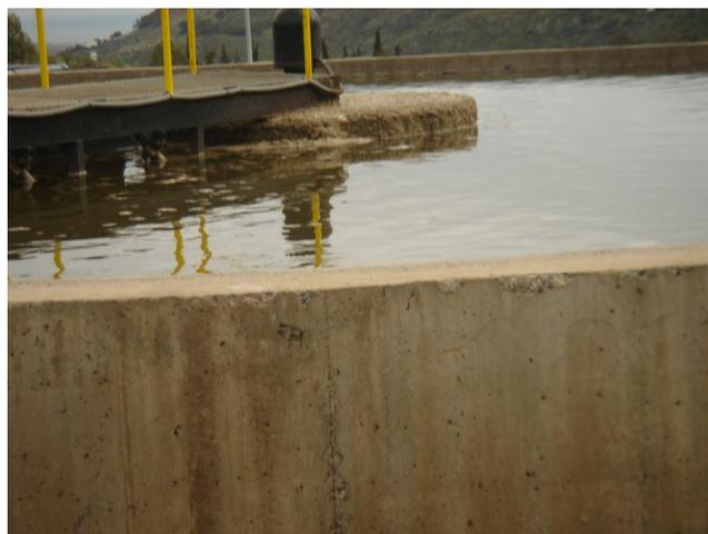
Depósito de afino, mediante filtración por arena tino dual sand.
