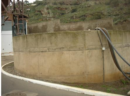
Espesador por gravedad, se queda pequeño. La bomba de fango lo aspira y lo introduce en la centrifugadora.
