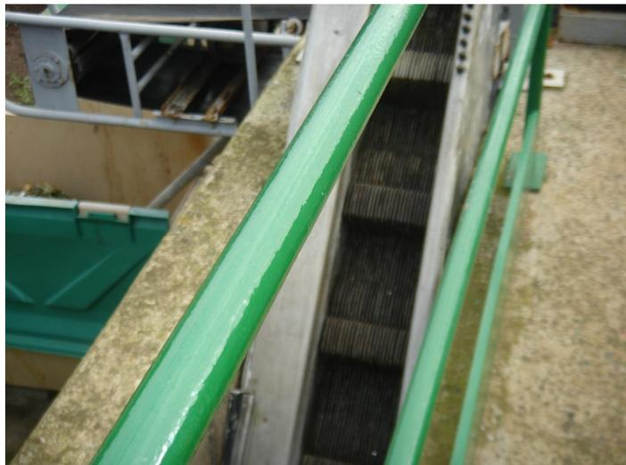
**Cinta transportadora donde se deposita el material cribado en el pretratamiento.**
