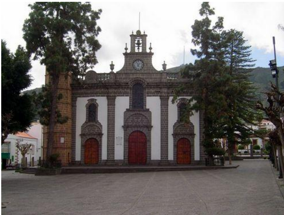
Figura 47. Imagen de puerta principal Basílica.
