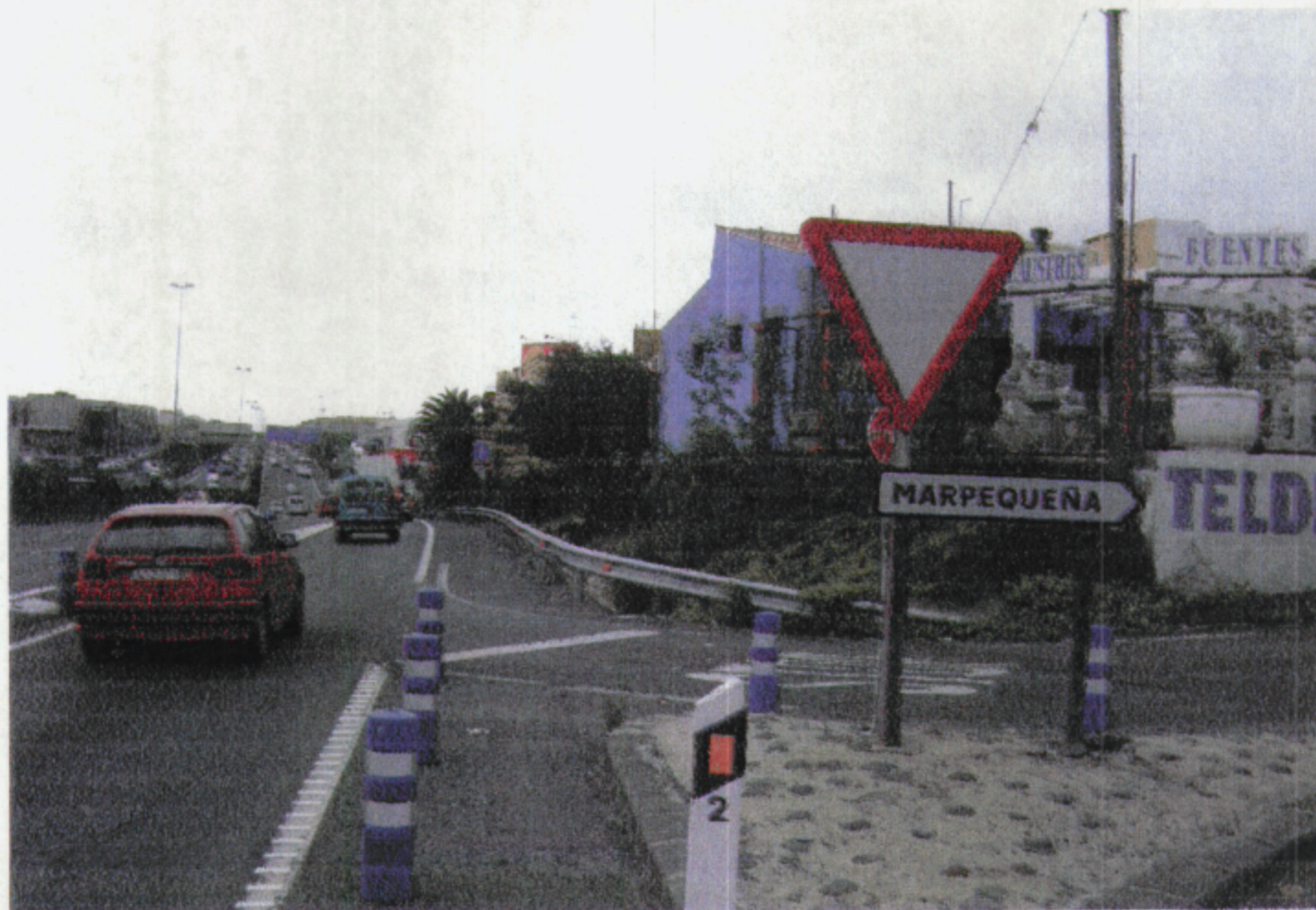
Enlace actual de la calle Capitán Escandel con el carril de aceleración a la GC-1
