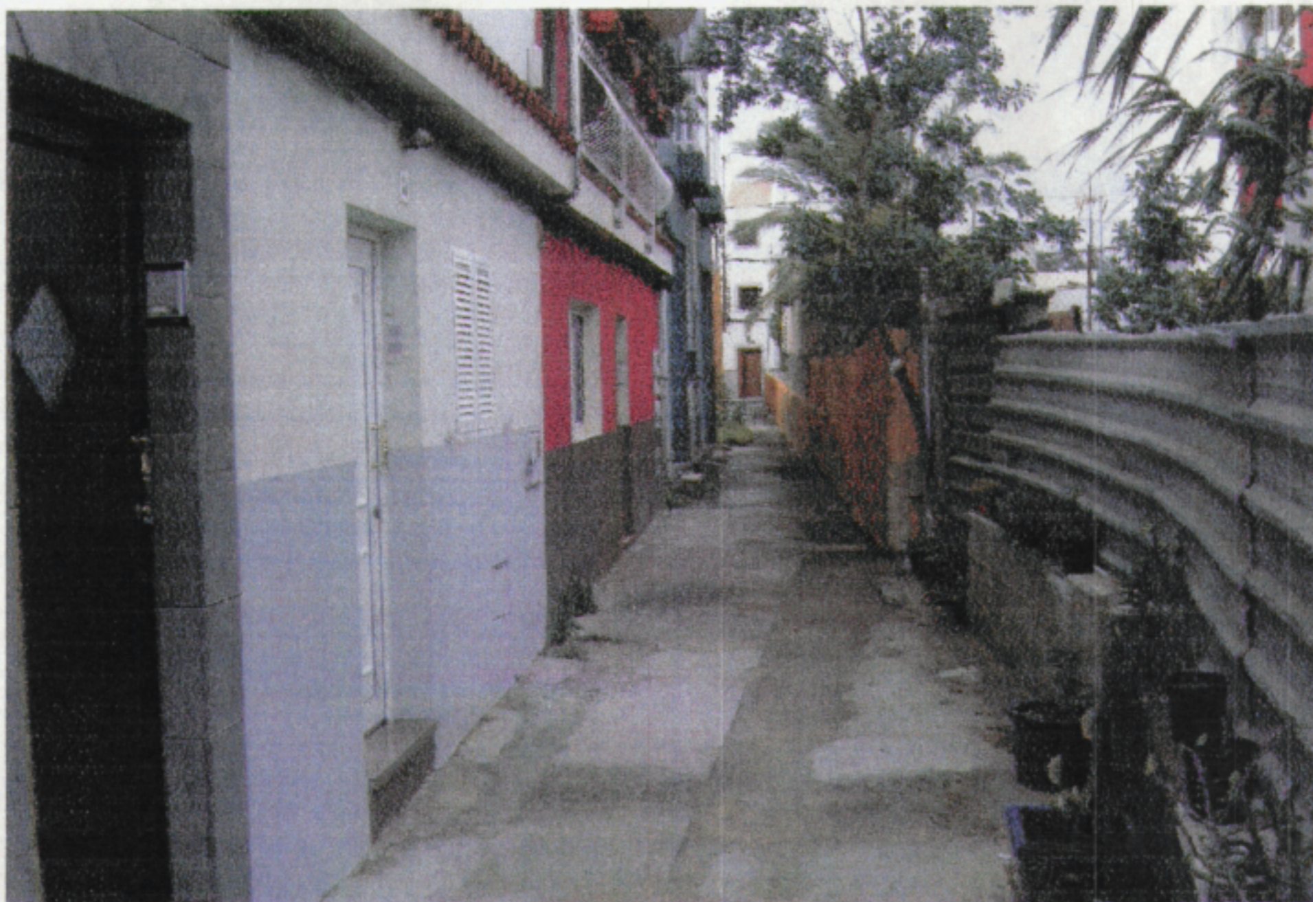
Nuevo vial de carácter peatonal paralelo a la calle Capitán Escandel
