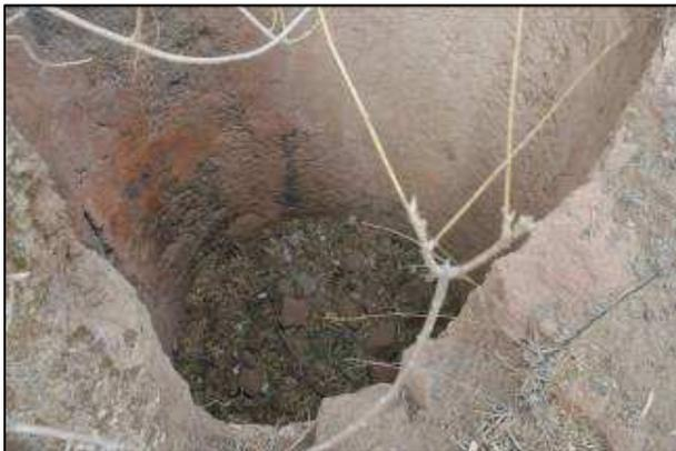
Horno dedicado a la cocción de tejas tradicionales para su utilización en las cubiertas de las construcciones. En su aspecto externo, el horno de tejas suele presentar una estructura troncocónica de piedra muerta y barro y sin techo. Presenta una boca de entrada en la parte superior trasera y otra entrada en la parte inferior delantera. El interior del horno se revestía de barro arcilloso y estaba dividido en dos partes diferenciadas: la *cuba* y el *hogar*.
