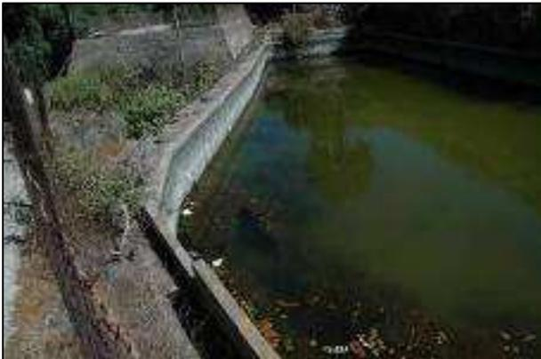
Construcción de variada tipología, planta y tamaño, destinada a remansar y almacenar el agua. Las tipologías varían bastante, pudiendo encontrar los estanques “de obra” realizados a base de grandes muros de piedra con mortero de cal y arena. Así mismo, también pueden estar parcial o totalmente excavados en la roca madre, como es el caso de los estanques-cueva. Otra tipología que también encontramos es el denominado estanque de tierra (también llamado
