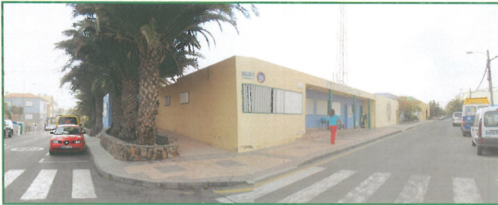
Imagen 4. Edificios del Colectivo "El Zaguán". Ejemplo de equipamientos poco aprovechados en cuanto a la ocupación y edificabilidad del suelo y la obsolescencia de la edificación.
