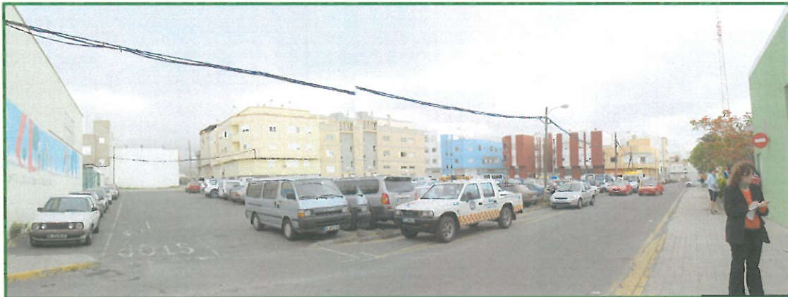
Imagen 6. Zona de aparcamientos junto al Colectivo "El Zaguán". Obsérvese el tendido eléctrico.
