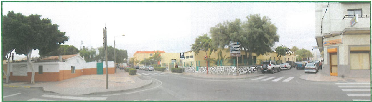
Imagen 5. Panorámica de la confluencia en la zona de equipamientos educativos de la C/ 1º de Mayo con la C/ El Escorial.
