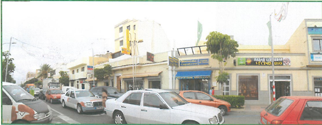
Imagen 1. Avda. de Canarias y ejemplo de edificación obsoleta y discordante en tipología.
