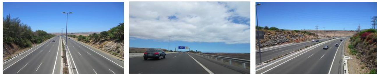
Autopista GC-1. Fuente: Trabajo de campo del presente PMM. Agosto (2014).
