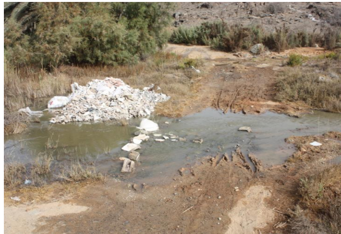
Escombreras en la parte del ámbito de actuación más próxima a Bellavista. Fuente: Trabajo del campo del presente PMM. Agosto (2014).
