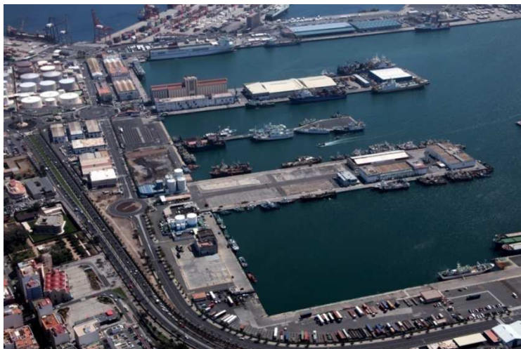
▲ Estado actual de la zona afectada por las modificaciones del viario
