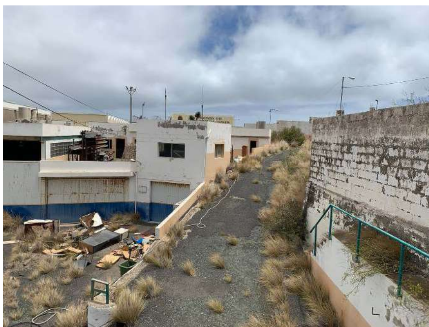
Vista interior de la parcela hacia el Este
