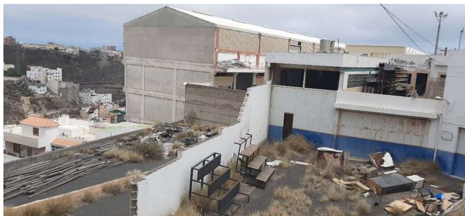
Vista interior de la parcela hacia el lindero noreste
