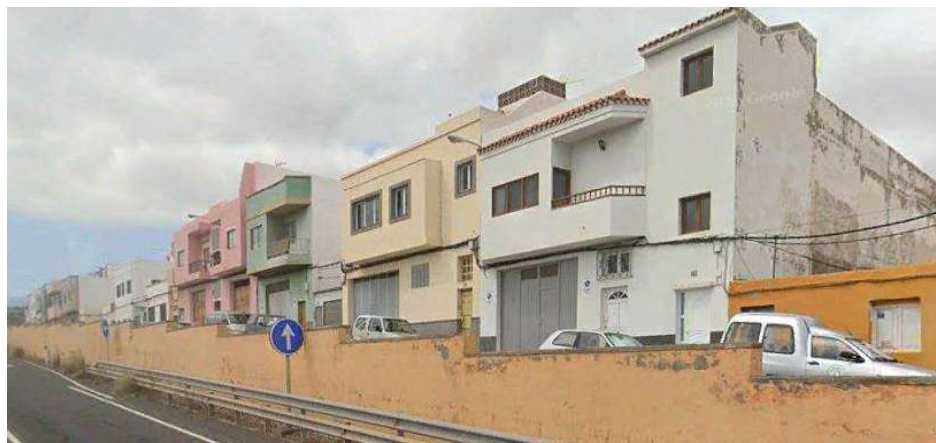
Vista de los edificios colindantes a la Calle Arminda
