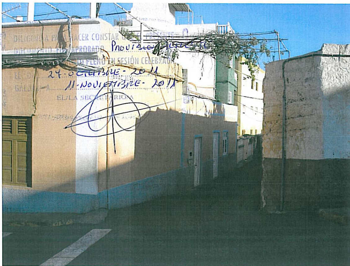
En el ancho de 3,20 metros de calzada existen salidas de viviendas.
