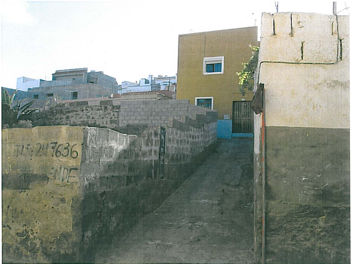
Acceso actual de 2 metros de ancho a viviendas en el interior de la manzana.
