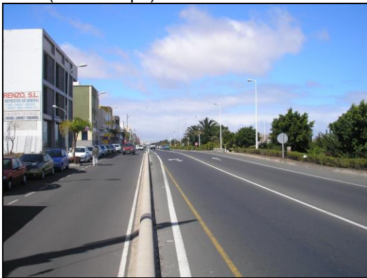
Vista general dirección sur –norte
