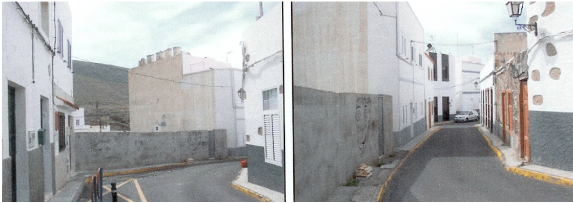
Fachada hacia la calle Guayarmina de la parcela de D. Adrian Cruz Suárez y Dña. Teresa de Jesús Rosario Jiménez. Obsérvese en la imagen el encintado, pavimentación de aceras y alumbrado público.
