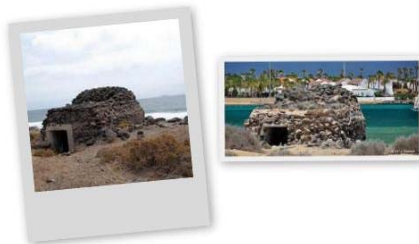
Imágenes de dos de los "nidos de ametralladora" presentes en el ámbito de estudio, concretamente de los situados entre la Playa del Castillo y Las Corcobadas
