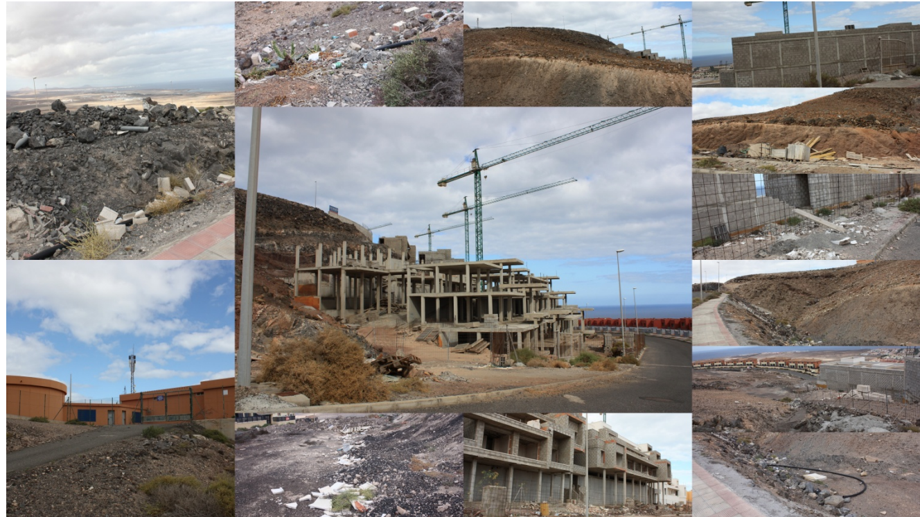
Imágenes de diferentes impactos (Escombros, movimientos de tierra, obras en estado de abandono, vallado inadecuado, antena inadecuada, residuos sólidos urbanos, vallado inadecuado y taludes) en la zona de Montaña Blanca de Abajo
