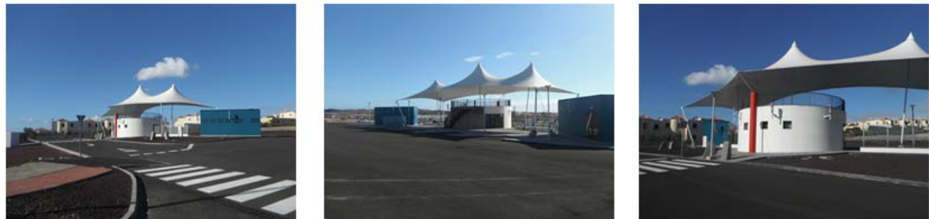
Fotografías de la Parada Preferente de Caleta de Fuste. Estado actual. Elaboración propia
