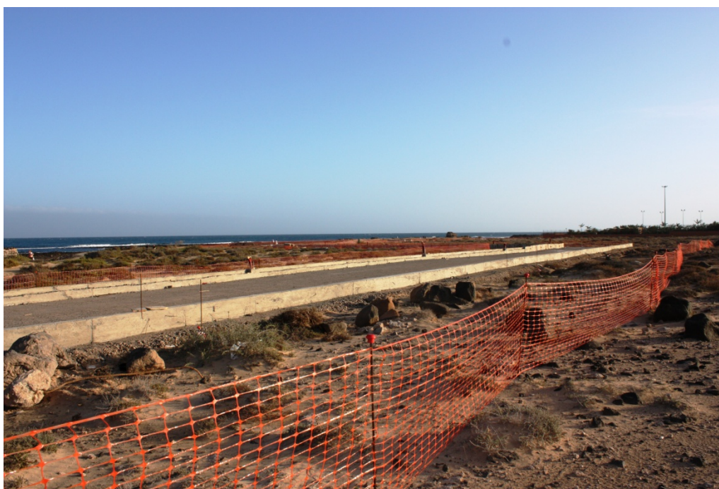
Obras para la conexión del paseo marítimo entre la Playa del Castillo y Las Corcobadas
