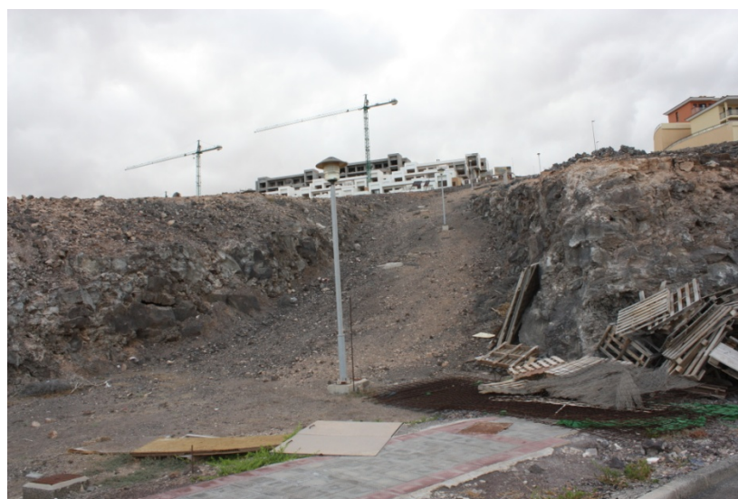
Imagen de la "zanja" provocada por las obras de construcción de la vía peatonal
