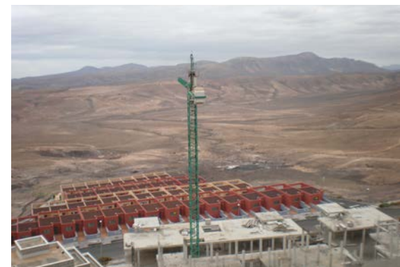
Terminación zona en obras
