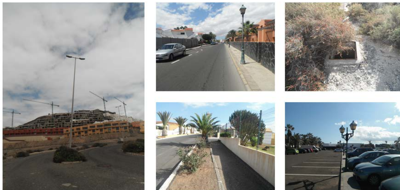
Deficiencias en el alumbrado público. Estado actual. Elaboración propia.
