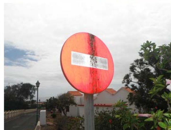
Señales verticales en mal estado de conservación. Estado actual. Elaboración propia
