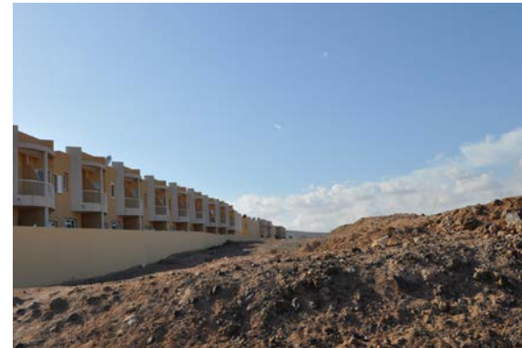
Terminación mediante muro
