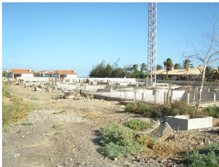
Edificios en construcción abandonados
