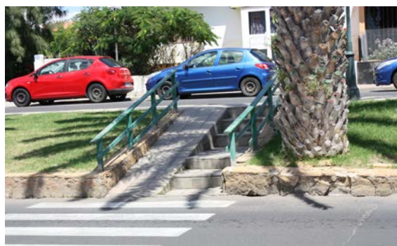
Desdoblamiento de la vía. Calles Alcalde Juan Évora Suárez y Avenida del Castillo – Calle Ajicán
