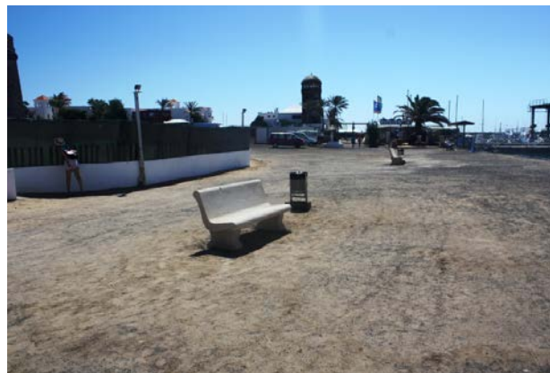
Falta de continuidad del paseo marítimo en la zona del muelle
