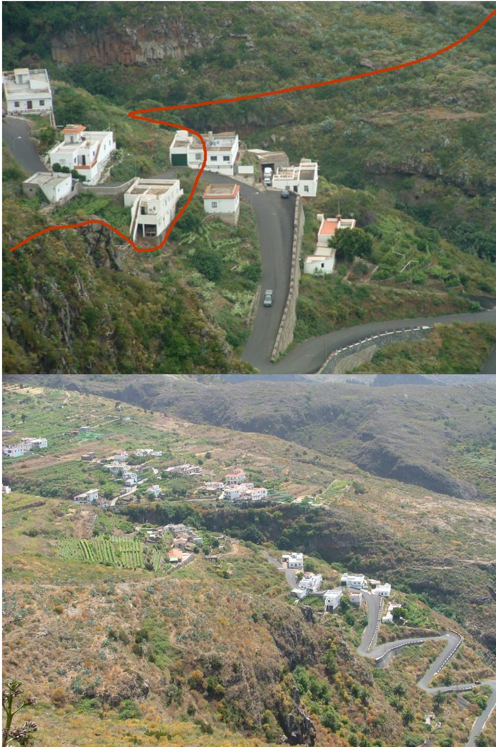
Foto 1: reproducción de las viviendas afectadas por el límite del espacio Protegido. Foto 2: entorno norte del asentamiento rural de Tierra del Trigo
