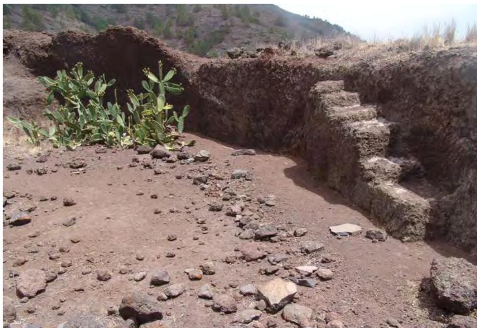
Escaleras modeladas sobre la tosca roja que permitían el acceso al interior del depósito para su limpieza. La profundidad de estos depósitos es escasa apenas superando los 1,5 mts.
