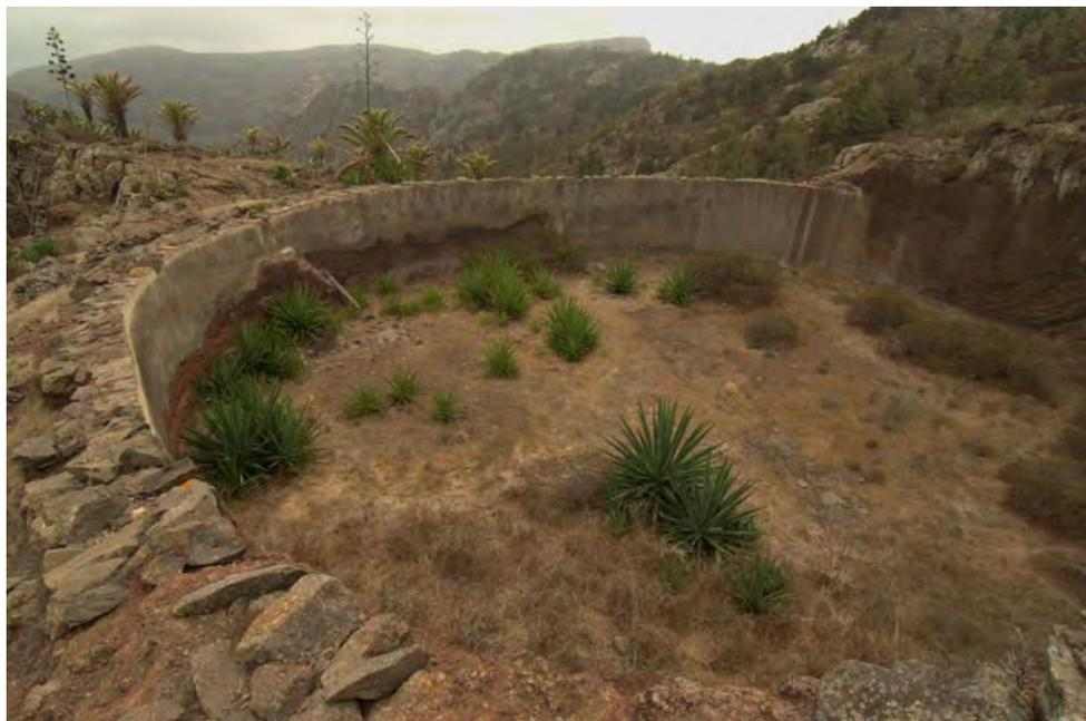
Estanque excavado con enfoscado interior de arena y cal que recubre la cara correspondiente al muro. En este caso la hondonada excavada se remata con un muro de contención semicircular bastante grueso que da forma al depósito.
