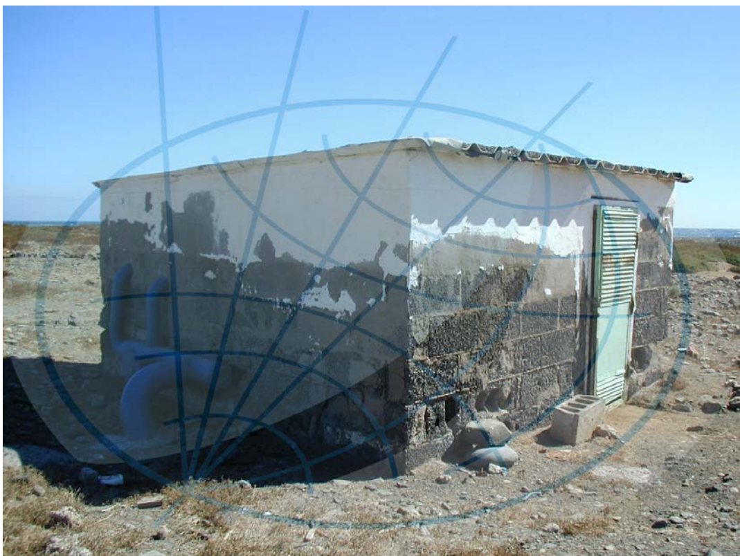
Foto 10. Caseta de bombeo fuera de uso perteneciente a la industria conservera de tomates.
