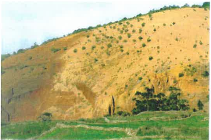
Procesos erosivos en ladera, carcavas
