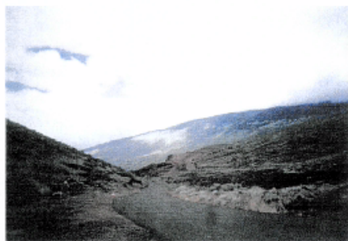
Asfaltado de pistas
