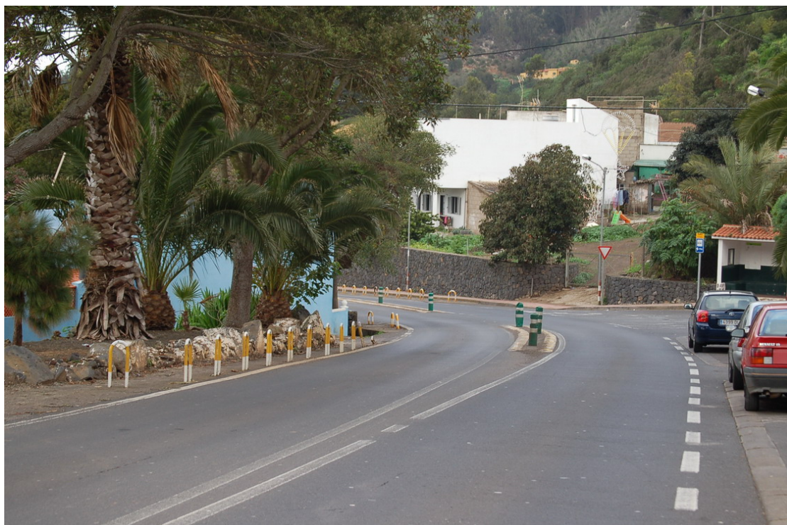
Tramo de Travesía en la TF-154. El Portezuelo
