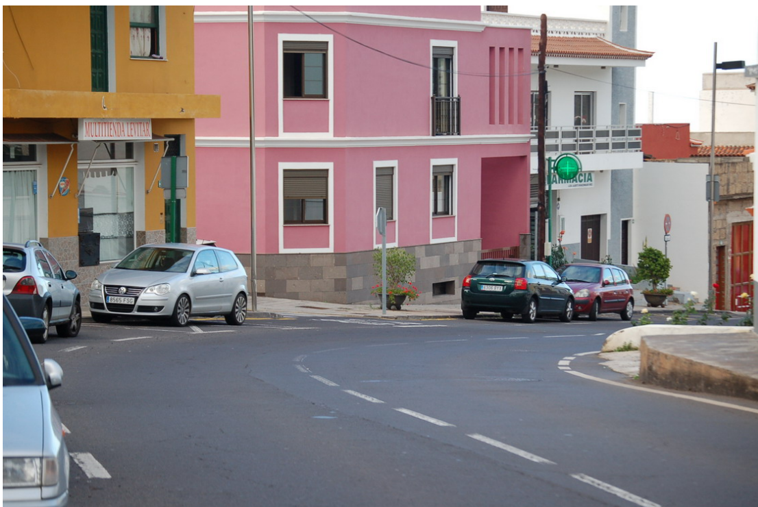
Tramo de Vía exterior, futuro tramo de vía urbana básica, en El Socorro
