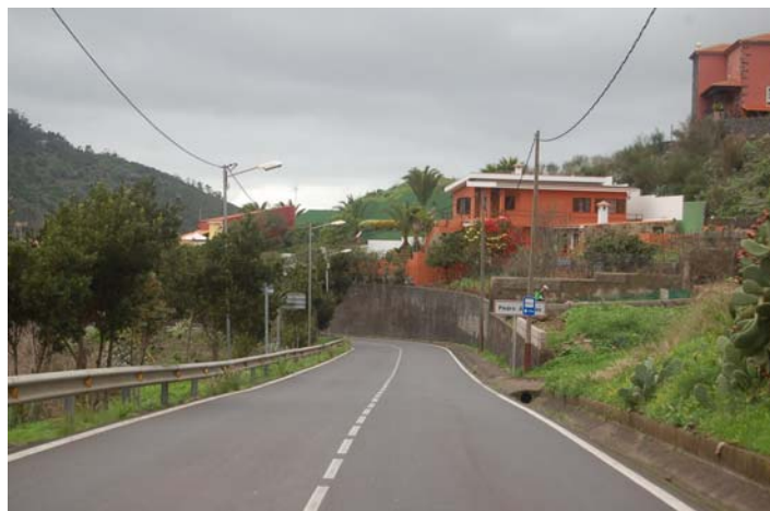
Foto N° 29: Ausencia de acerado en la TF-141
