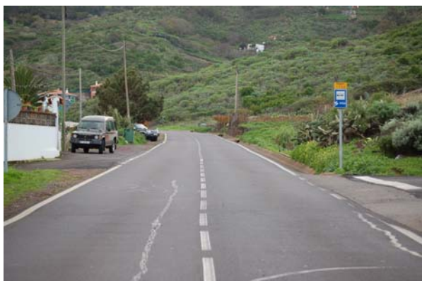
Foto N° 12: Ausencia de acerado en la TF-154
