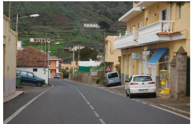
Foto N° 22: Zona comercial en Pedro Álvarez. Ausencia de acerado continuo
