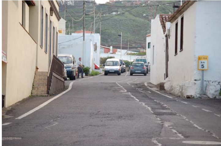
Foto N° 14: Tramo de escasa sección de vía, sin acerado, limitante para el tránsito de los peatones
