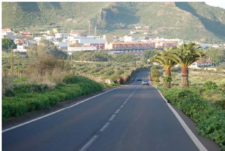
Foto Nº 6: Tramo inferior de la TF-154
