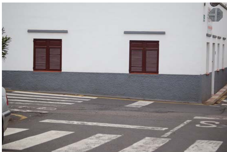
Foto N° 43: Cruce peligroso en el casco
