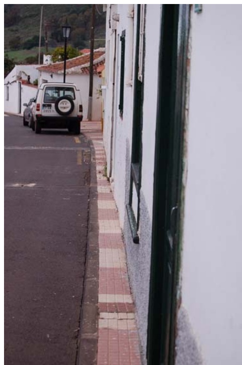
Foto N° 10: Acera de mínima sección en la Calle La Audiencia
