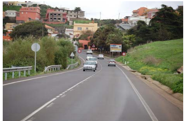
Foto N° 28: Zona sin acerado en la TF-13. Tramo Las Canteras – Cuesta de San Bernabé
