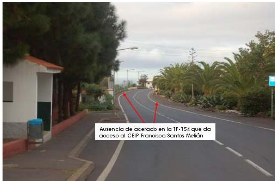
Foto N° 15: Ausencia de acerado en TF-154 en las proximidades del CEIP Francisca Santos Melián
