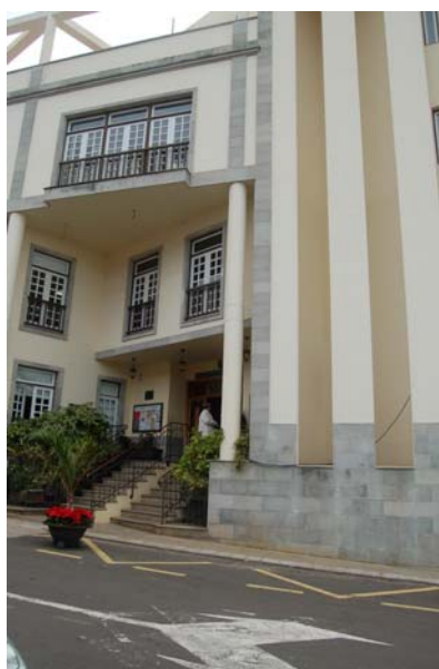
Foto N° 40: Edificio donde se ubica el Teatro Príncipe Felipe y la biblioteca pública
