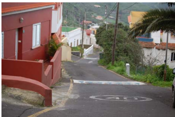
Foto Nº 3: Ausencia de acerado en el Camino de Jesús. El Portezuelo
