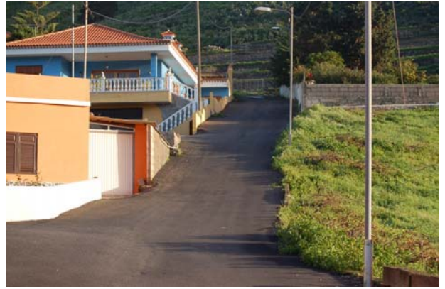
Foto N° 20: Camino Los Barriales
