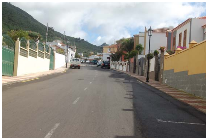
Foto N° 31: Plazas de aparcamiento en superficie. Calle La Audiencia
