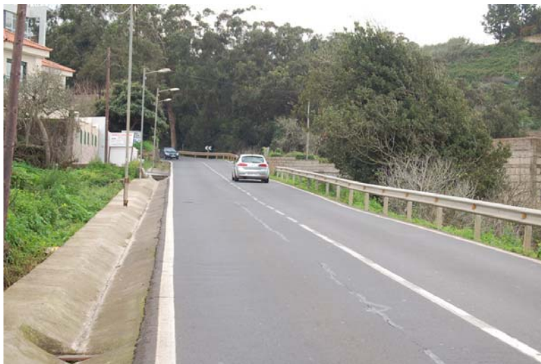
Foto N° 4: Tramo superior de la TF-154 (El Portezuelo)
