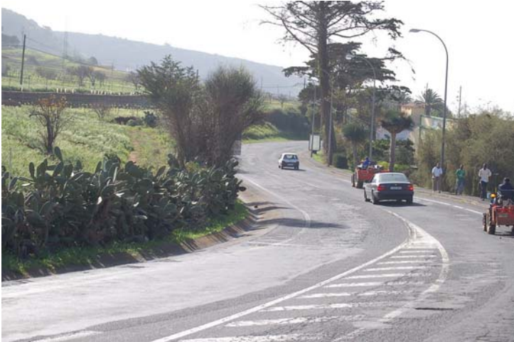
Foto N° 1: Tramo de la TF-13 con características de carretera convencional
