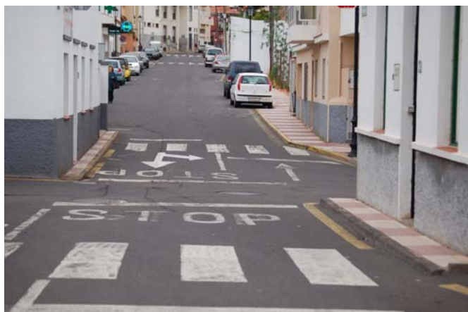
Foto Nº 2: Acerado estrecho en Calle El Carmen, en el cruce con las calles Audiencia y Los Pobres
