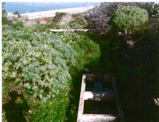
Foto 21: Tanquilla de distribución de agua en el barranco de San Juan.
