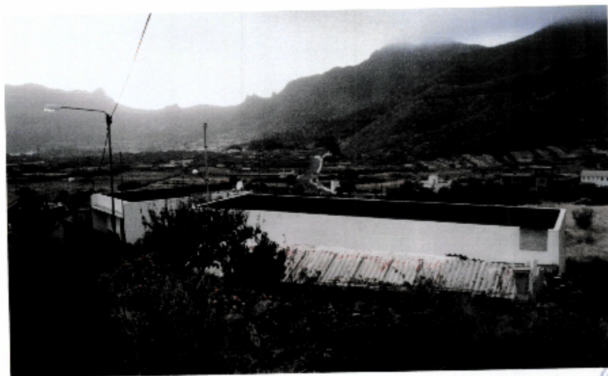
Cómo la edificación se va colocando en pendiente.
