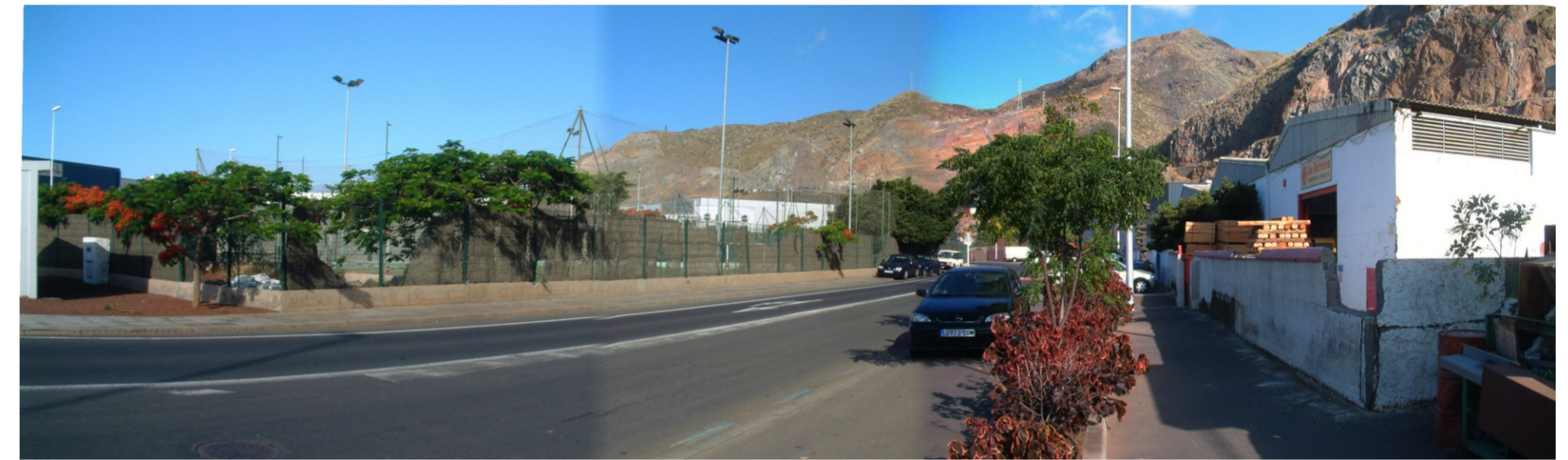
Vista panorámica donde se observa la vía de servicio, instalaciones deportivas y zonas ajardinadas.
