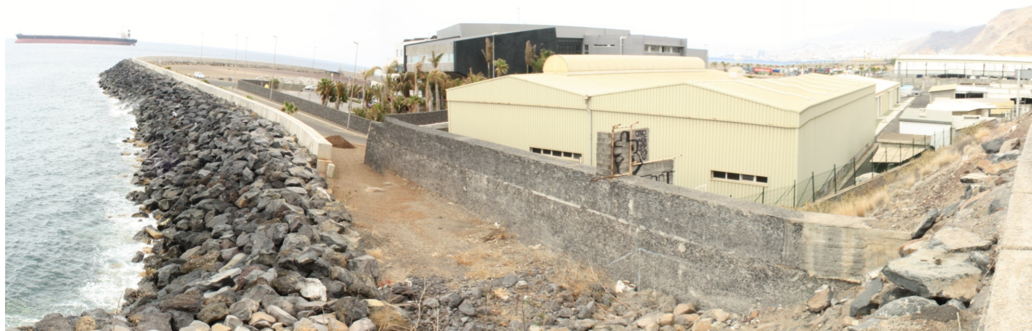
Estado actual del frente de San Andrés, donde se puede observar de fondo las nuevas instalaciones del Instituto Oceanográfico.
