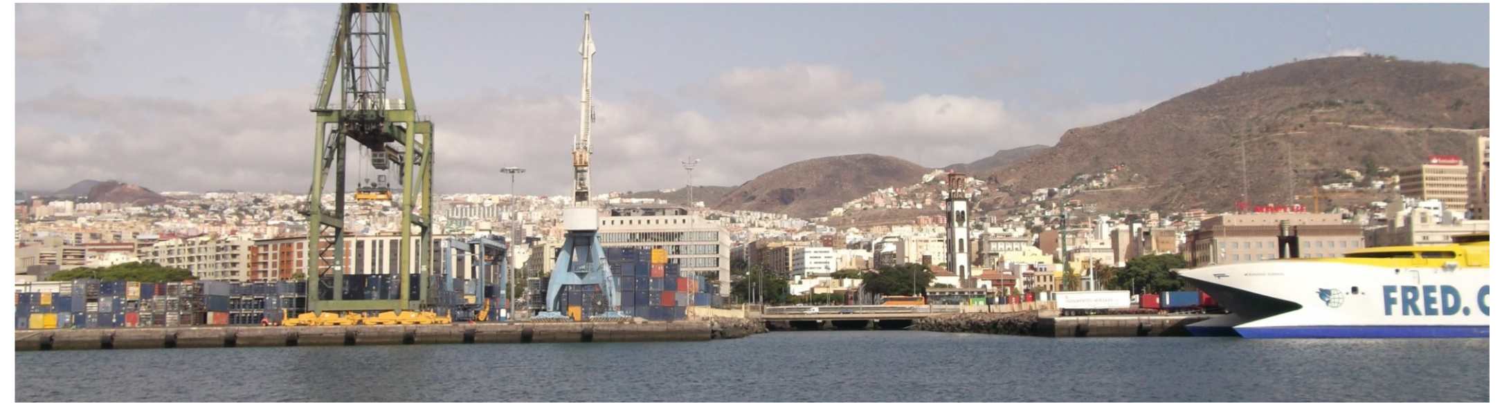
Panorámica de la Terminal de Contenedores, junto a la desembocadura del Barranco de Santos.
