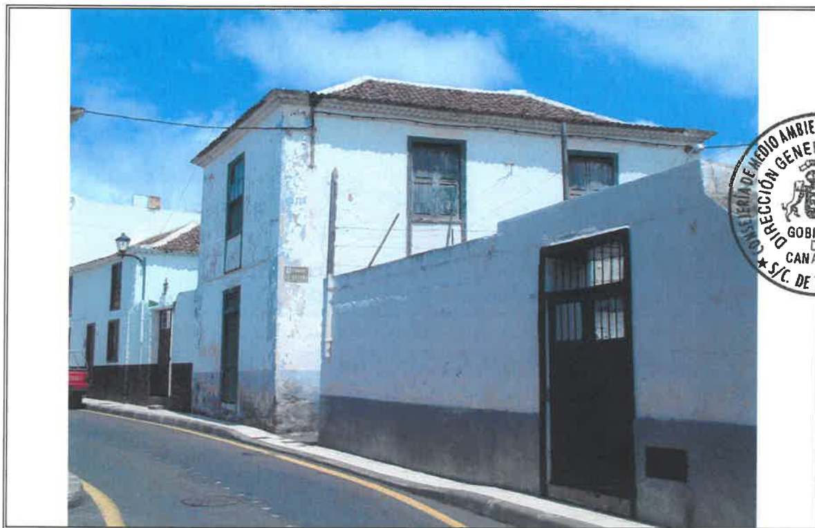
1.1 - Vista general desde la calle Real
