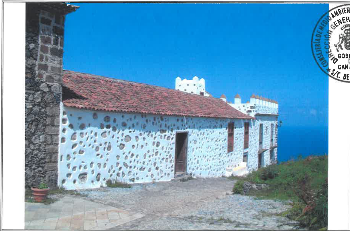
1.2 - Vista parcial del ala noreste
