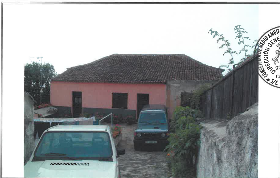
1.1 - Vista general desde el acceso
