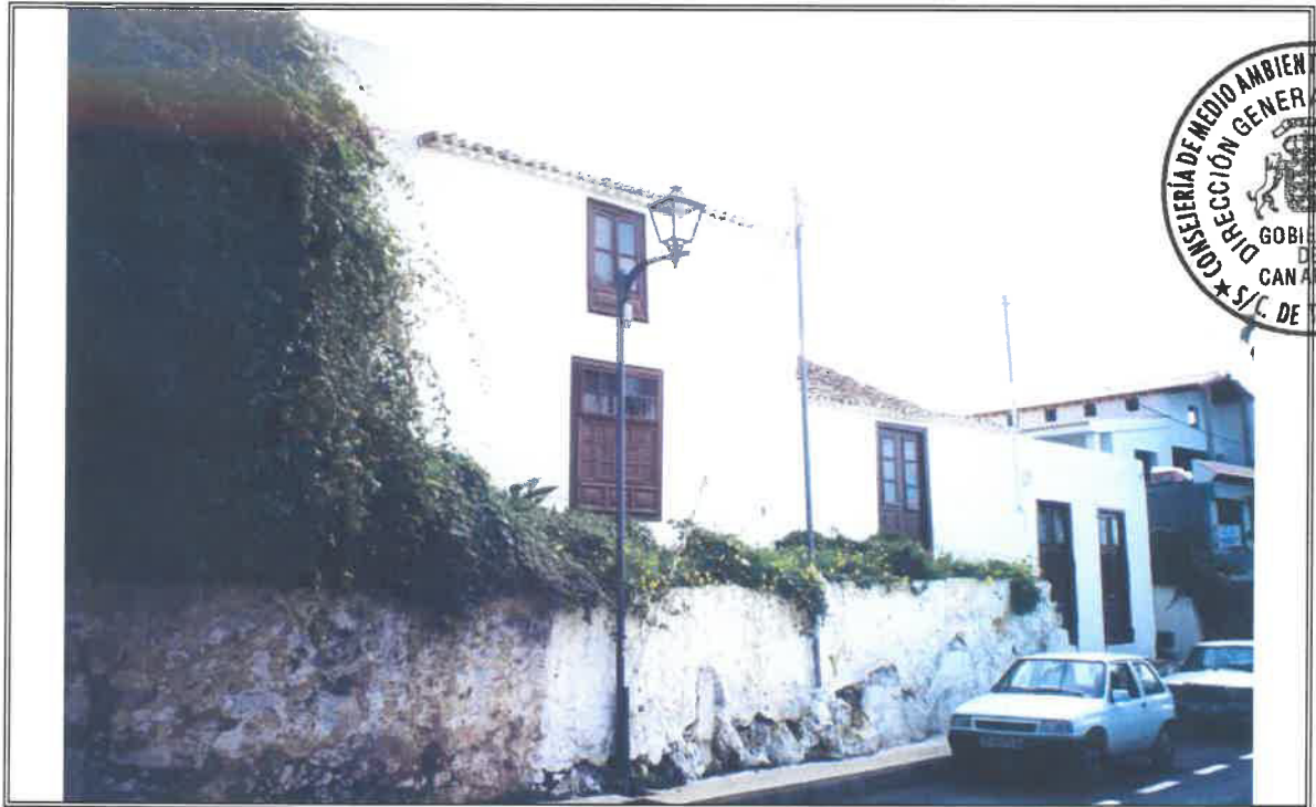
1.1 - Vista general desde la calle Real
