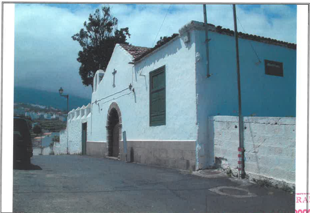
1.2- Vista general desde la calle de acceso
