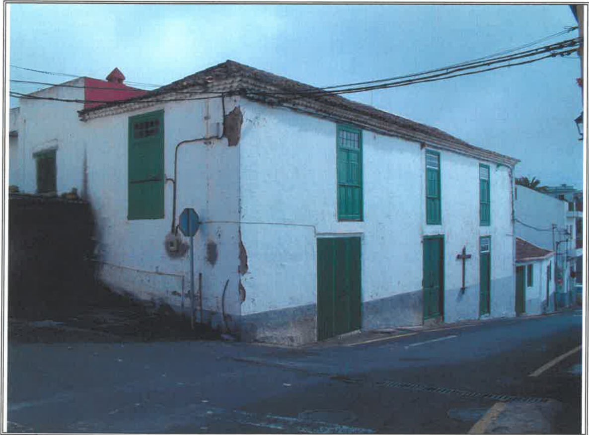
1.1 - Vista general desde la calle Real
