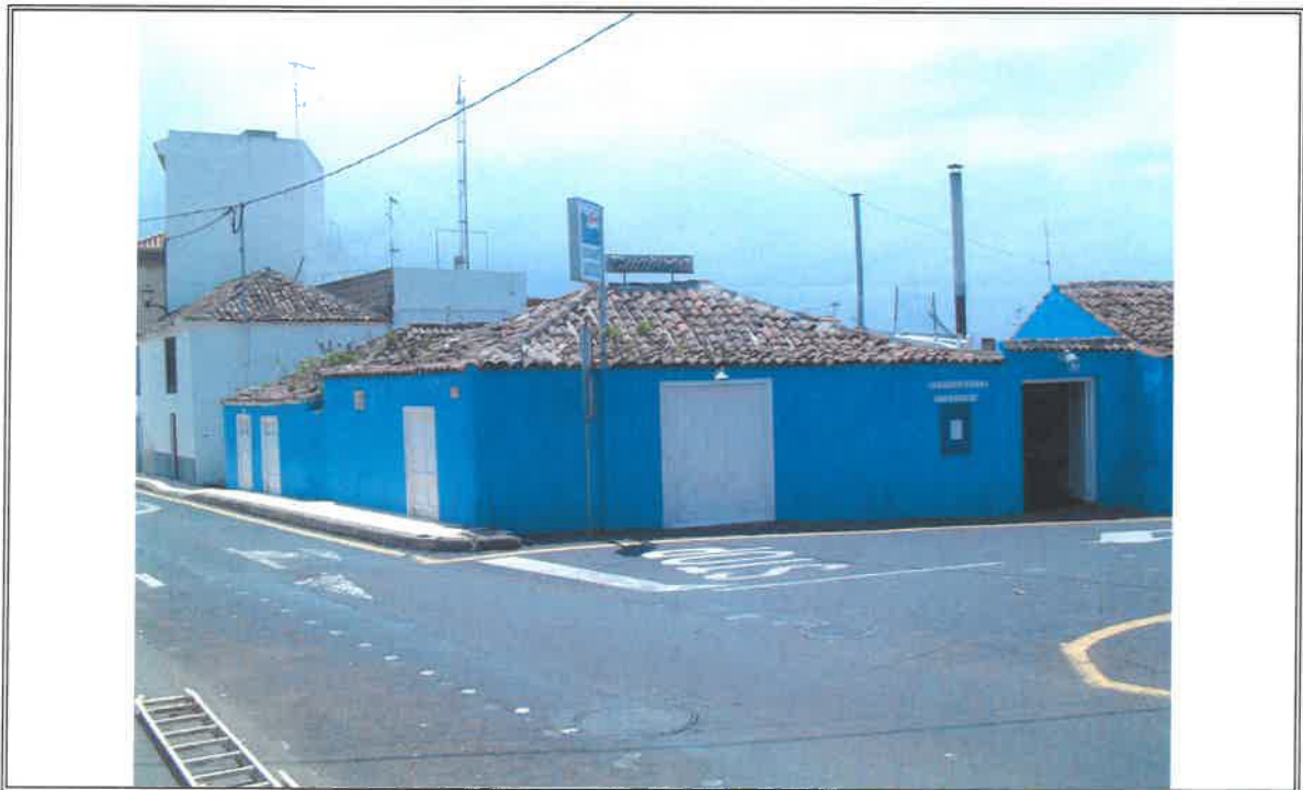
1.2 - Vista general de la fachada a calle Real
