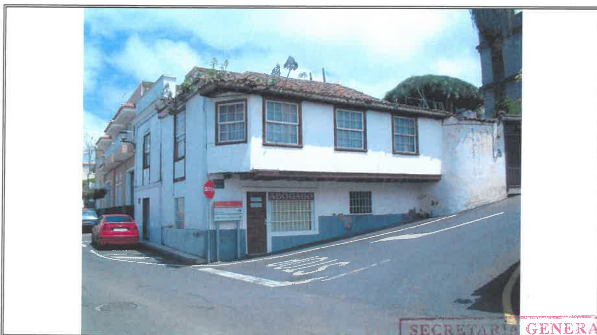
1.2 - Vista general desde la calle Real
