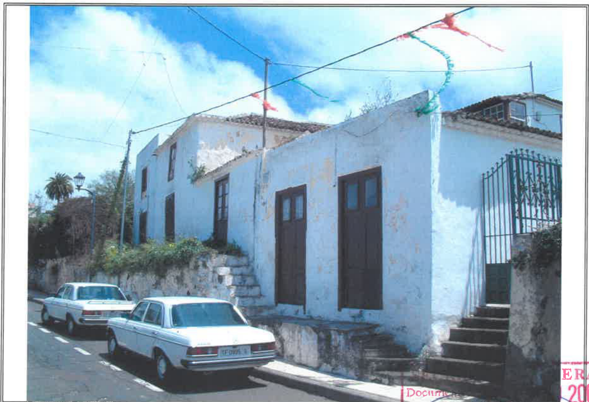
1.2 - Vista general desde la calle Real
