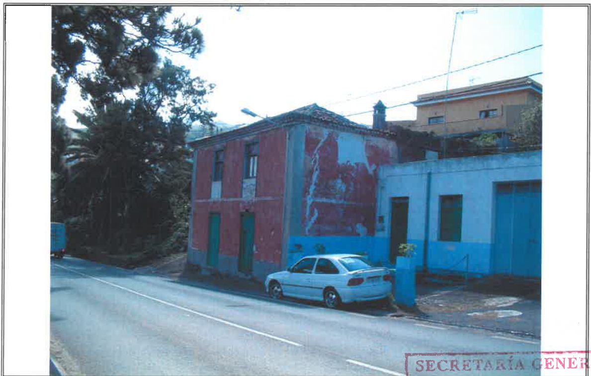
1.2 - Vista general de la fachada a Carretera Insular TF-217
