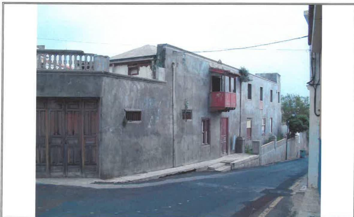
1.2 - Vista parcial desde la calle Real
