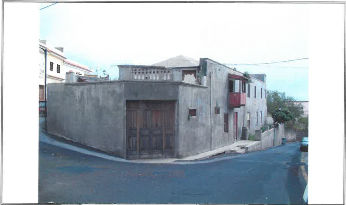
1.1 - Vista general desde la calle Real
