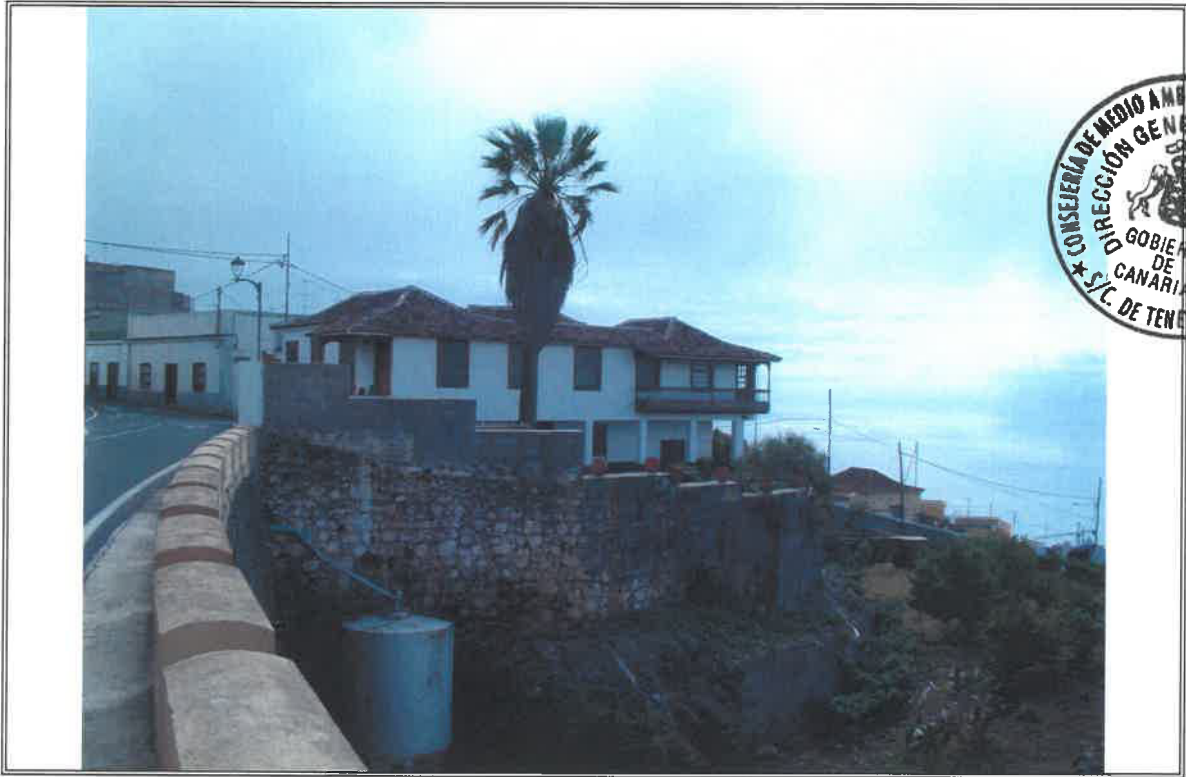
1.1 - Vista general desde la Calle Real
