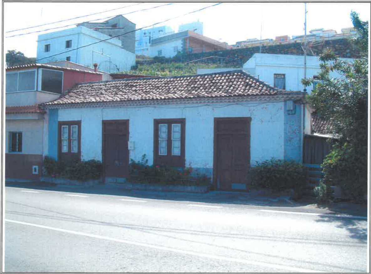
1.1 - Vista general desde la Ctra. Insular TF-217
