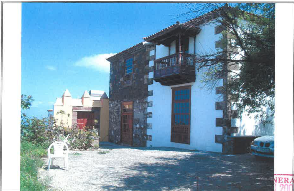
1.3 - Vista parcial de la entrada principal
