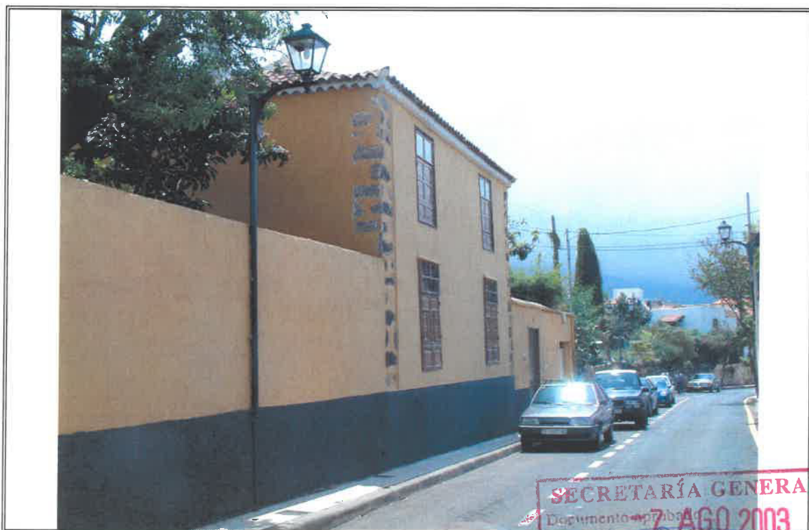
1.2 - Vista general de la fachada a calle Real
