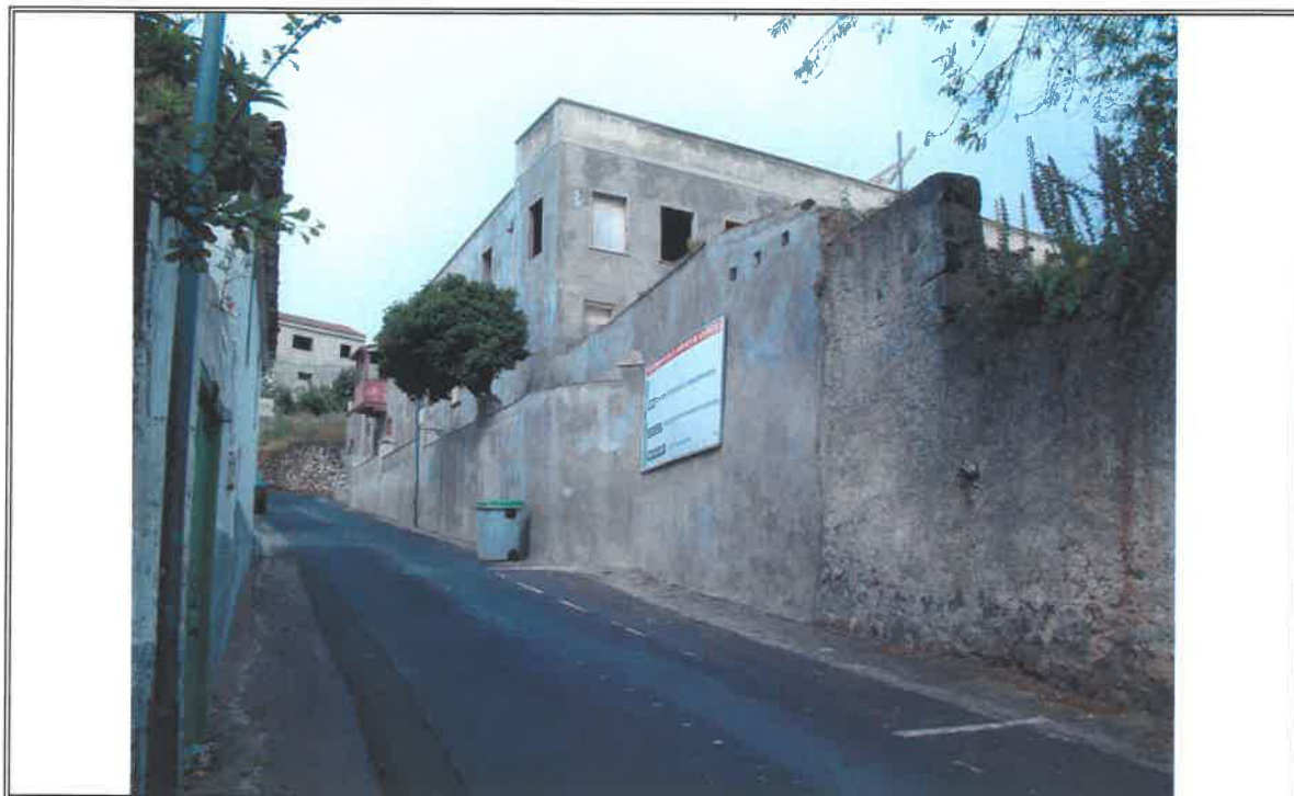
1.1 - Vista general desde la calle Real
