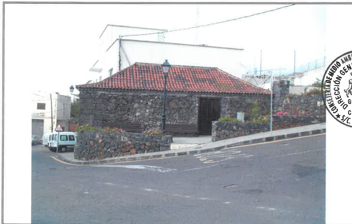
1.1 - Vista general desde el Camino San Antonio
