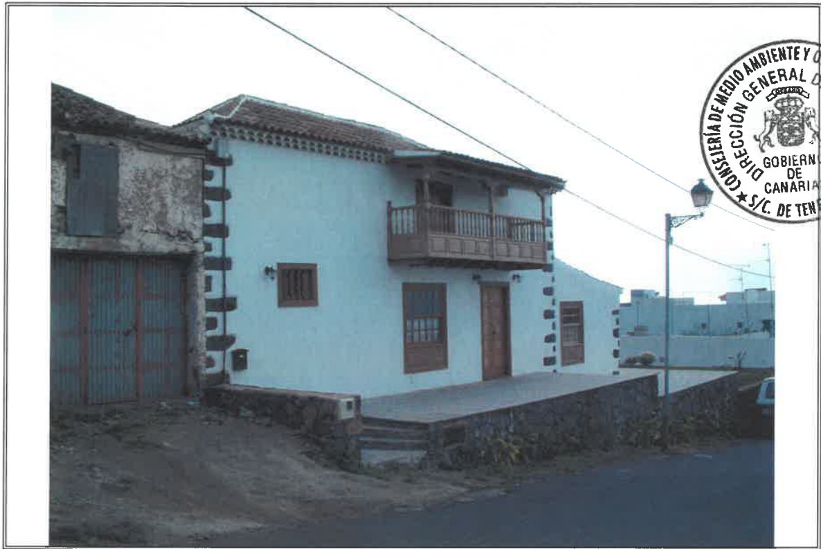
1.1 - Vista general desde la calle Montañés
