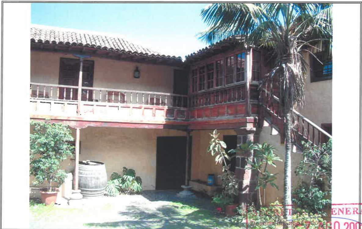
1.4 - Vista parcial desde el patio hacia la galería superior
