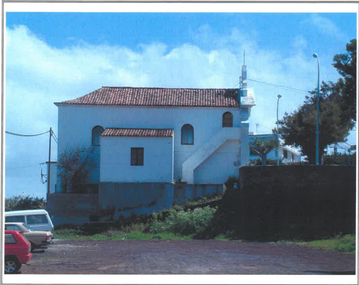
1.1 - Vista general de la fachada suroeste desde Camino Botello
