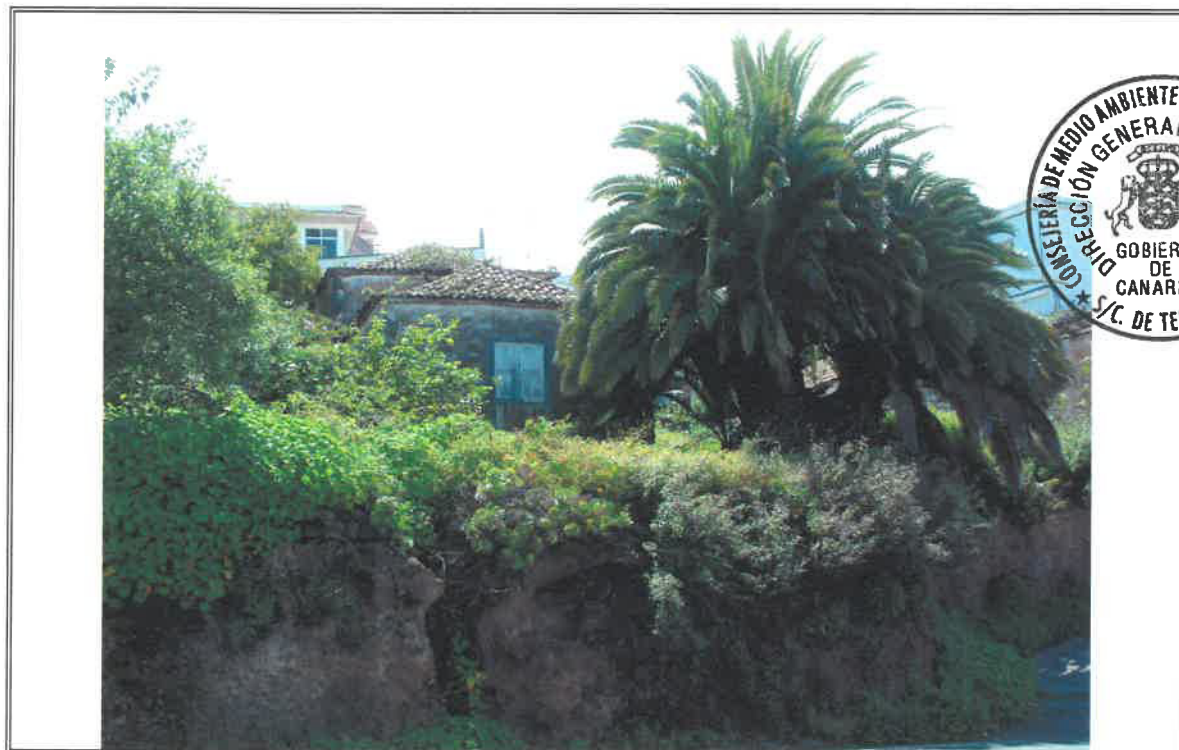
1.1 - Vista general desde la Ctra. Insular TF-217
