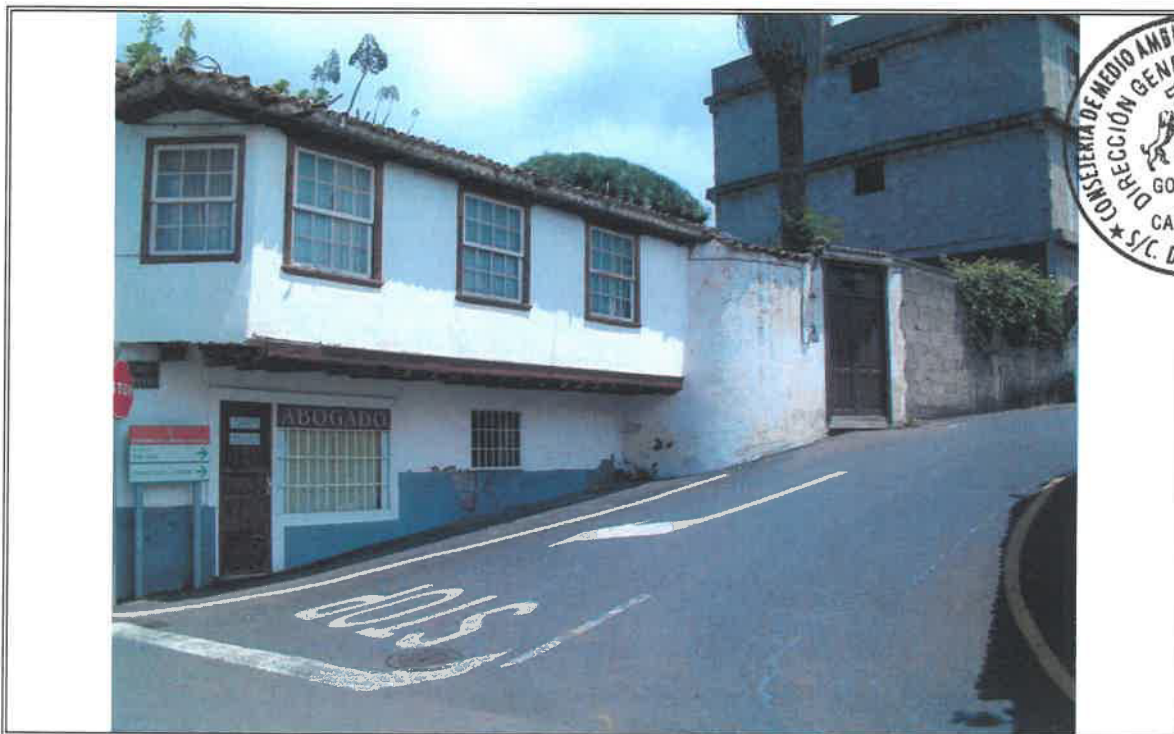
1.1- Vista parcial desde la calle Real
