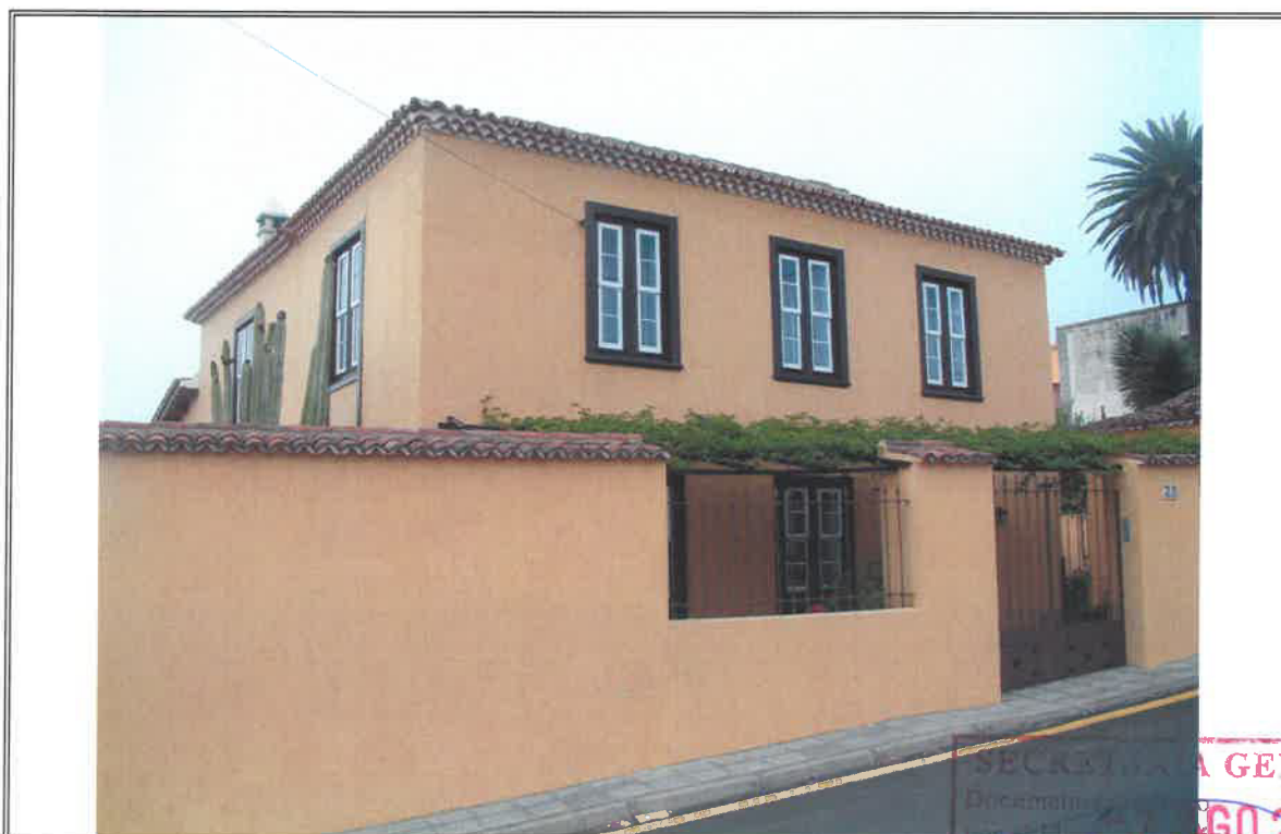
1.2 - Vista general de la fachada a calle Obispo Pérez Cáceres
