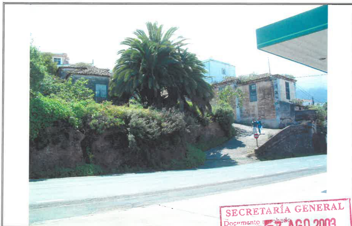
1.2 - Vista general de la Ctra. Insular TF-217
