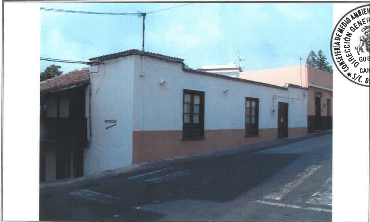
1.1 - Vista parcial desde la calle Real
