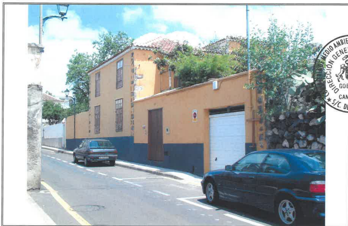
1.1 - Vista general desde la calle Real
