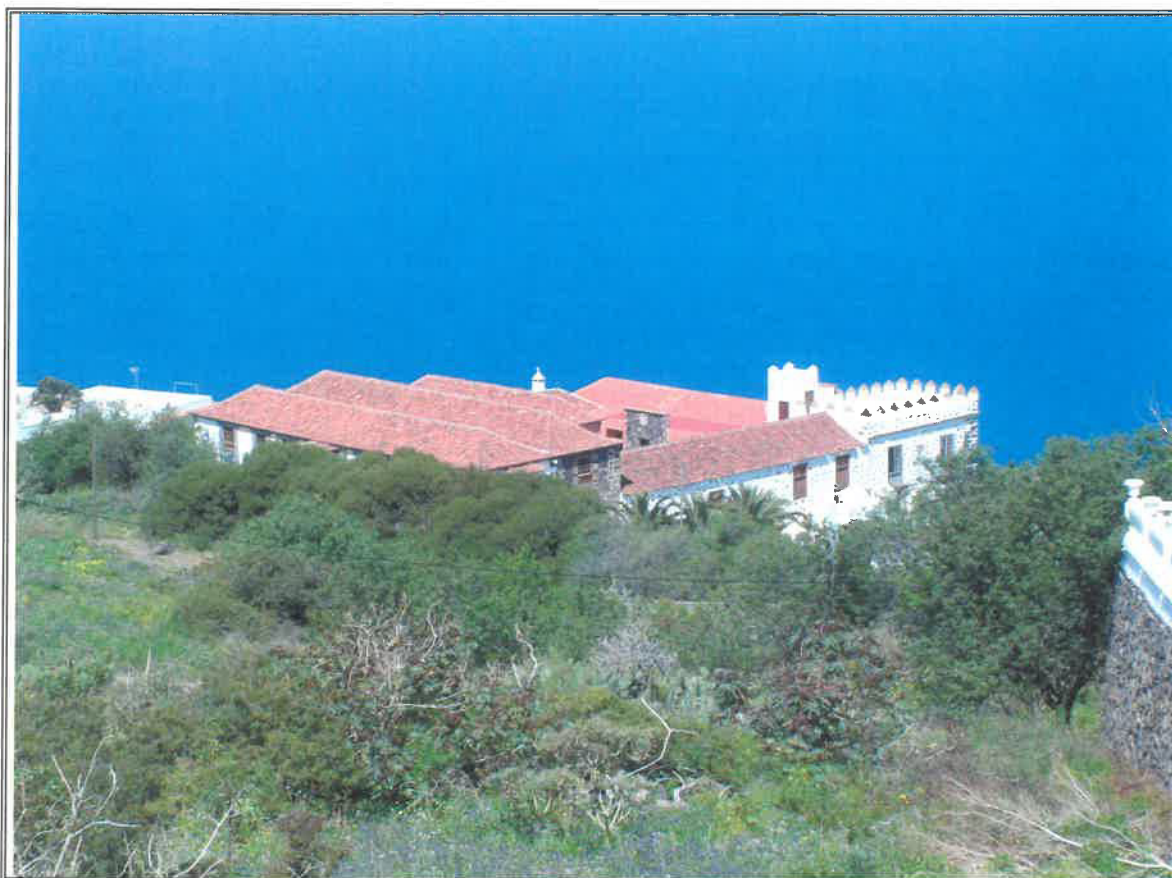
1.1 - Vista general desde la Ctra. Insular TF-217
