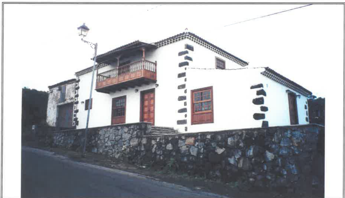
1.1 - Vista general desde la calle Montañés
