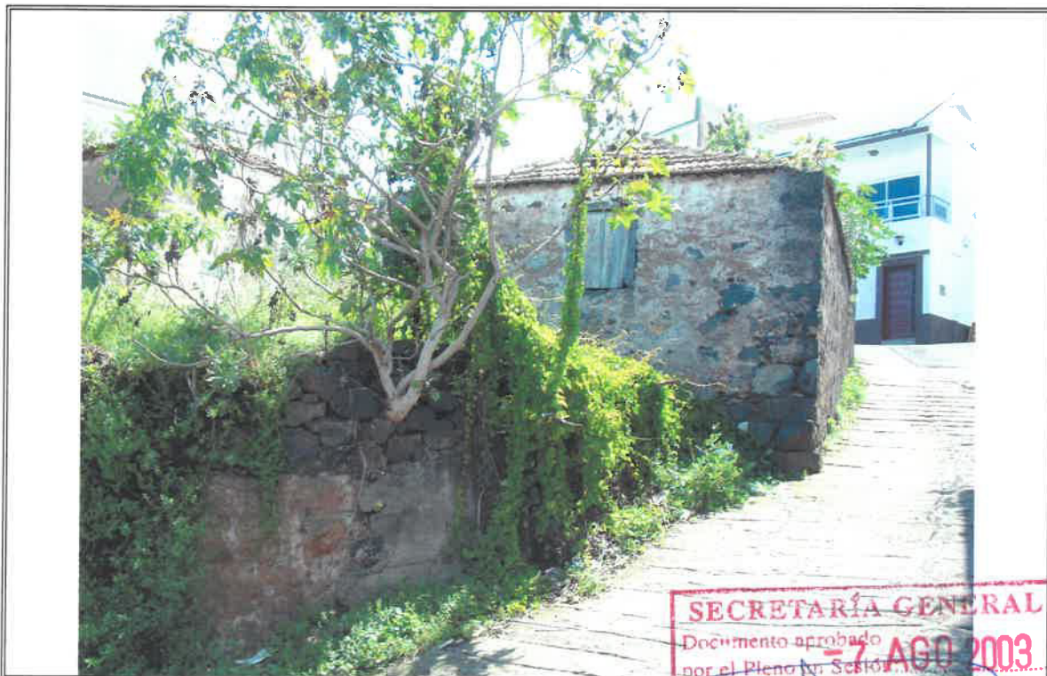
1.4 - Vista parcial desde el acceso por rodadera
