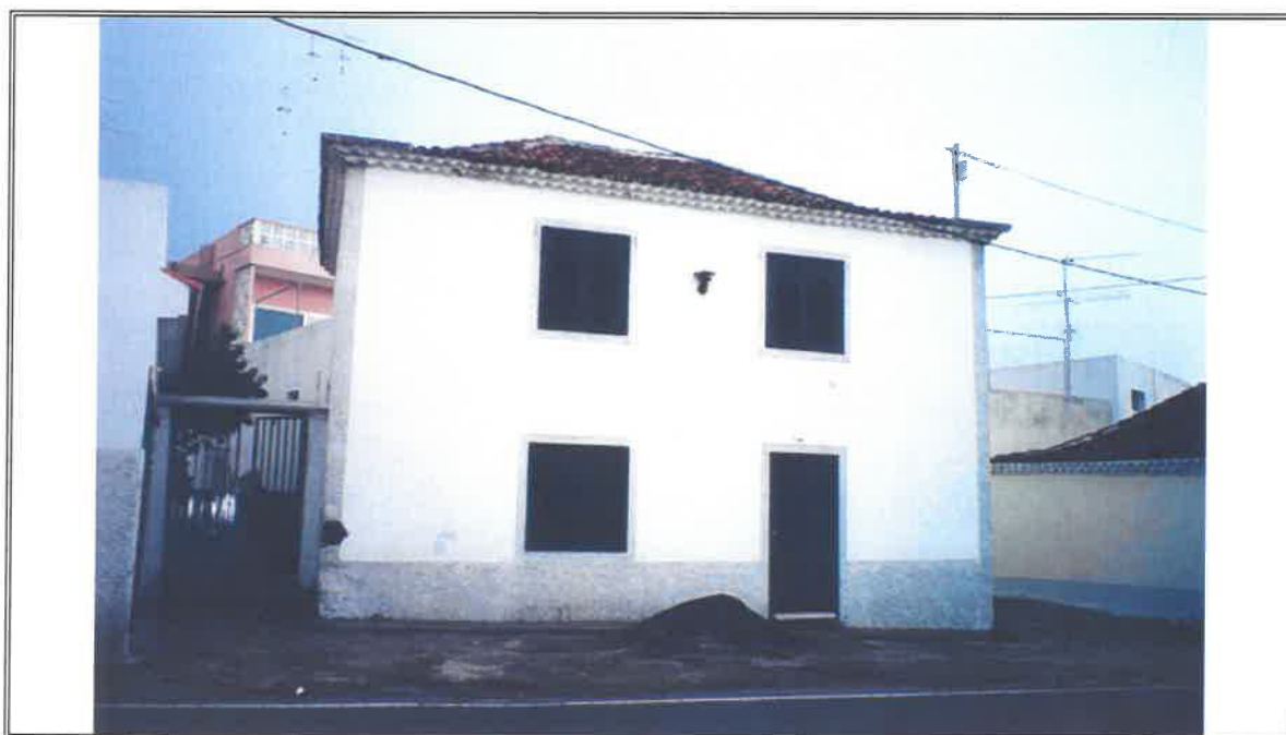
1.2 - Vista general de la fachada a Ctra. Insular TF-217
