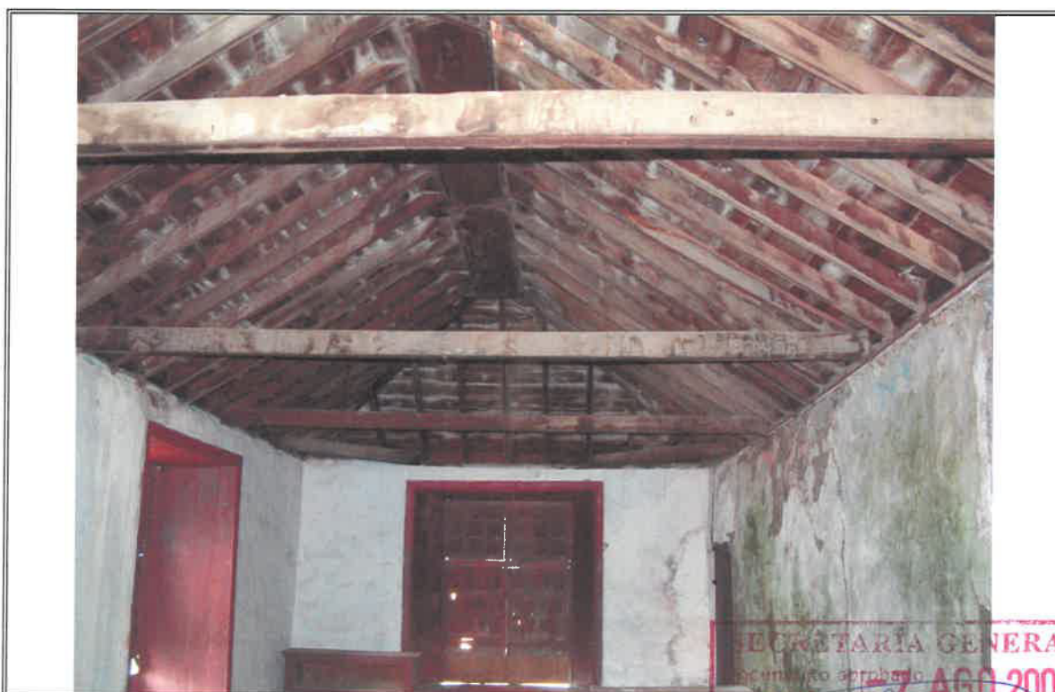
1.5- Vista parcial de la nave superior de edificación adosada residencial
