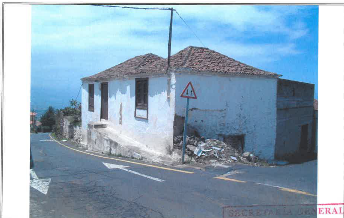
1.2 - Vista general desde la calle Real
