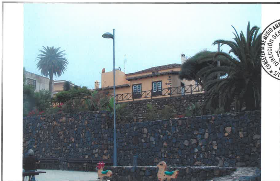
1.1 - Vista general desde el Noroeste
