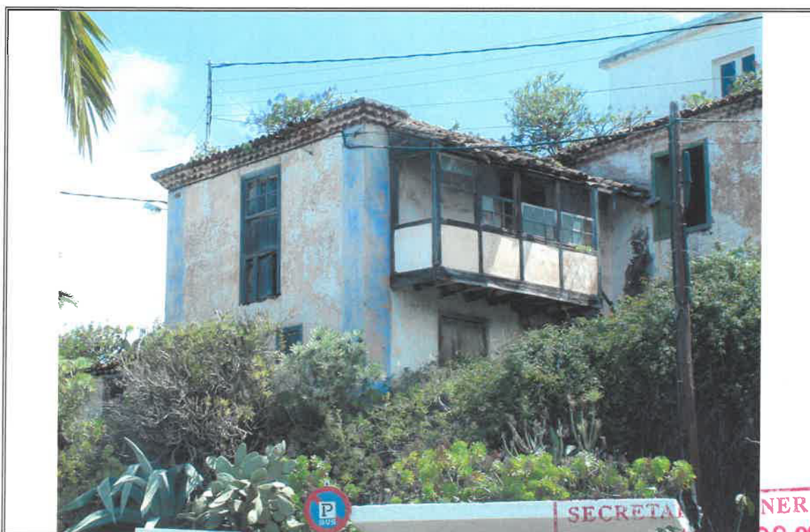
1.4 - Vista general de la fachada a Ctra. Insular TF-217
