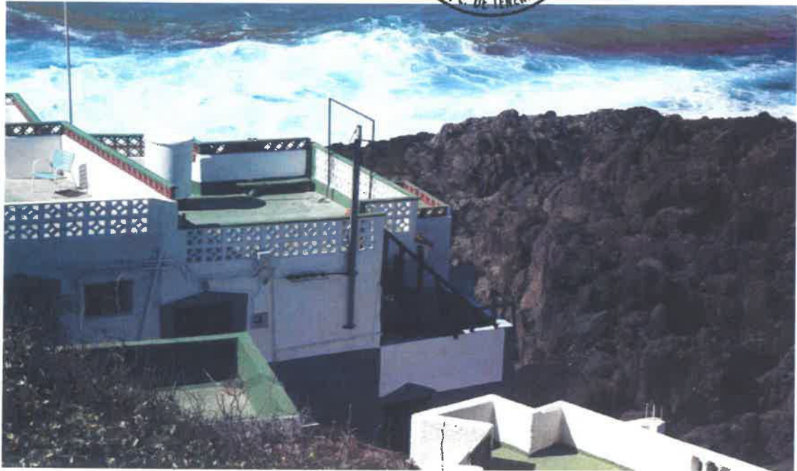
Las edificaciones del núcleo de El Caletón invaden la estrecha franja de abrasión marina del litoral municipal
