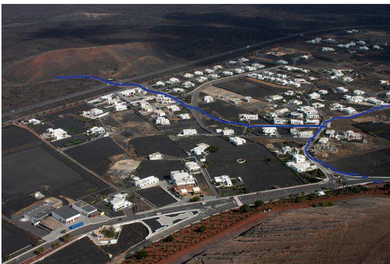
Vista de tramo final de cauce en núcleo de Yaiza
