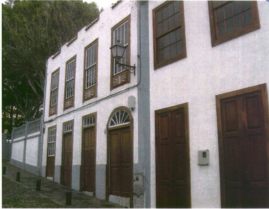
11.1 - Vista general de la fachada a la calle General Franco
