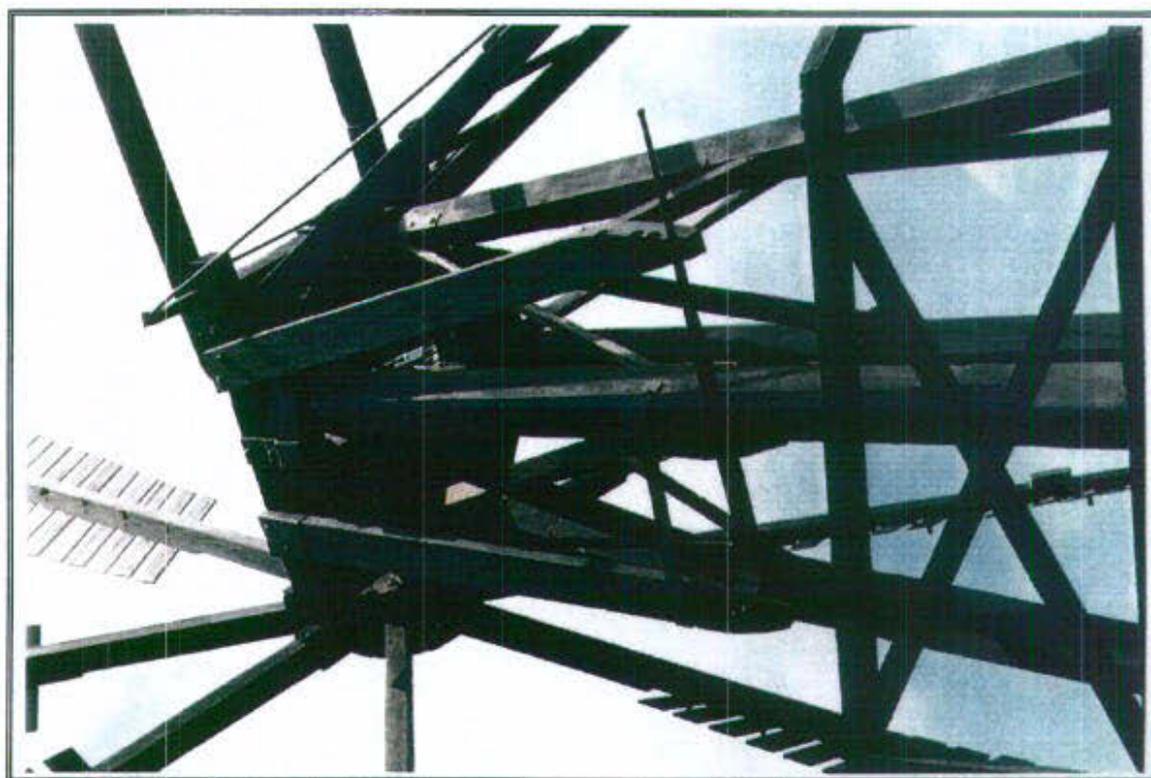
72.3.2 - Detalle de la estructura de carpintería de armar del molino
