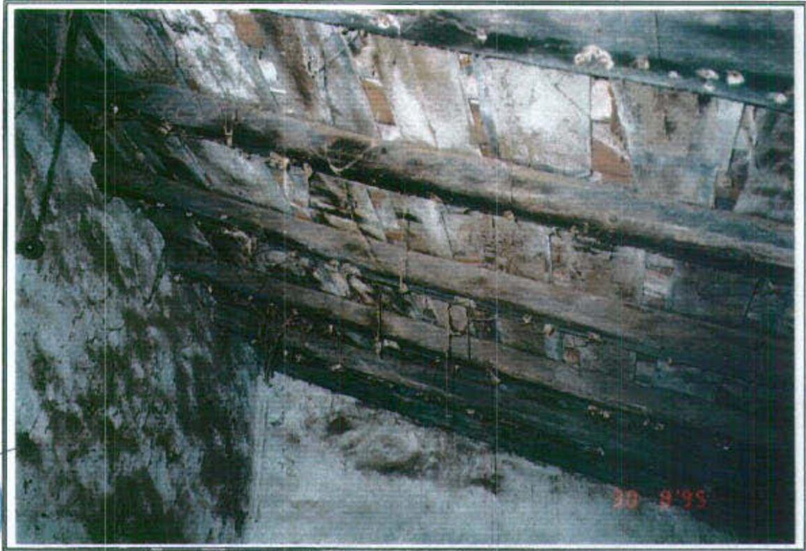
72.4.5 - Detalle de interior de cubierta tradicional, con pares de rollizos
