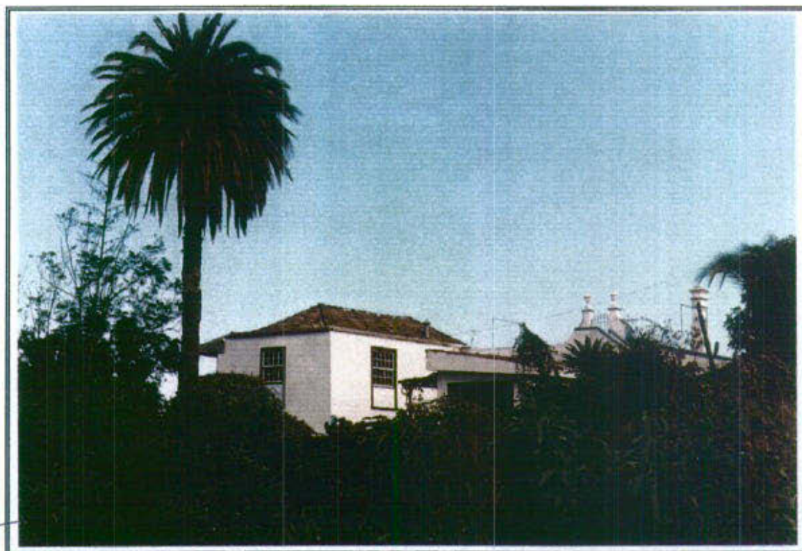
54.1 - Vista general de la edificación desde el Noroeste
