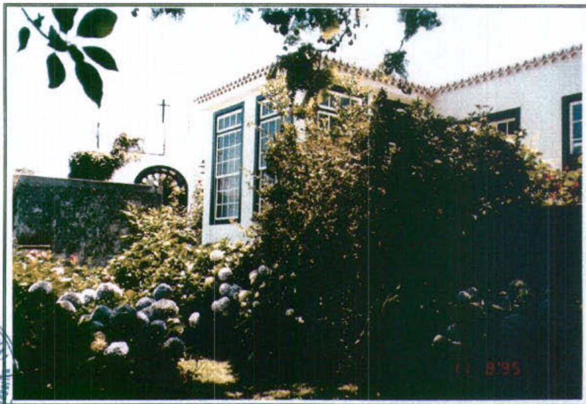
50.1 - Vista general fachada Este y portada de entrada
