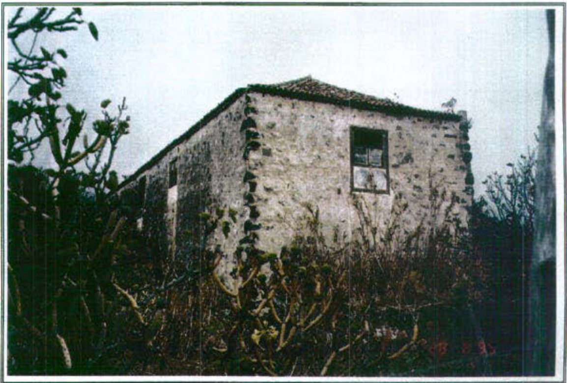
62.2 - Vista general desde el Sureste
