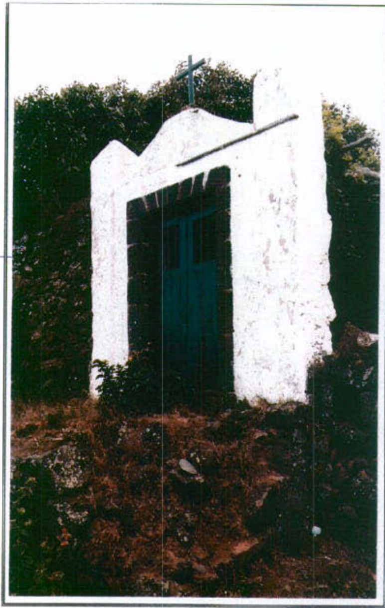
48.1 - Vista general desde el Este
