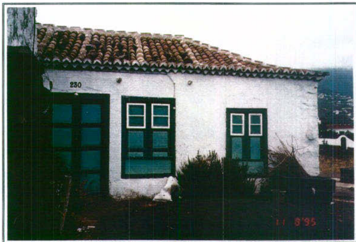
56.4 - Vista parcial de la edificación en su fachada Este
