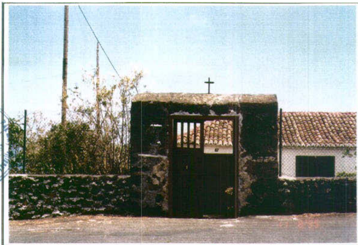
52'.1 - Vista general desde el Oeste
