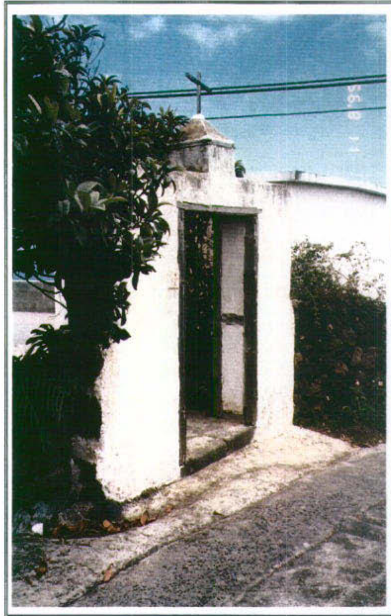
55.1 - Vista general de la portada desde el camino
