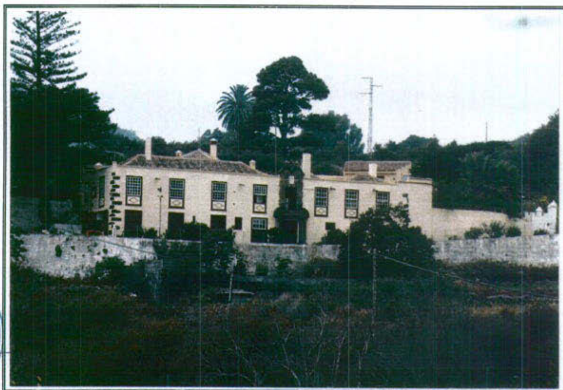
61.1 - Vista general de la fachada Norte
