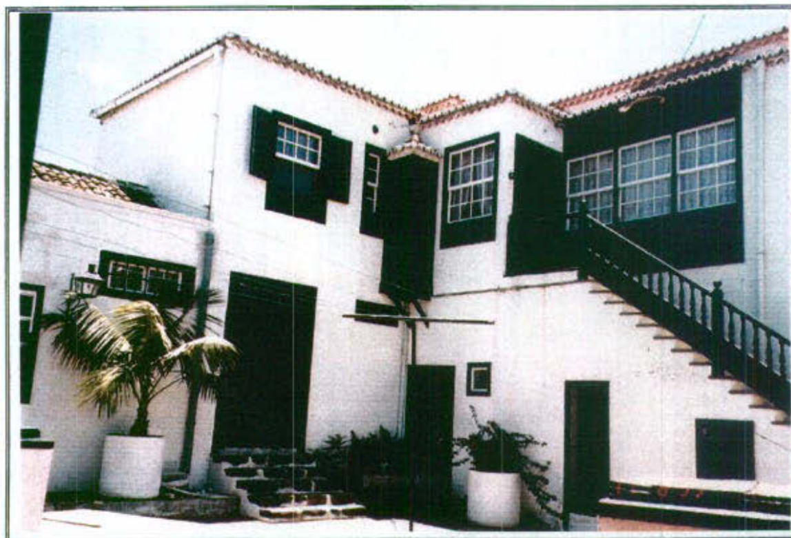
50.4 - Vista general patio interior y acceso a planta superior
