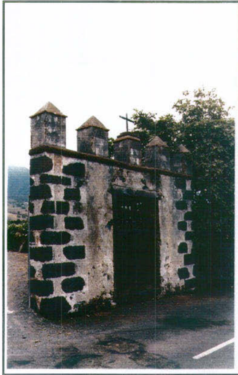
60.1 - Vista general desde el Este
