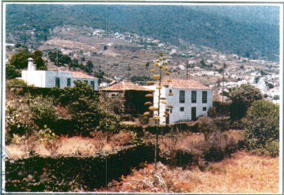
52.1 - Vista general de la edificación desde el Este
