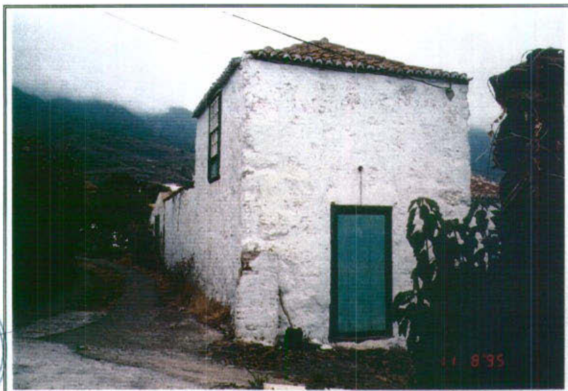
56.3 - Vista parcial de la edificación en su fachada Este
