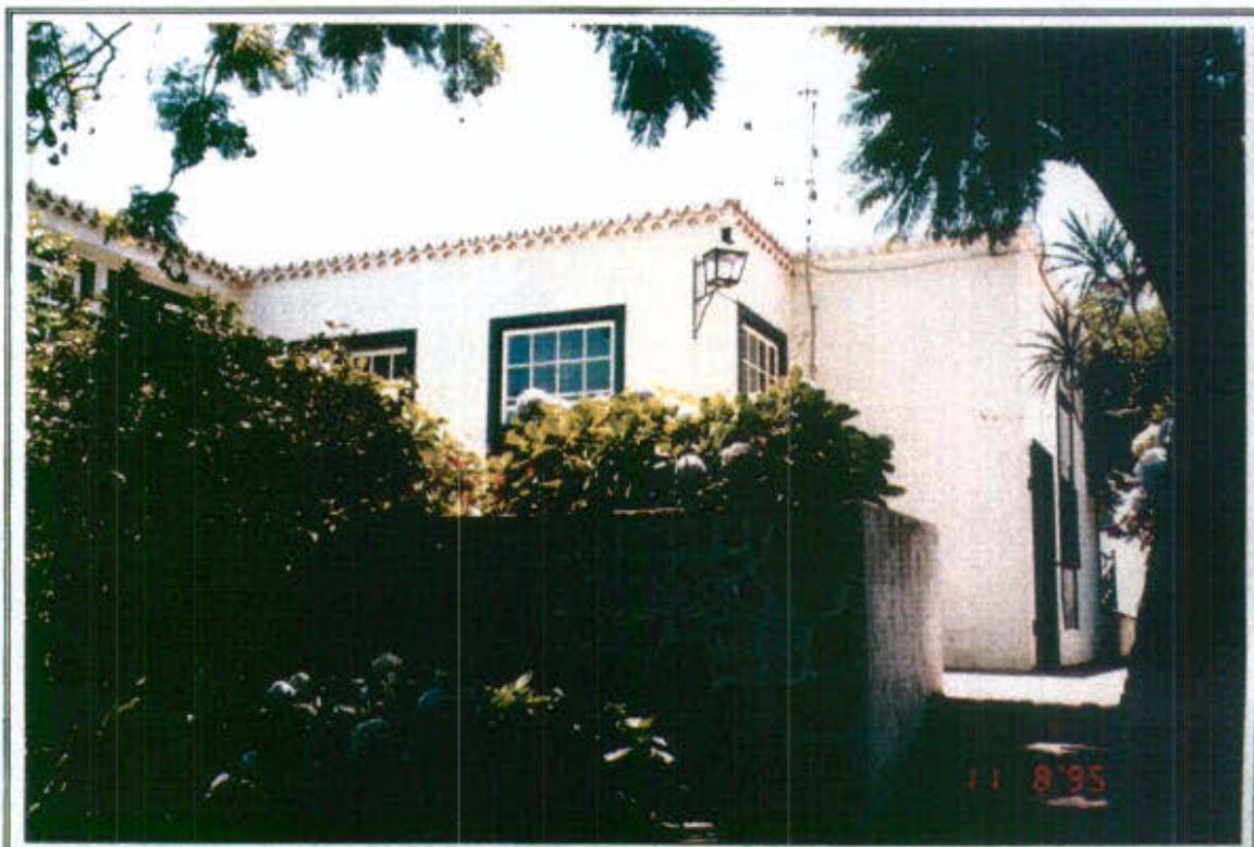
50.2 - Vista general fachada Este
