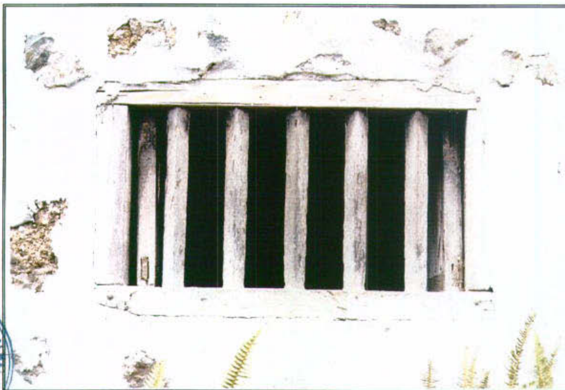
58.11 - Detalle carpintería, hueco de ventilación almacén
