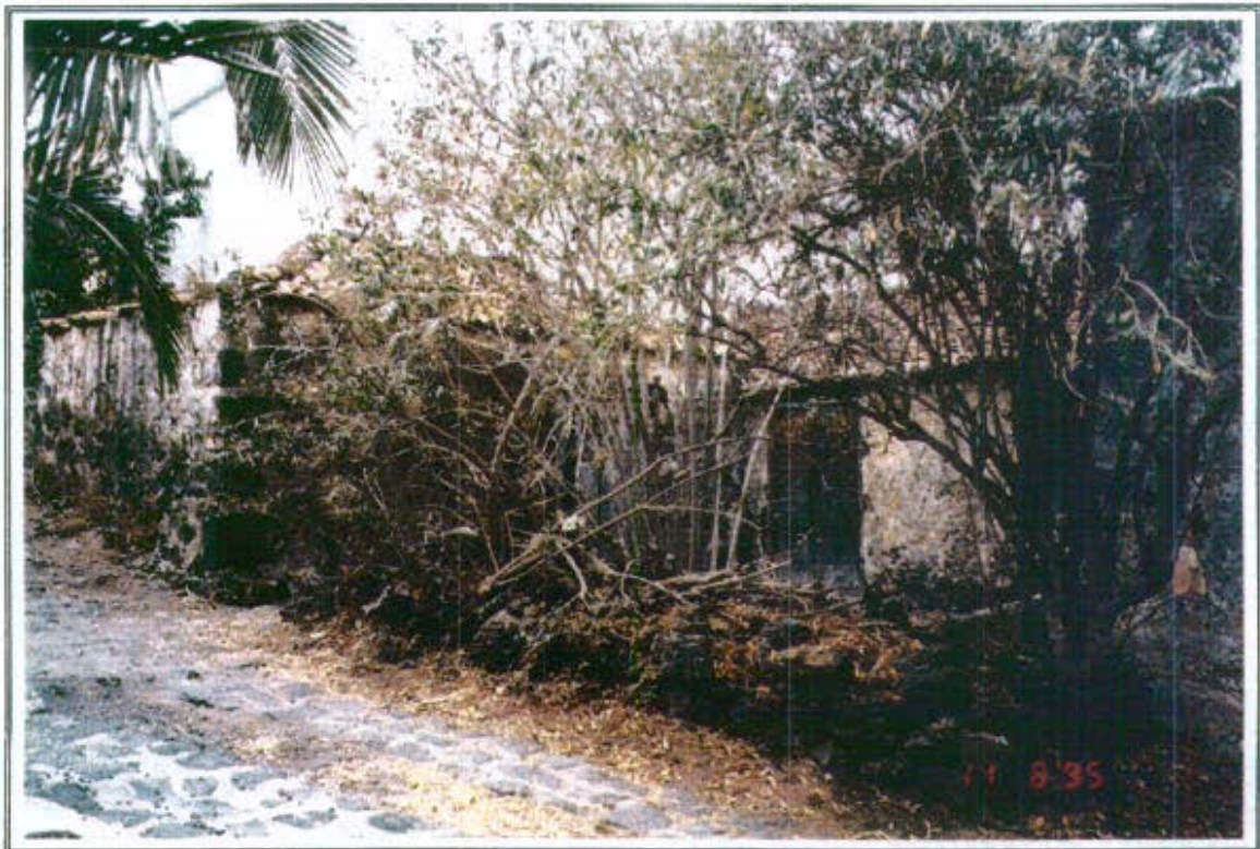
57.2 - Vista parcial de la edificación en su fachada Este, y acceso
