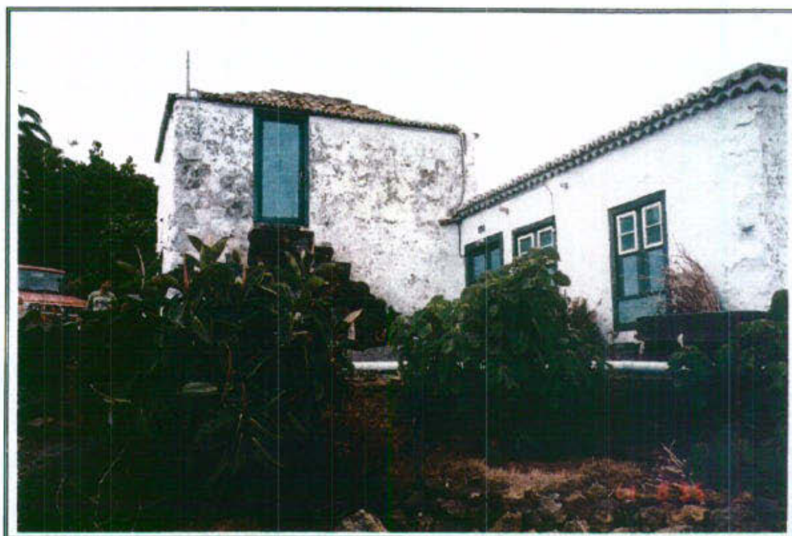
56.2 - Vista general de la edificación en su fachada Norte
