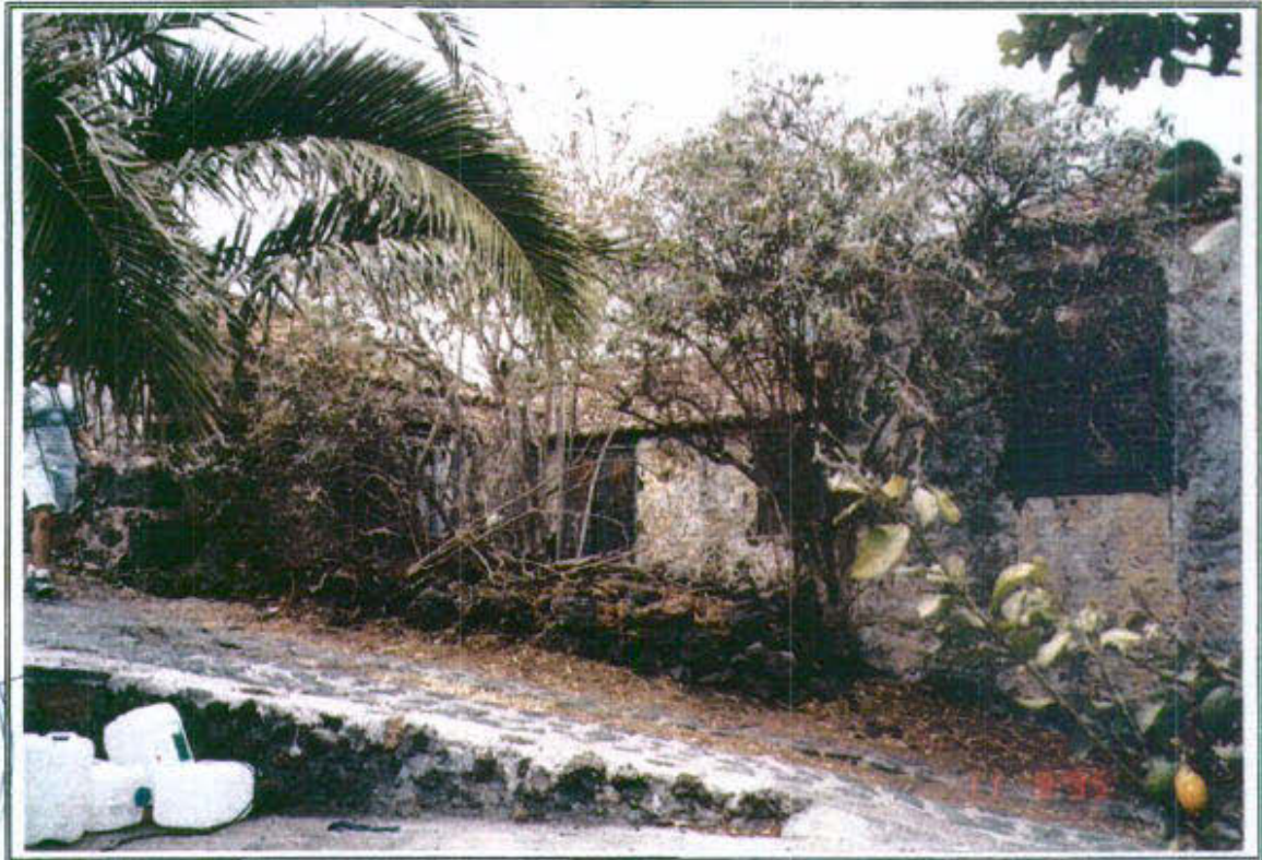
57.1 - Vista parcial de la edificación en su fachada Este
