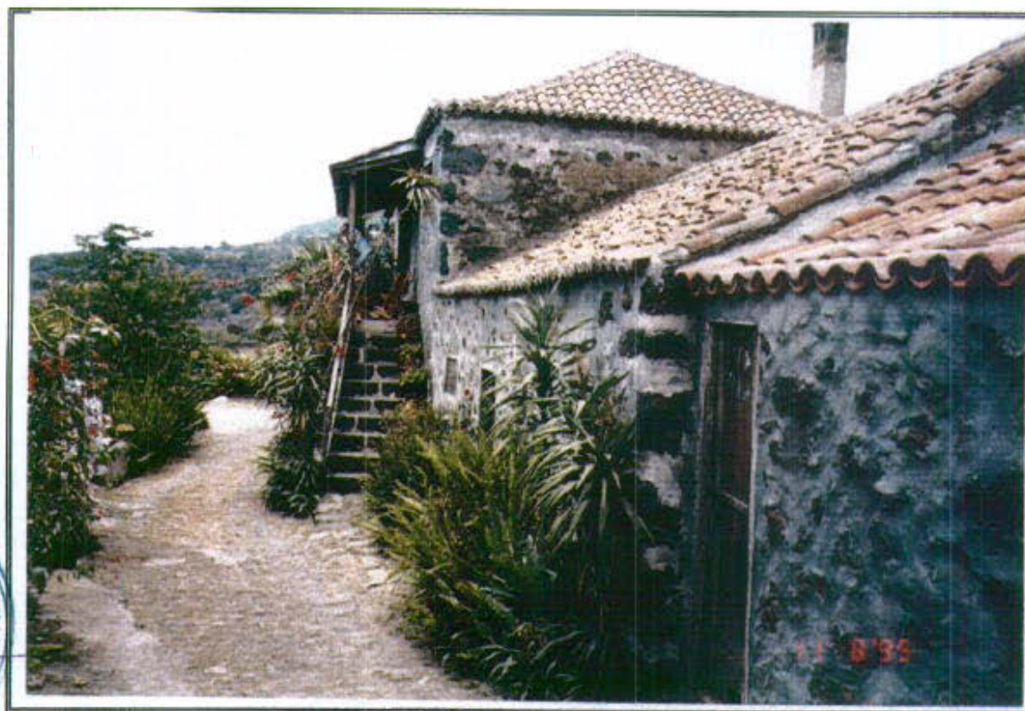
58.1 - Vista general desde el acceso. Fachada Este
