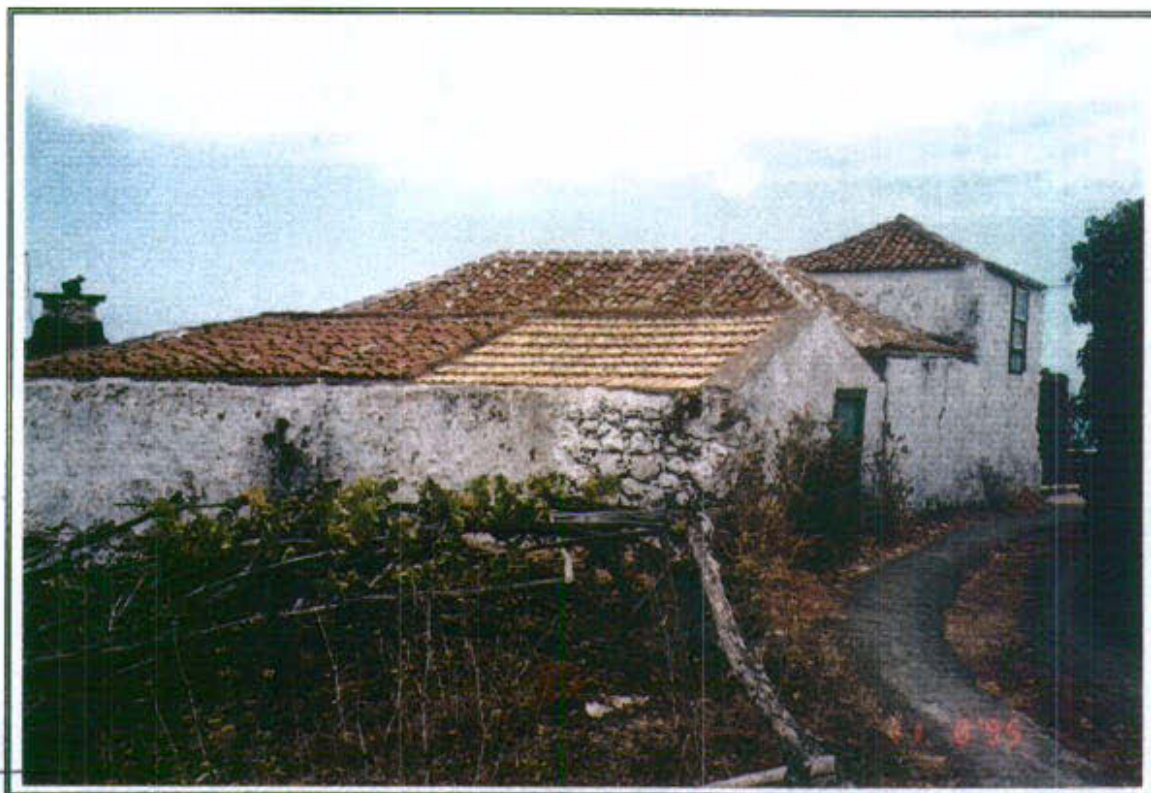
56.1 - Vista general de la edificación en su fachada Oeste
