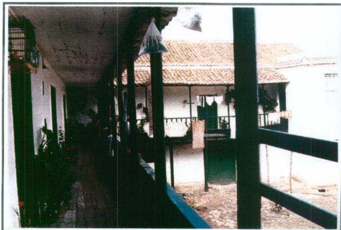
47.4 - Detalle de la galería cubierta sobre el patio en "L"
