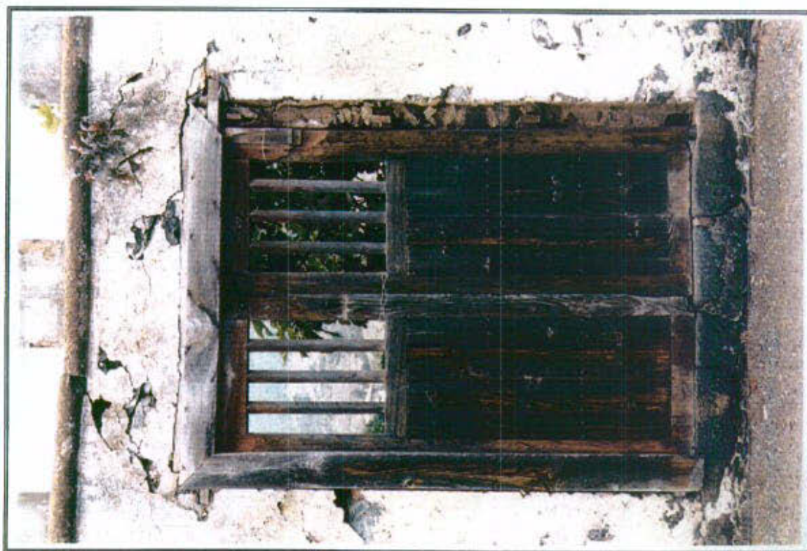
60.3 - Detalle de la carpintería de madera de la puerta de entrada
