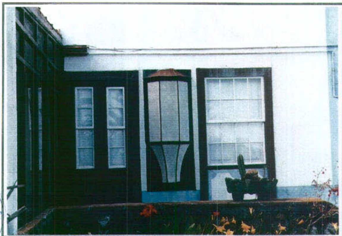
54.7 - Vista parcial de la edificación desde el Sur
