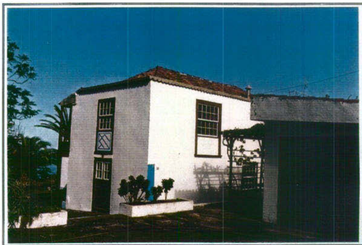
54.2 - Vista parcial de la edificación desde el Noroeste
