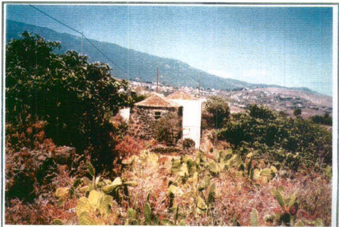
52.2 - Vista general de la edificación desde la fachada Sur
