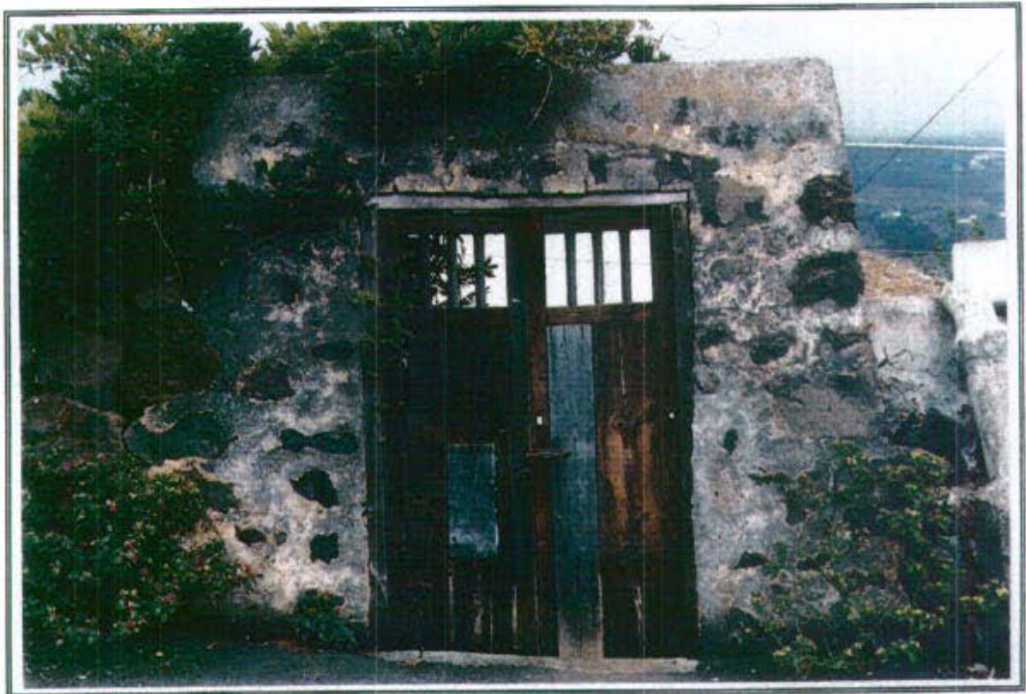
59.2 - Vista general desde el Este
