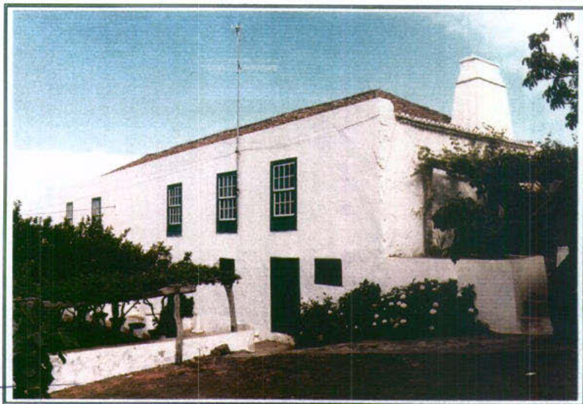
47.3 - Vista general de la edificación desde el Noroeste
