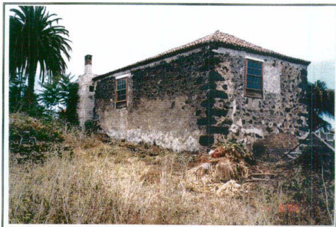
58.2 - Vista general desde el Oeste
