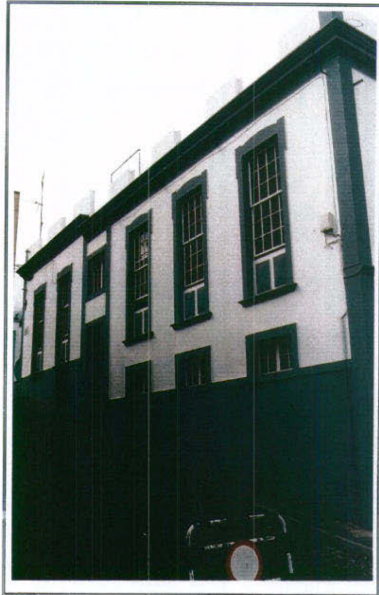
30(II).5 - Vista general de la edificación en su fachada Sur
