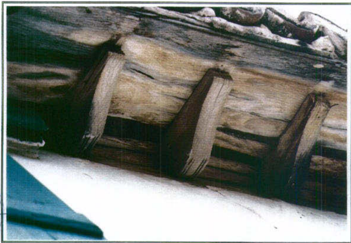
42.9 - Detalle de remate exterior de alero de cubierta (pares labrados y tablas)
