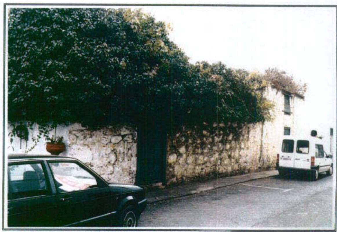
39.2 - Detalle de la edificación en su fachada Norte
