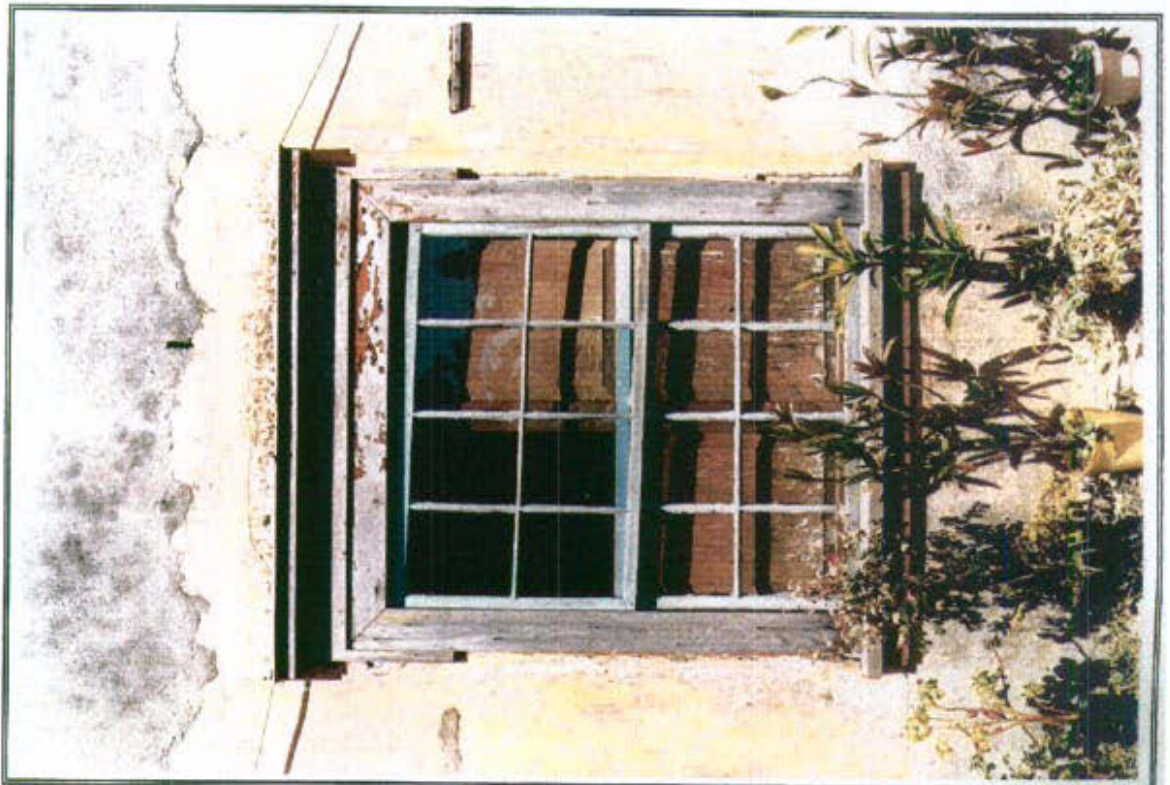
41.5 - Detalle de carpintería exterior de madera (ventana)
