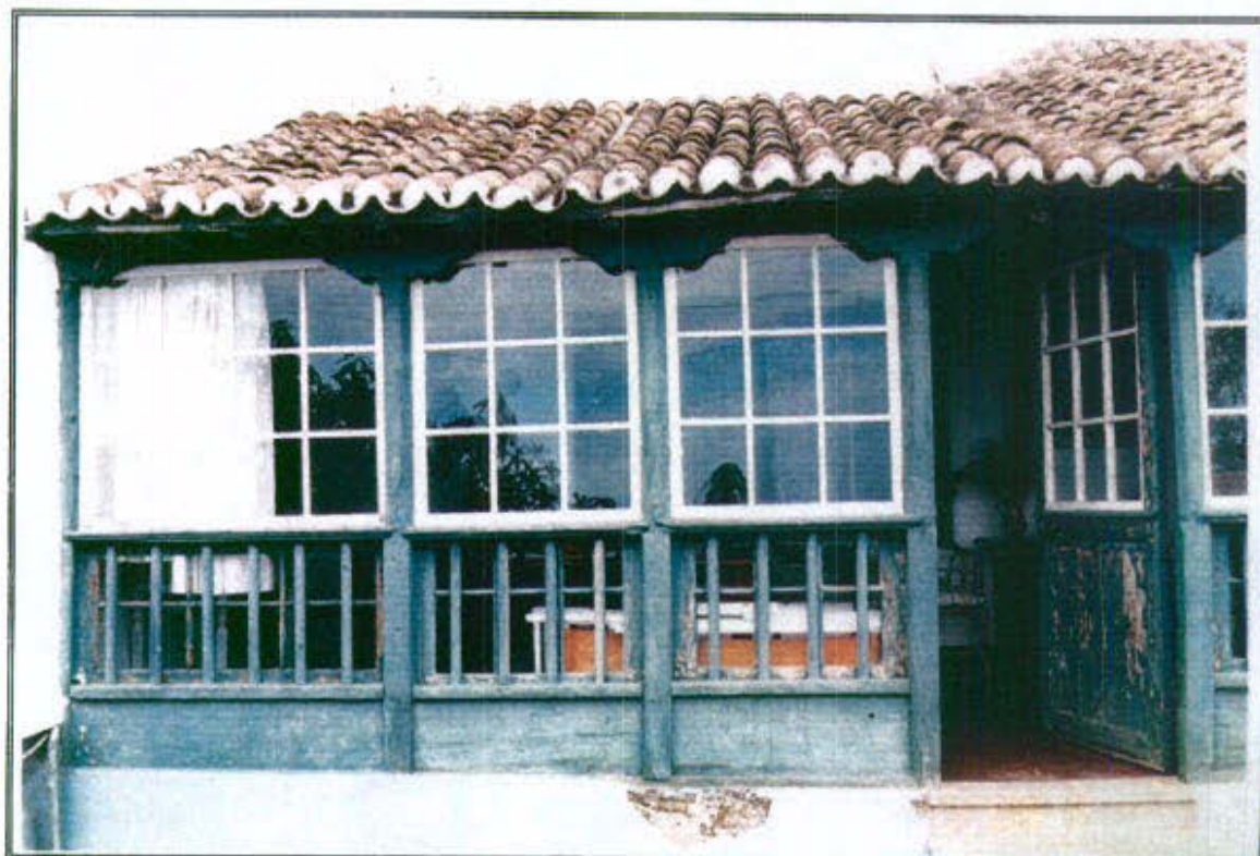
42.2 - Detalle de galería cubierta en su fachada Este
