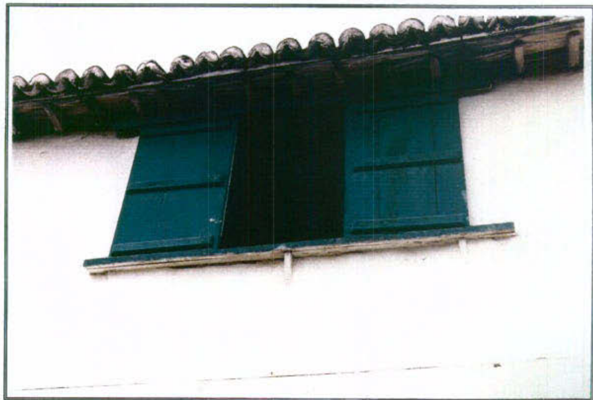
42.10 - Detalle de carpintería exterior de ventana en su fachada Norte
