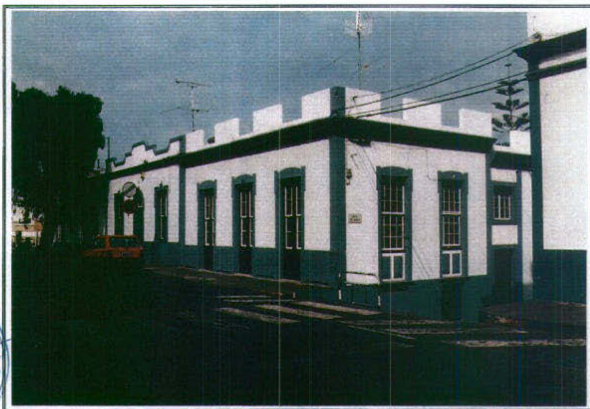
30(II).3 - Vista general de la edificación desde el Sur
