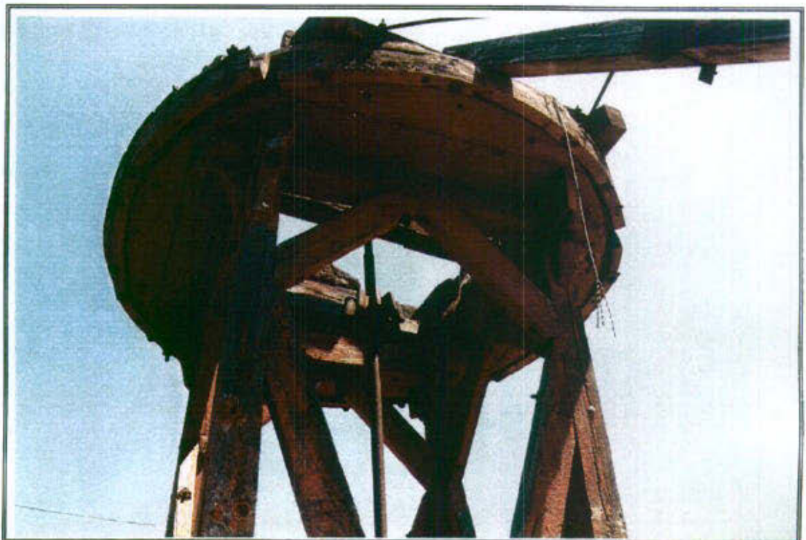
40.2 - Detalle de la estructura
