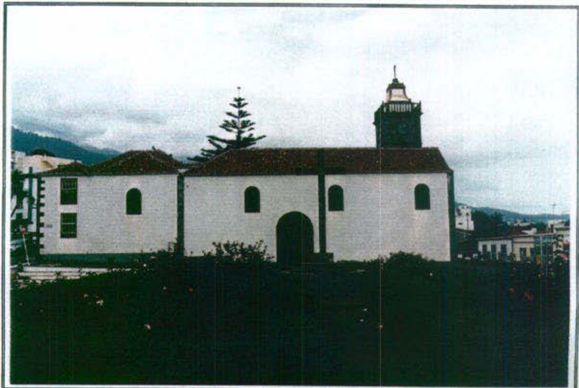
38.2 - Vista general de la edificación en su fachada Sur
