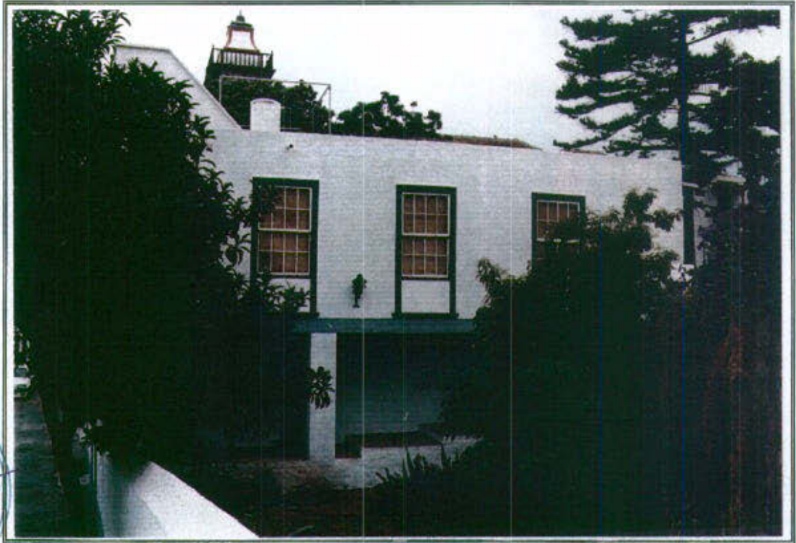
31.3 - Vista general de la edificación en su fachada Norte
