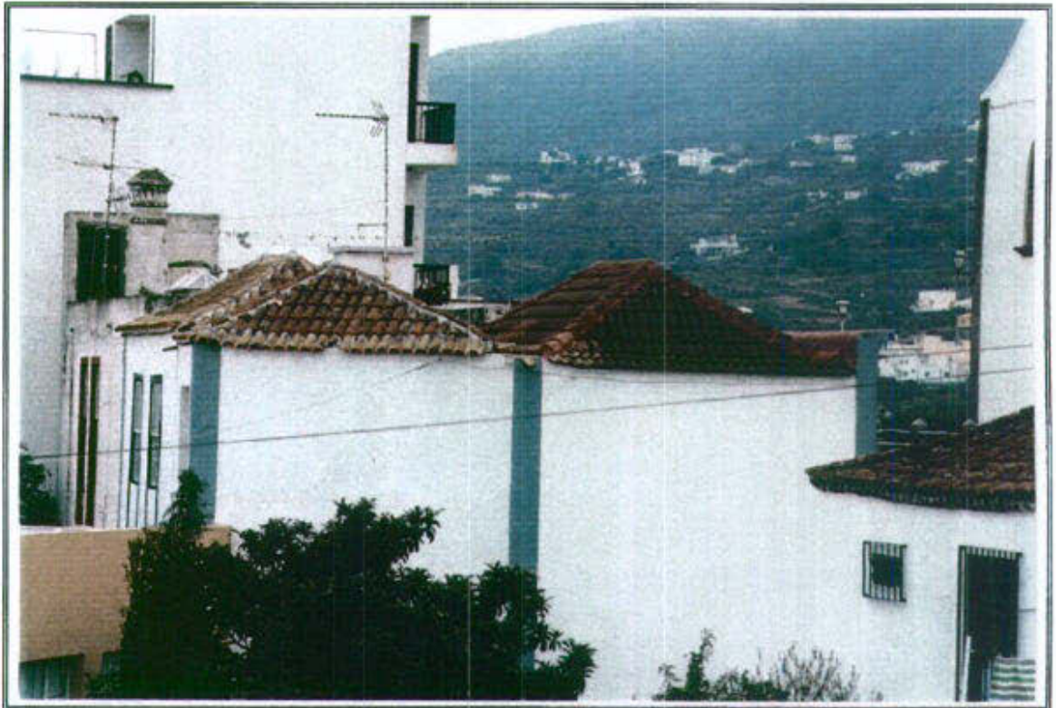
35.3 - Vista general de la edificación desde el Noreste
