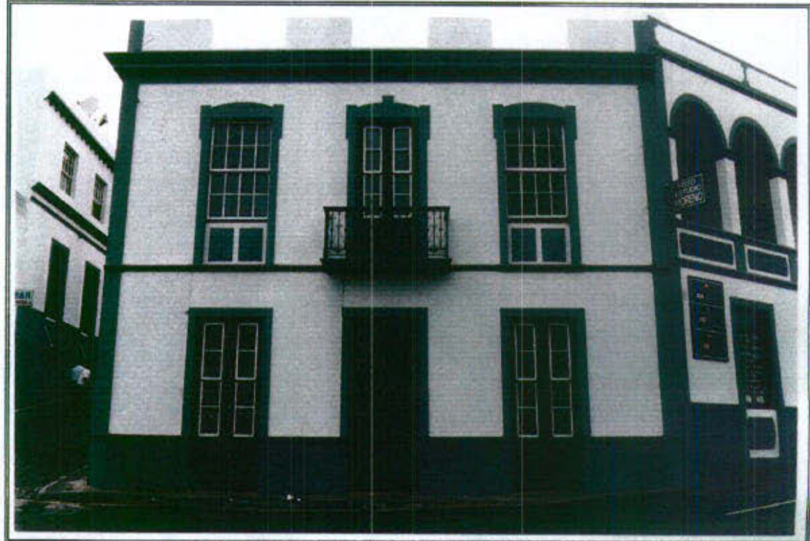
30(II).2 - Vista parcial de la edificación
