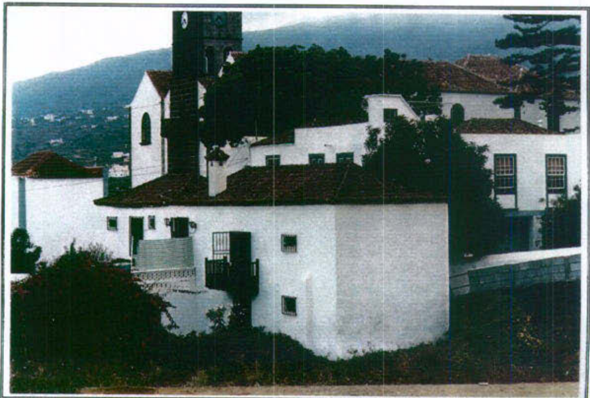
34.2 - Vista general de la edificación en su fachada Noreste
