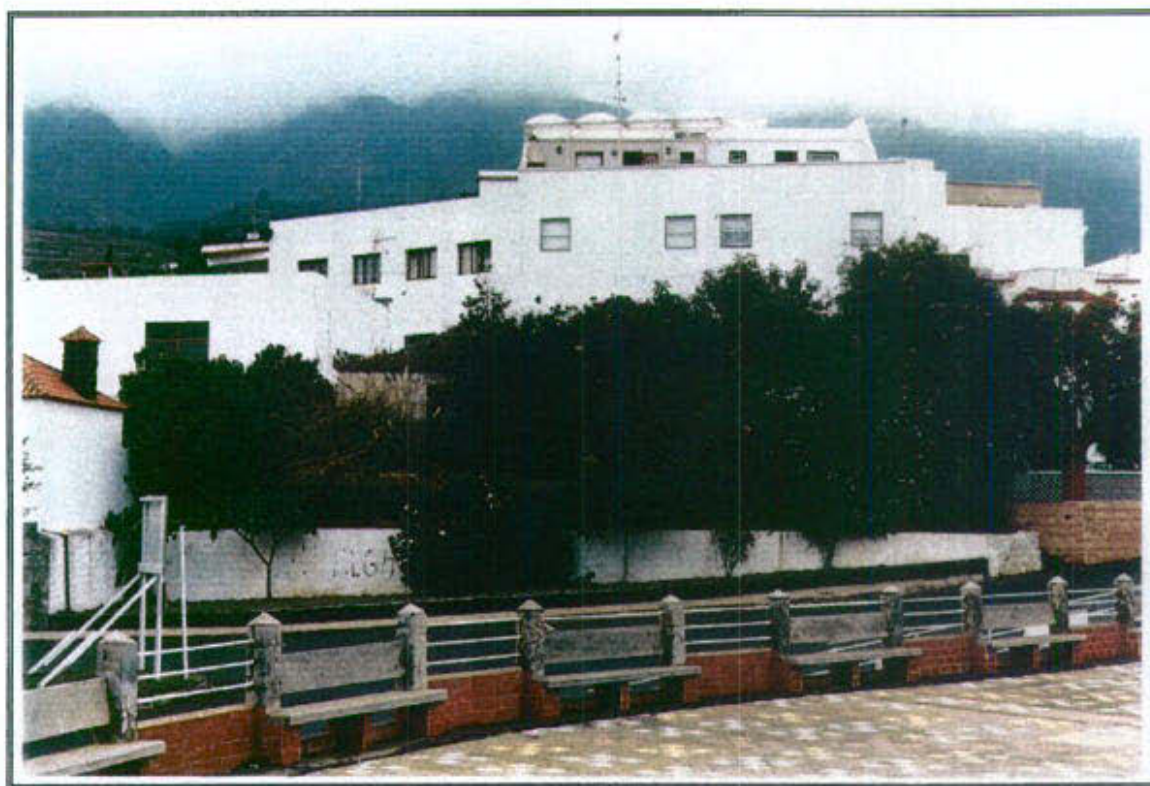
39.4 - Vista general de la edificación en su fachada Sur
