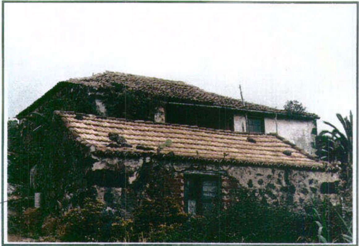
46.3 - Vista general de la edificación en su fachada Este
