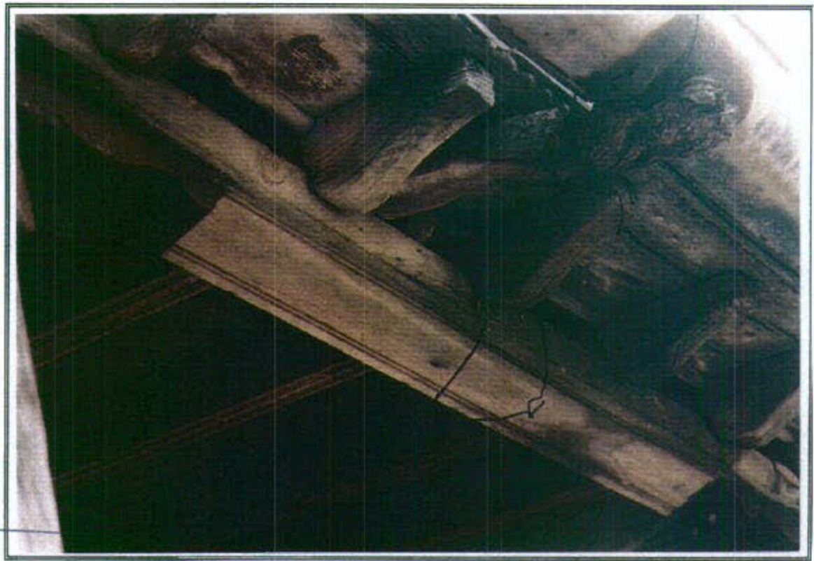
46.5 - Detalle del alero de cubierta en el zaguán de entrada: canecillos , pares y durmiente de madera labrada
