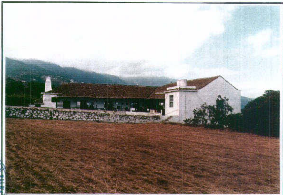
47.1 - Vista general de la edificación desde el Sur-Este
