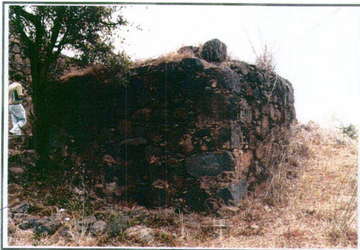
44.1 - Vista general del horno desde la situación de la boca
