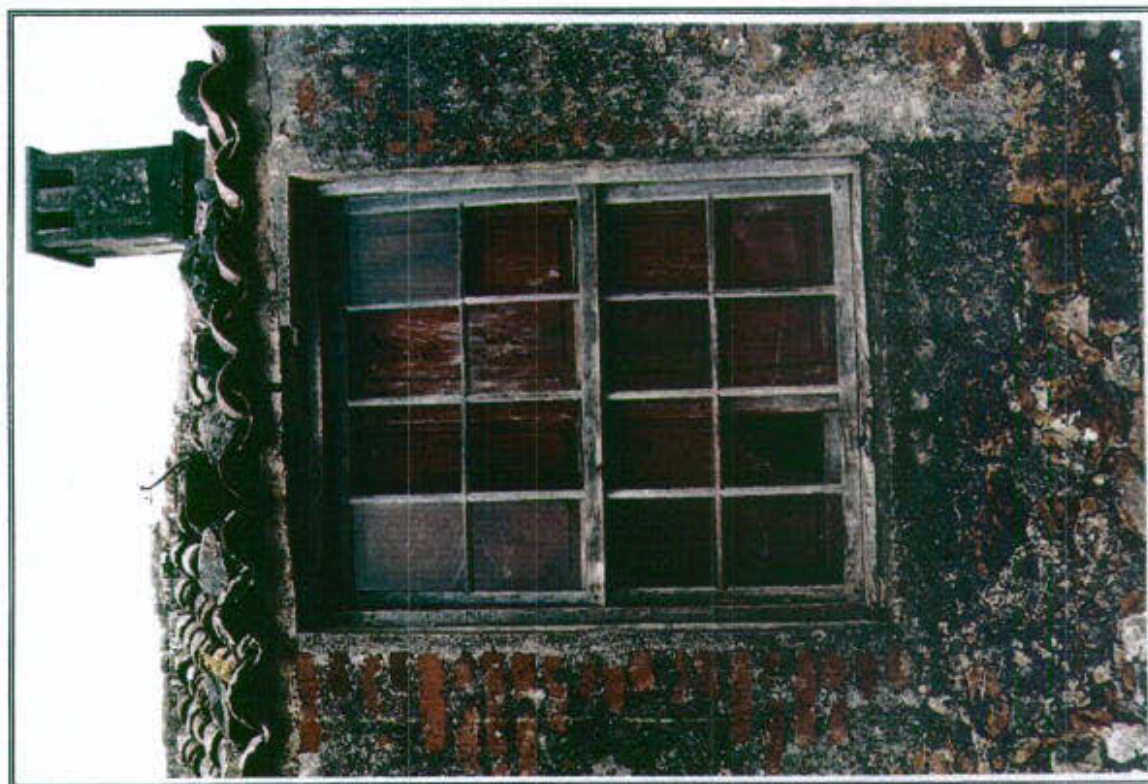
46.12 - Detalle de carpintería exterior (ventana) y muro de cerramiento de composición mixta (mampuesto y ladrillo macizo)
