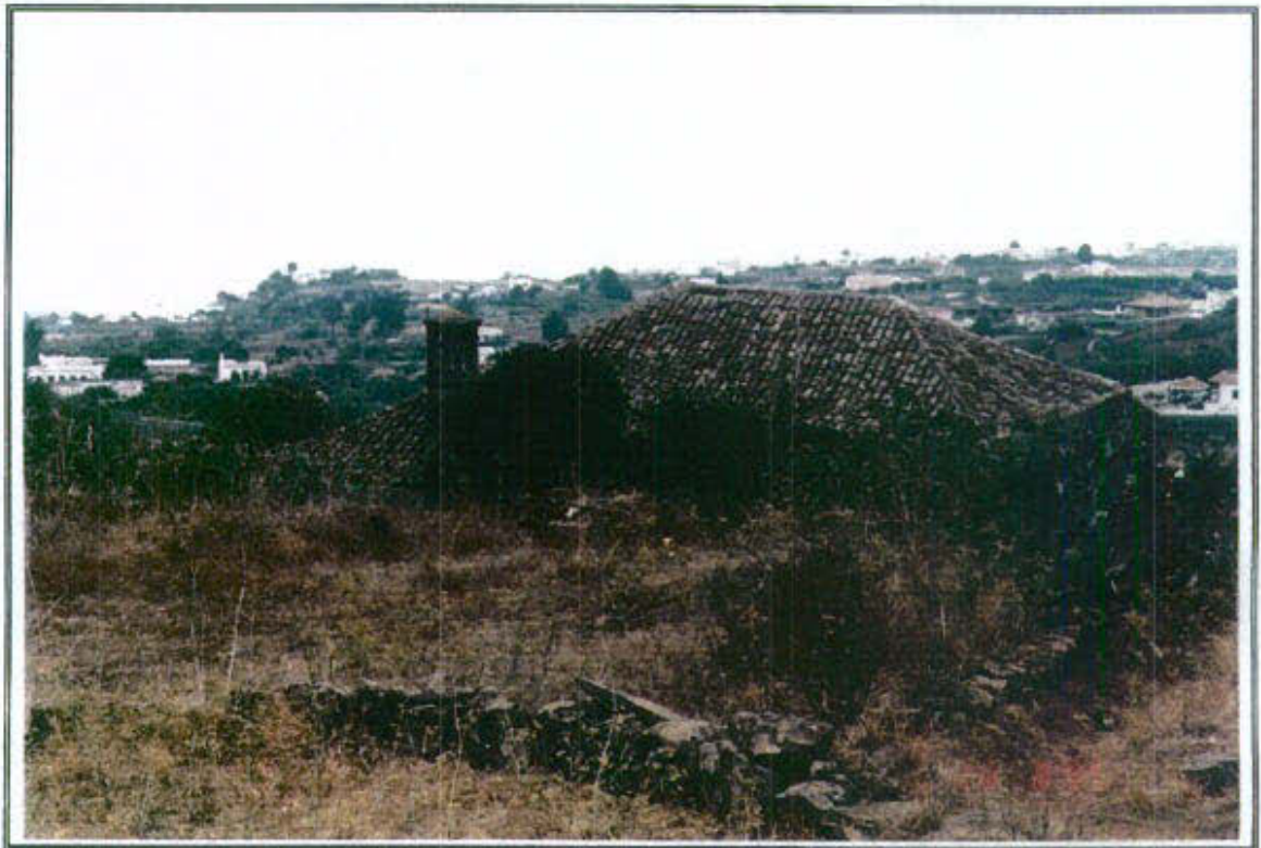
46.4 - Vista general de la edificación en su fachada Oeste
