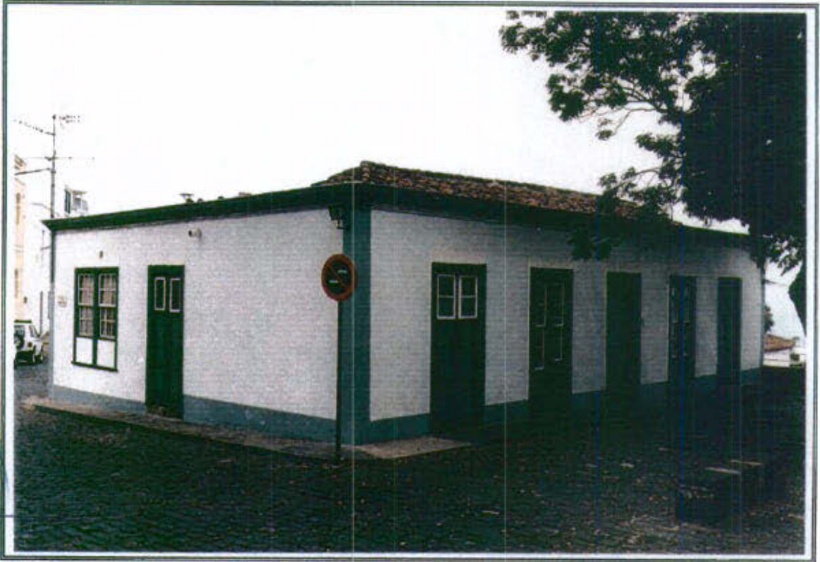
31.1 - Vista general de la edificación en su fachada Sur
