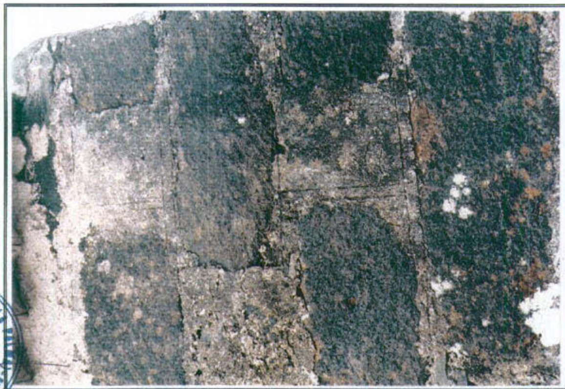
46.9 - Detalle de esgrafiados en muro de cerramiento, revocado con mortero de cal
