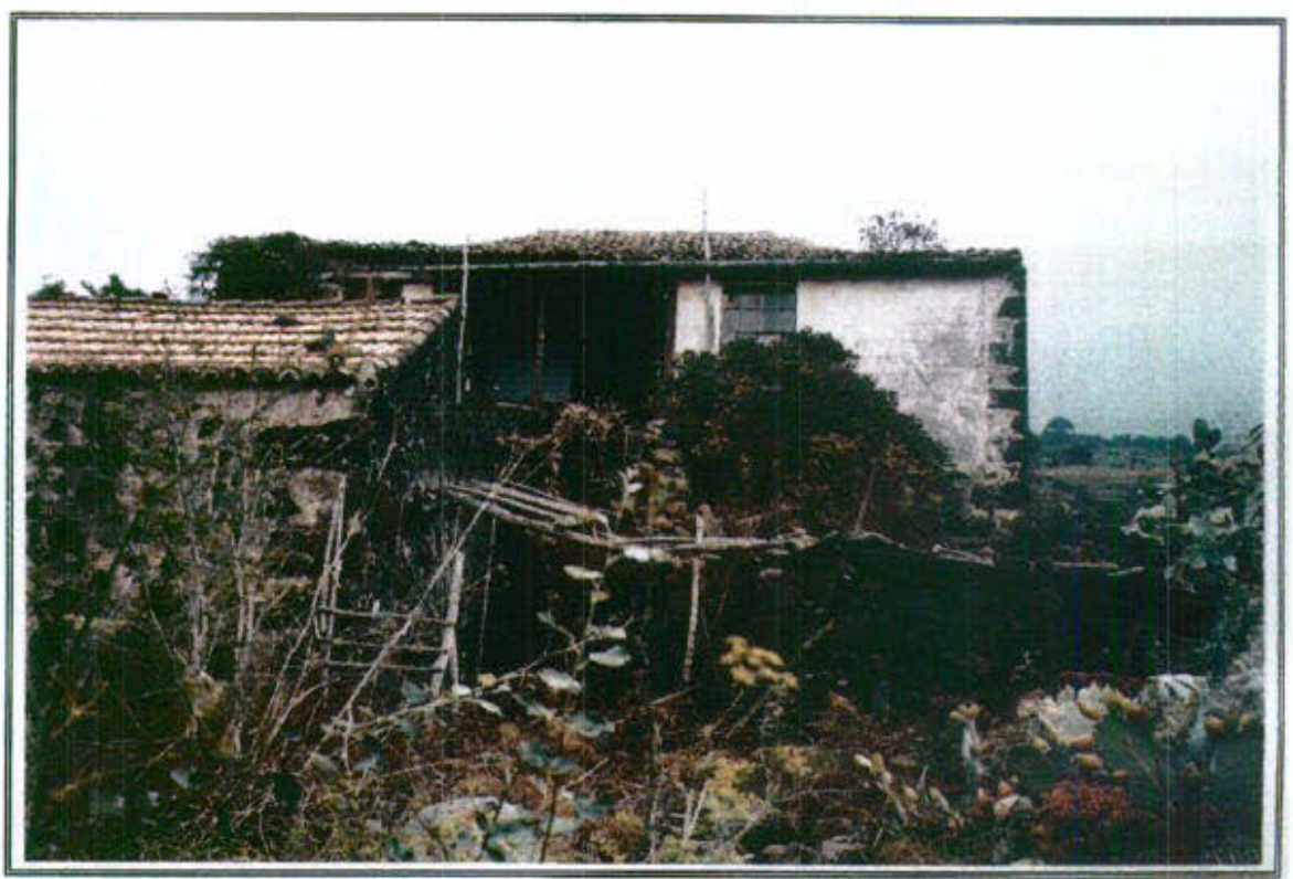
46.2 - Vista parcial de la edificación en su fachada Este
