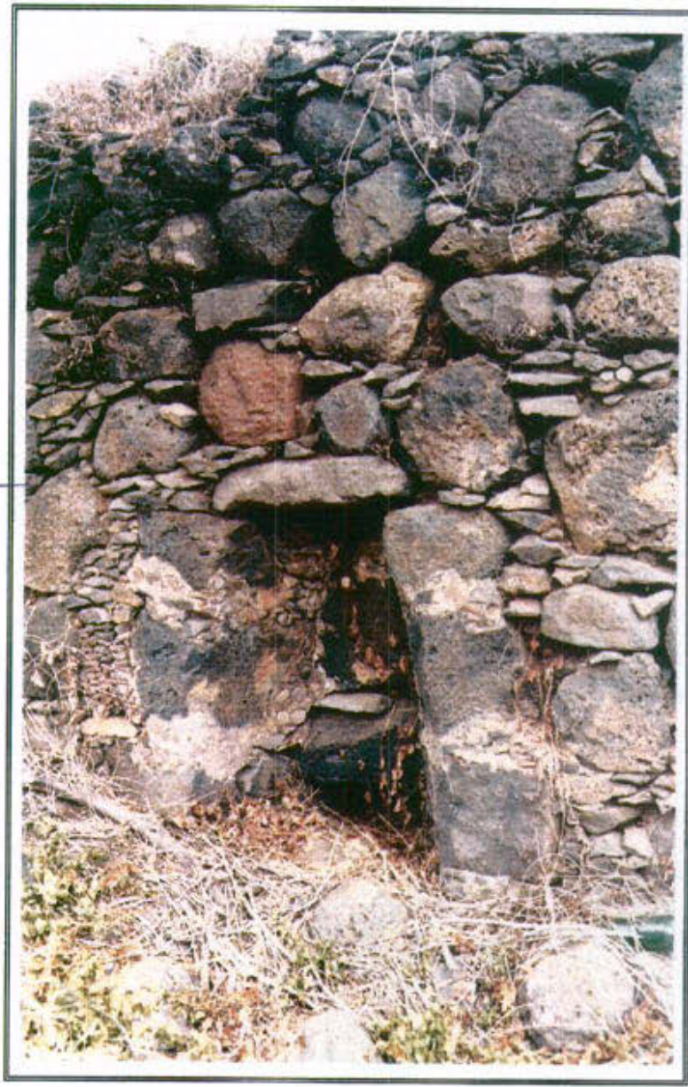
44.3 - Detalle de la boca y composición de muros de mampuesto de piedra seca
