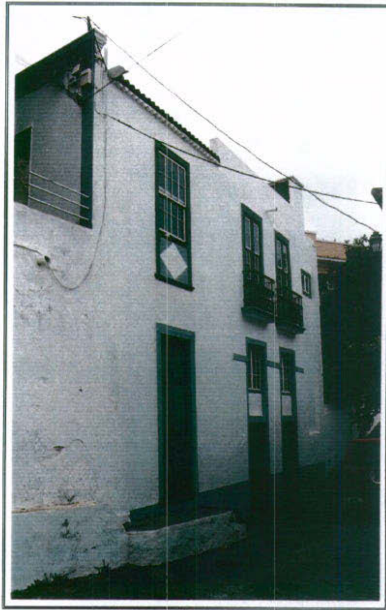
31.5 - Detalle de la edificación en su fachada Este
