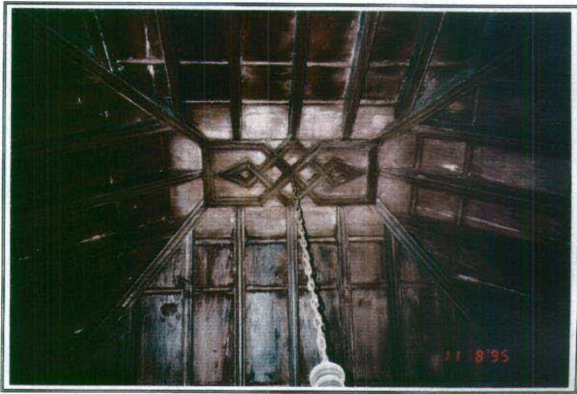
42.6 - Detalle interior de cubierta tradicional y lacería
