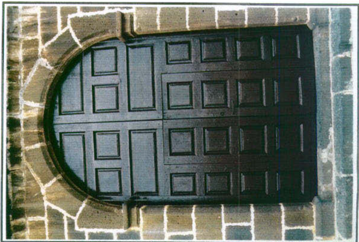
38.6 - Detalle de la puerta de entrada por la fachada Este, bajo la torre
