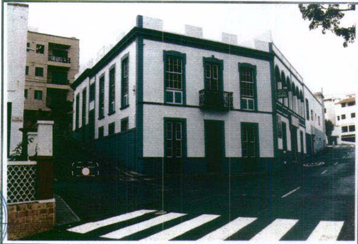
30(II).1 - Vista general de la edificación desde el Sureste
