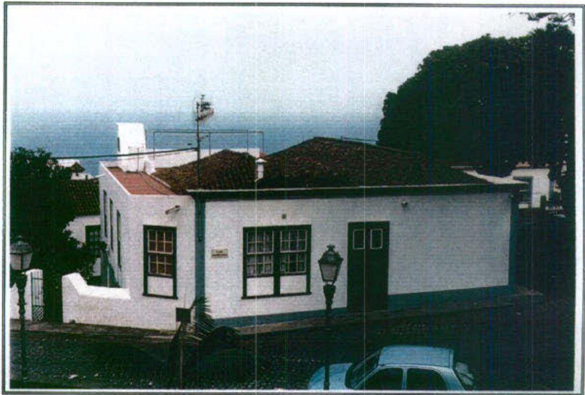
31.2 - Vista general de la edificación en su fachada Oeste
