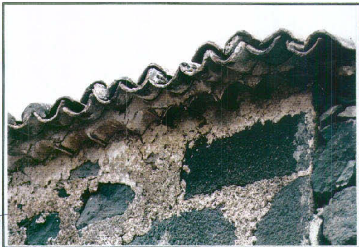
46.7 - Detalle de remate de alero de cubierta
