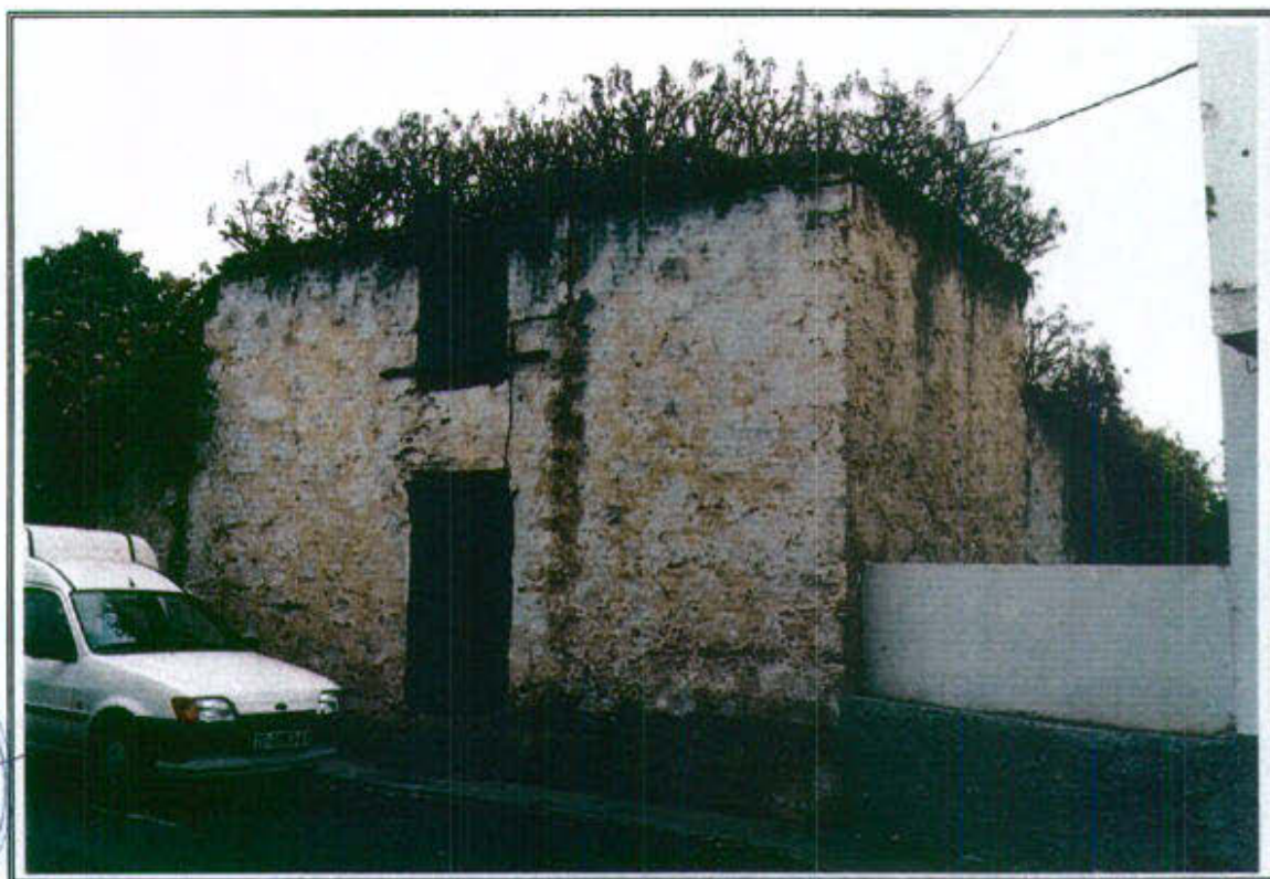
39.3 - Detalle de la edificación en su fachada Norte
