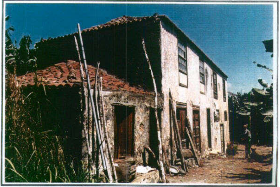
41.2 - Vista general de la edificación en su fachada Sureste
