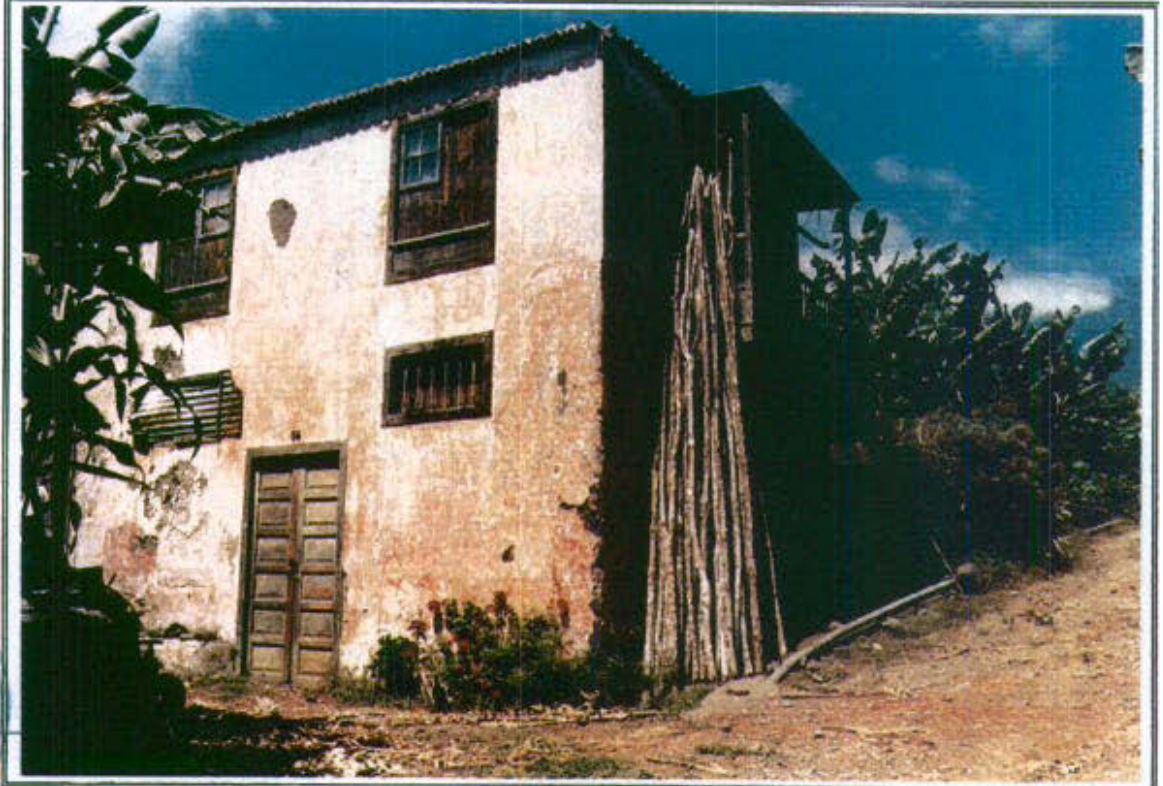
41.1 - Vista parcial de la edificación en su fachada Este
