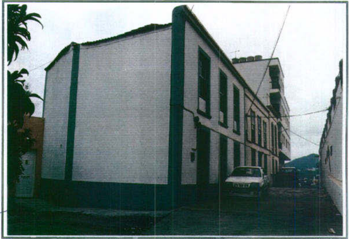
35.2 - Vista general de la edificación desde el Norte
