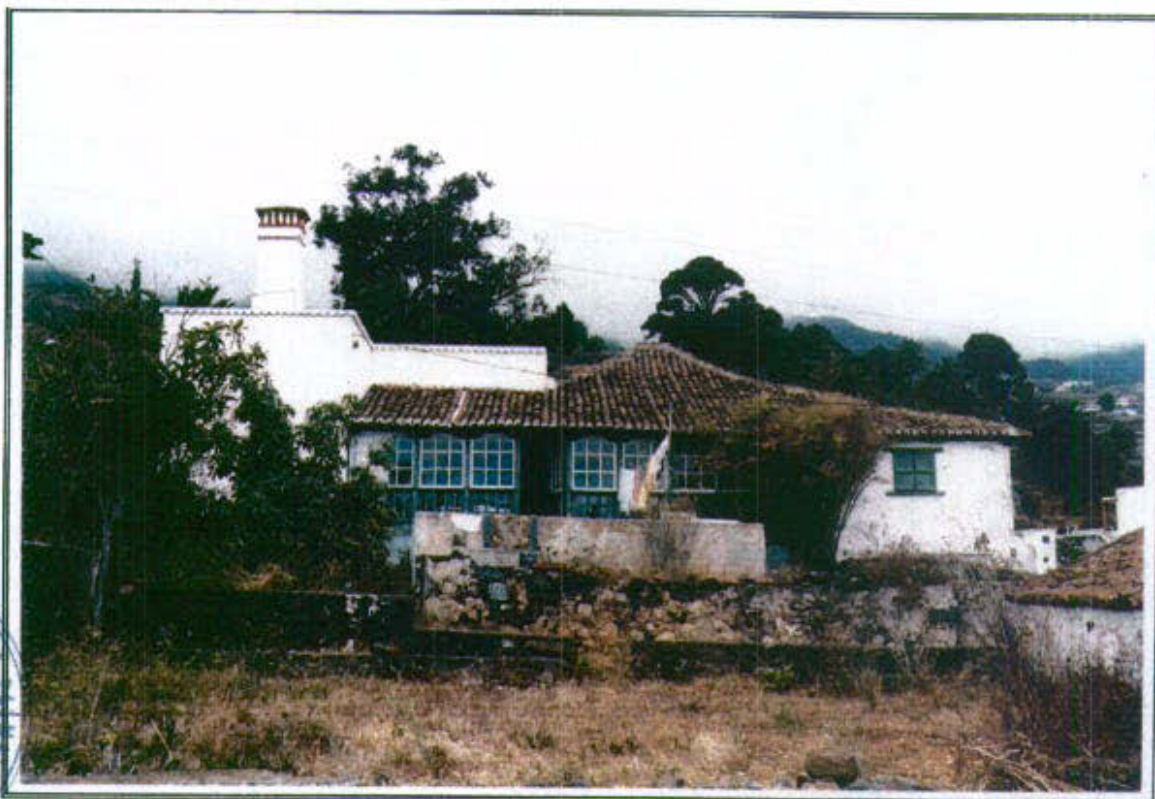
42.1 - Vista general del edificio desde su fachada Este
