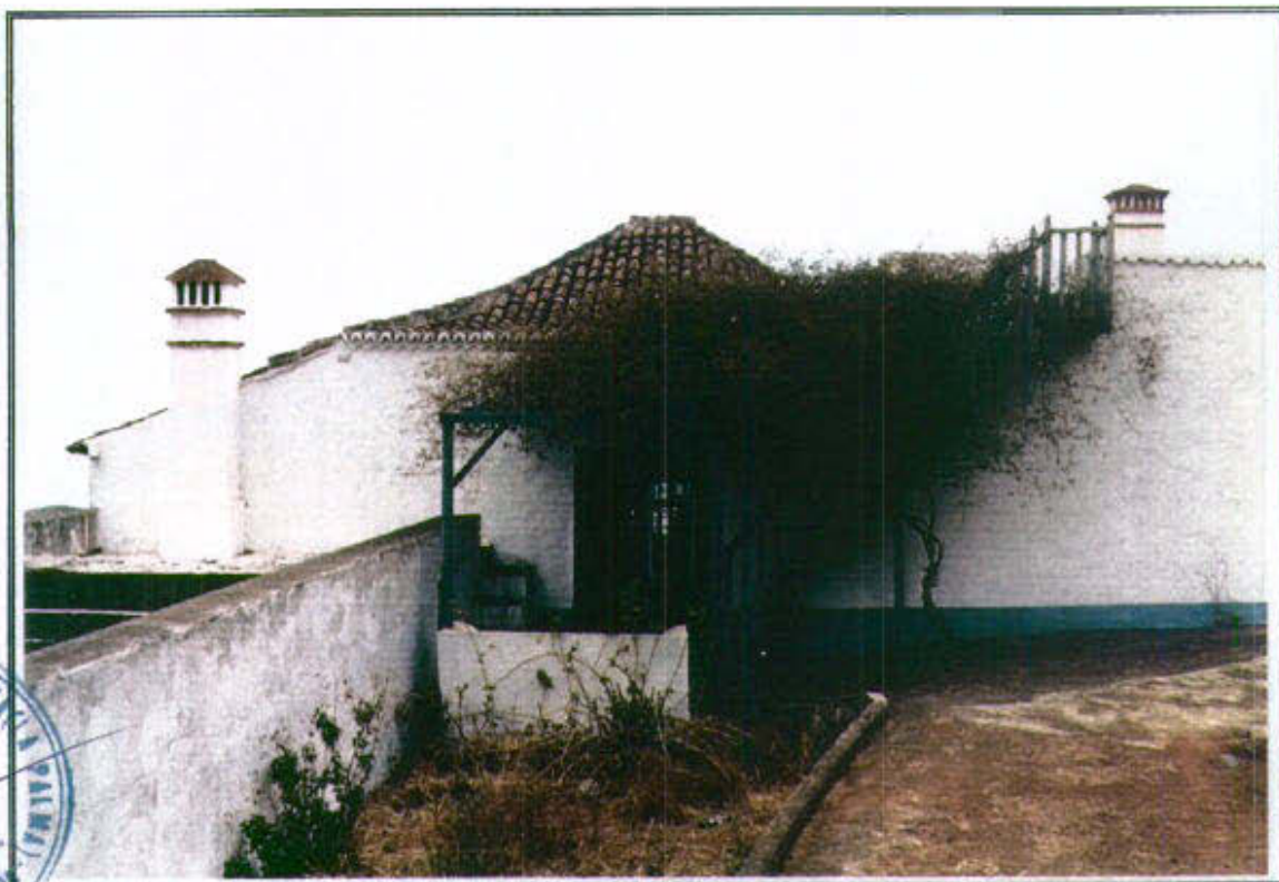
42.3 - Vista general del edificio en sus fachada Oeste
