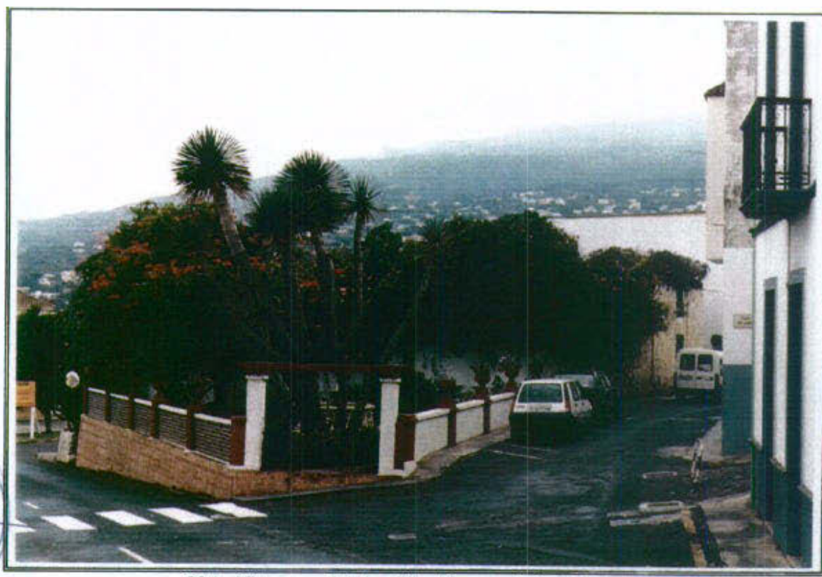
39.1 - Vista general de la edificación en su fachada Norte
