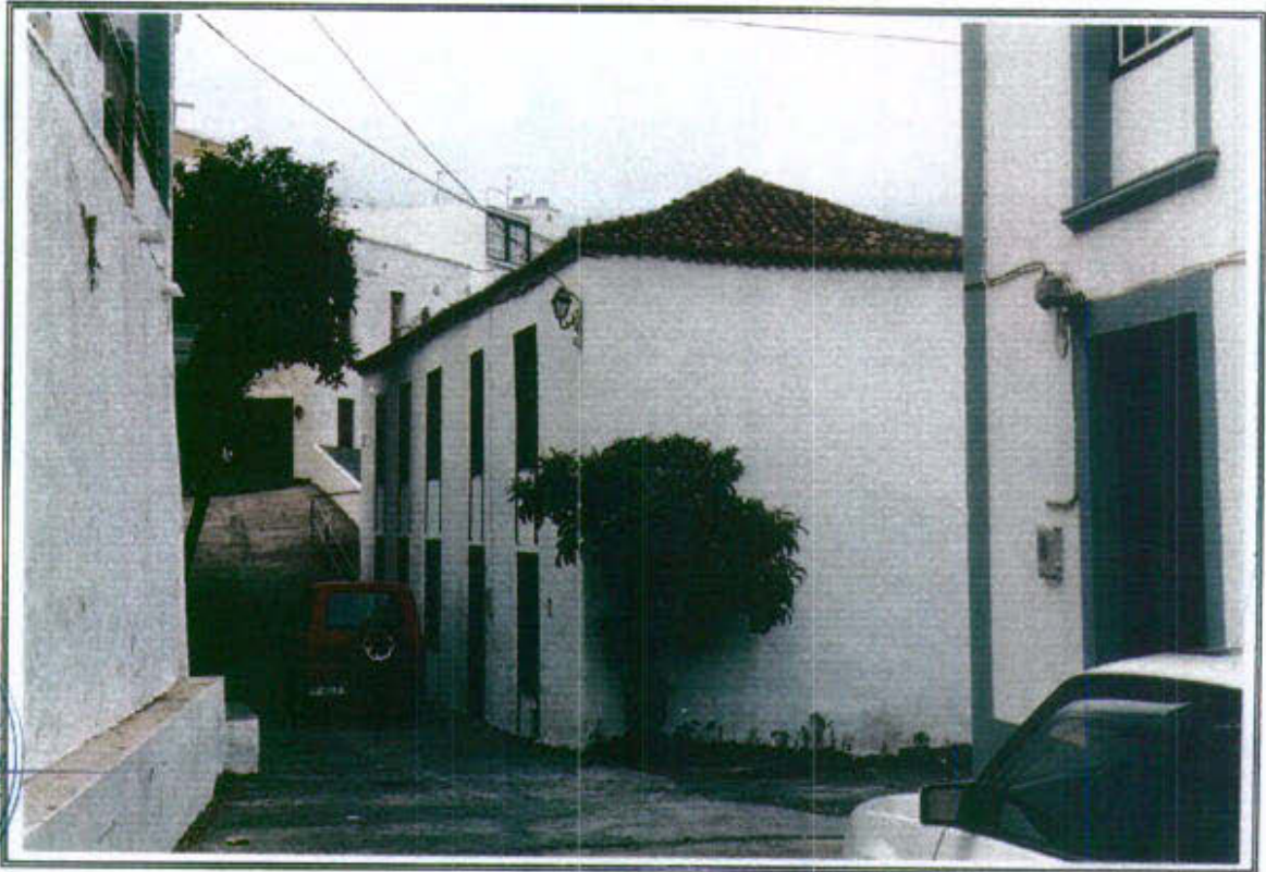
34.1 - Vista general de la edificación en su fachada Oeste
