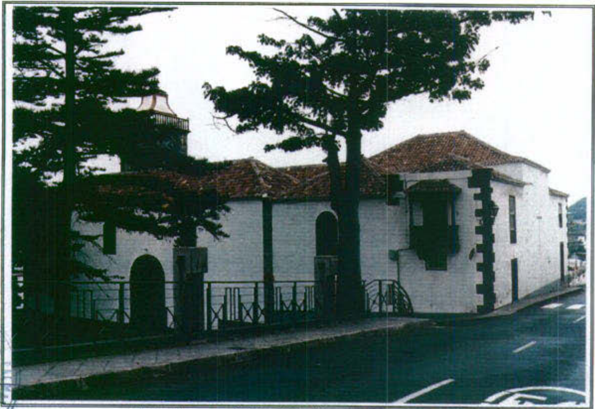
38.1 - Vista general de la edificación en su fachada Norte
