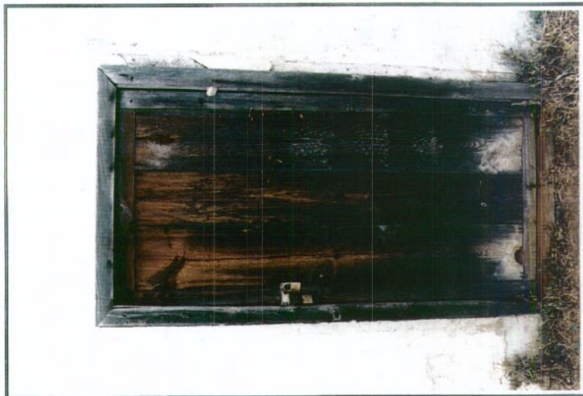
24.6 - Detalle de carpintería exterior de madera (puerta)
