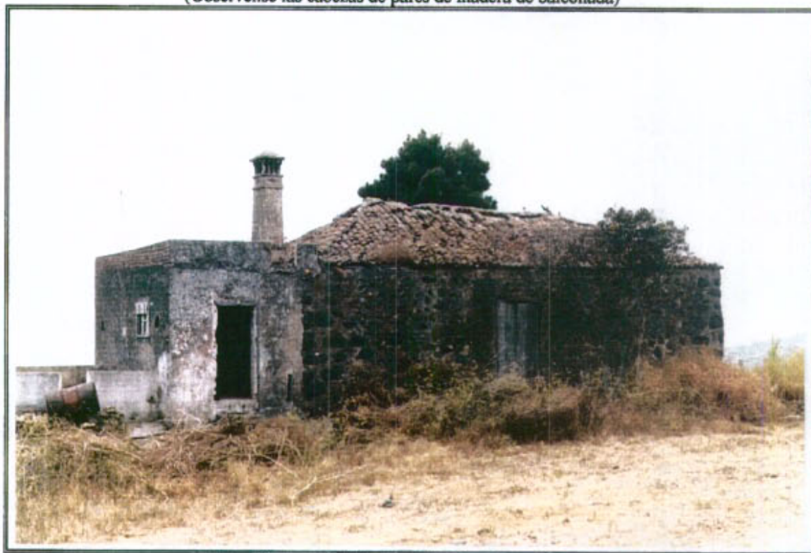
27.2 - Vista general de la edificación desde el Oeste.
