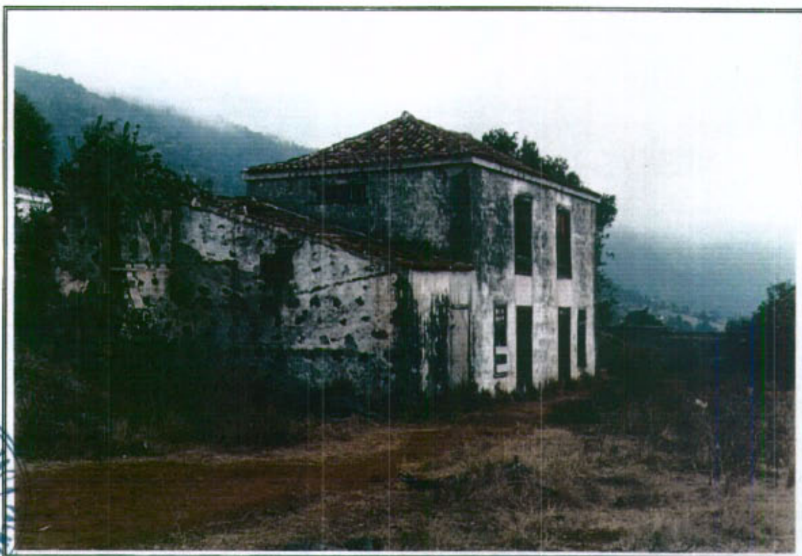
24.1 - Vista general de la edificación en su fachada Sureste
