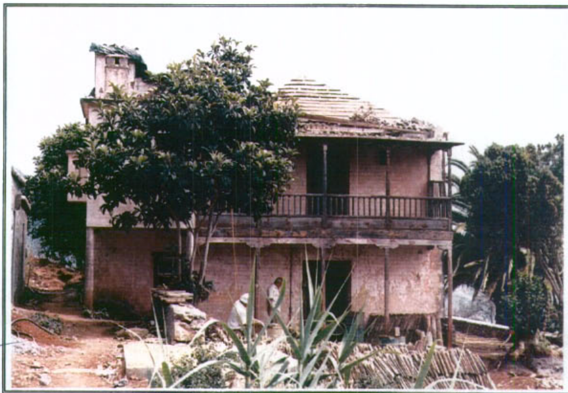
18.3 - Vista parcial de la edificación desde el Sur
