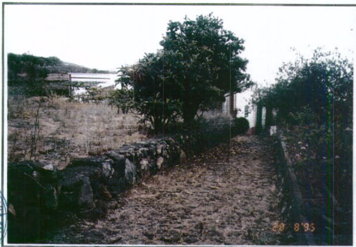
26.3 - Detalle del empedrado del paseo de acceso desde el Oeste
