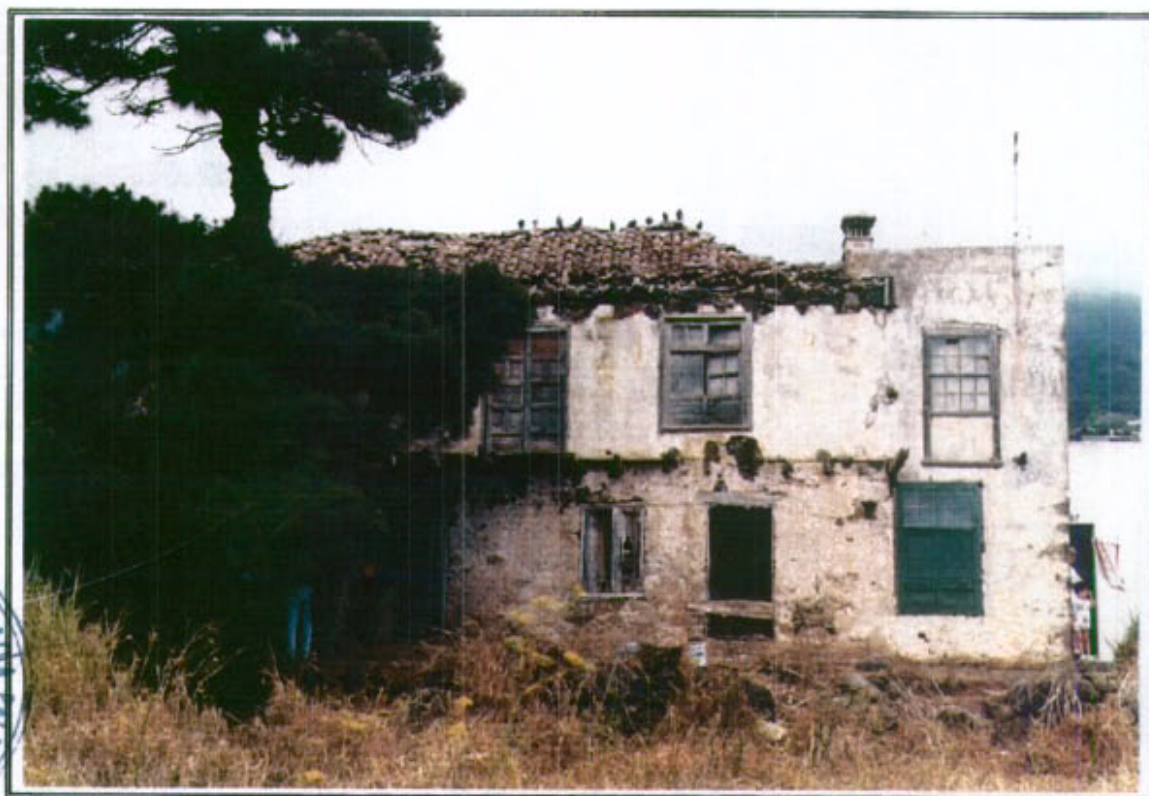
27.1 - Vista general de la edificación desde el Este . (Obsérvense las cabezas de pares de madera de balconada)
