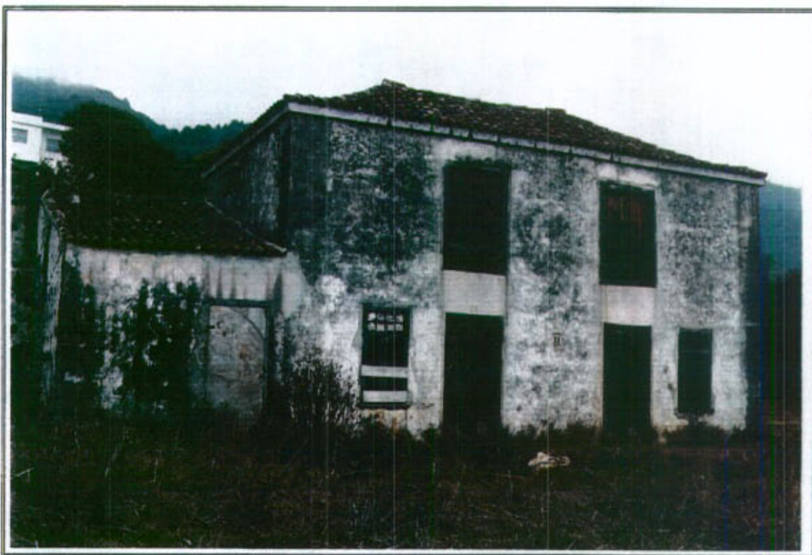
24.2 - Vista general de la edificación en su fachada Este
