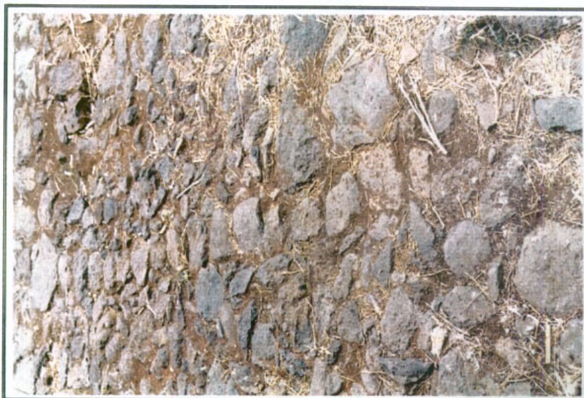
27.8 - Detalle de empedrado exterior en acceso a vivienda
