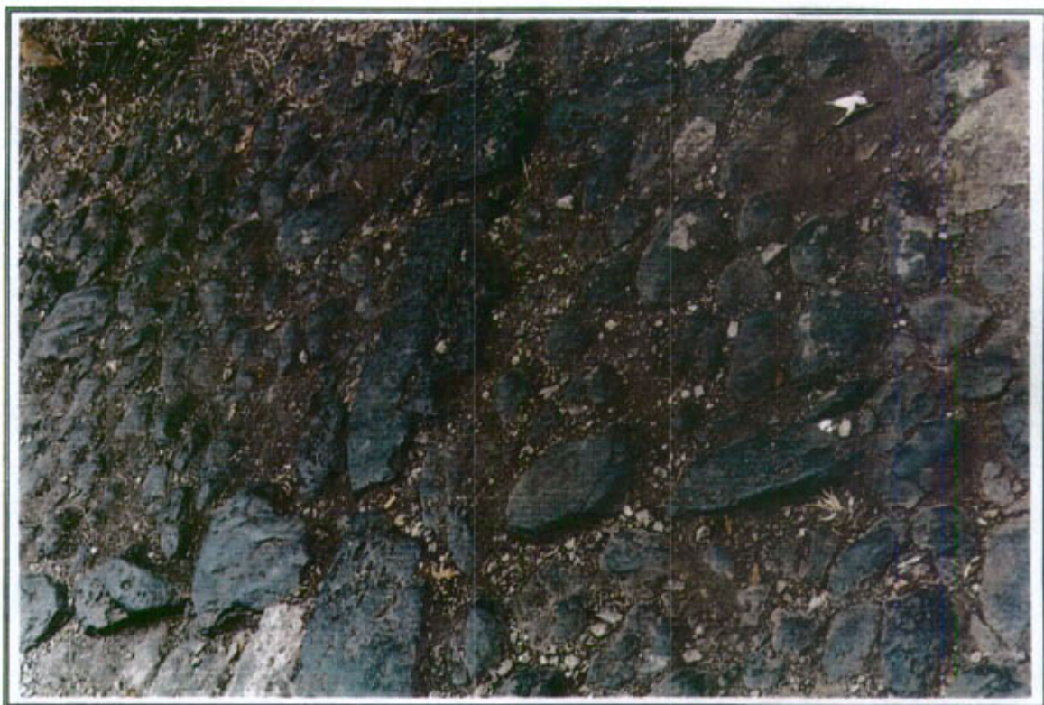
19.2 - Detalle del pavimento empedrado del camino
