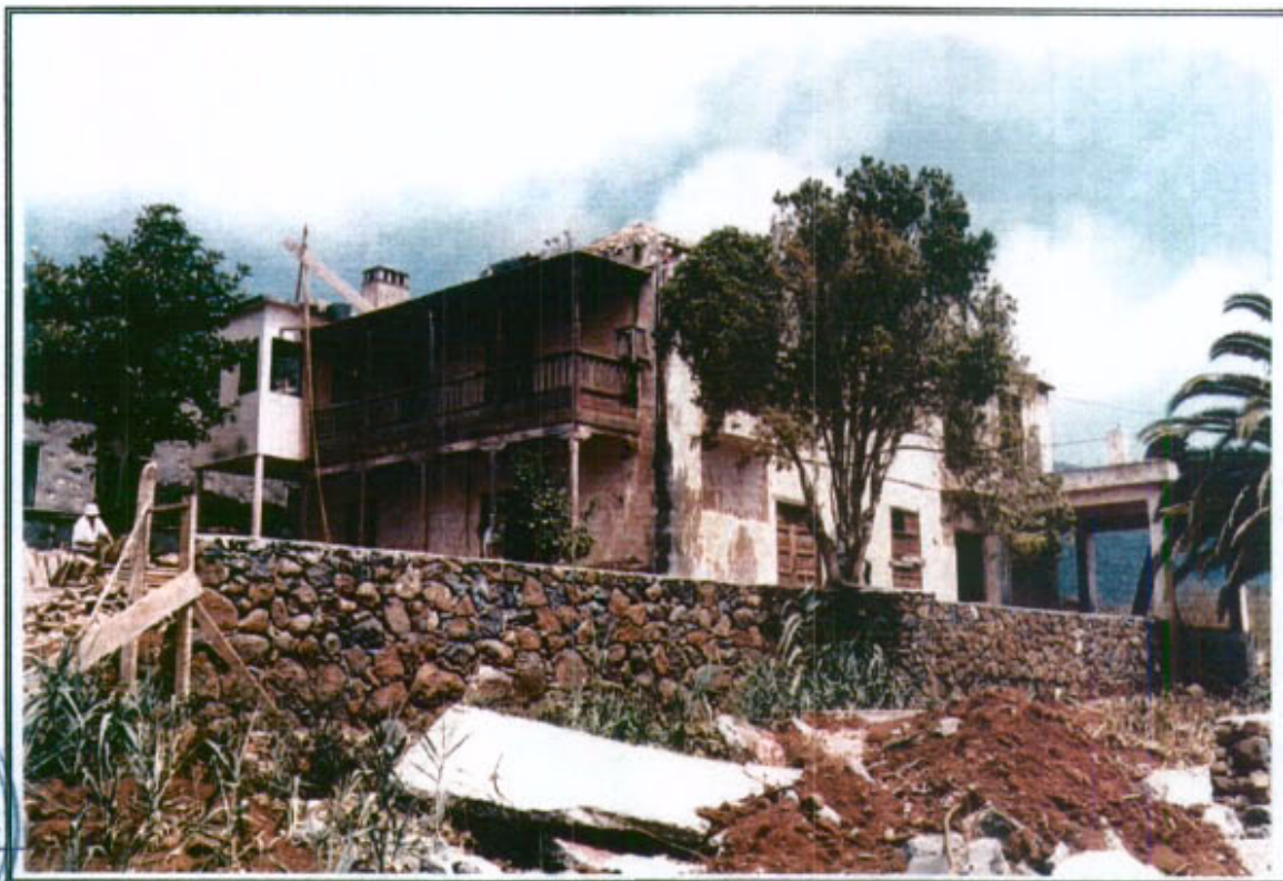
18.1 - Vista general de la edificación desde el Sur-Este
