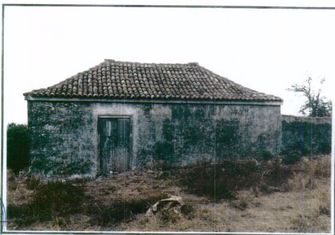
24.3 - Vista general de la edificación en su fachada Norte
