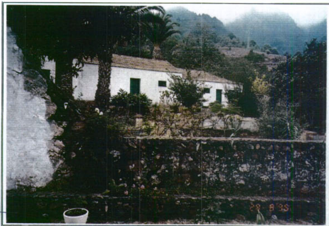
20.1 - Vista parcial de la edificación desde el Este
