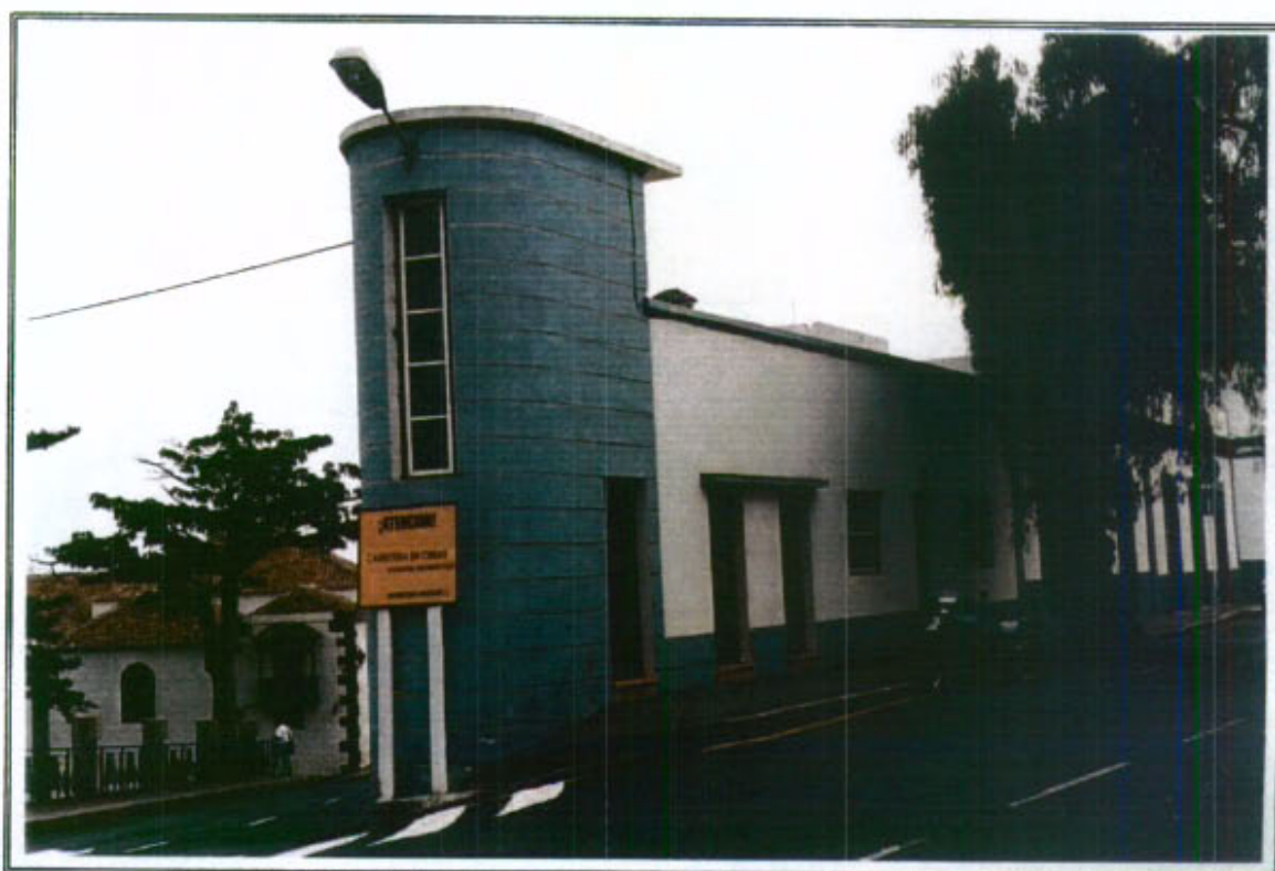
29.2 - Vista general de la edificación desde el Oeste
