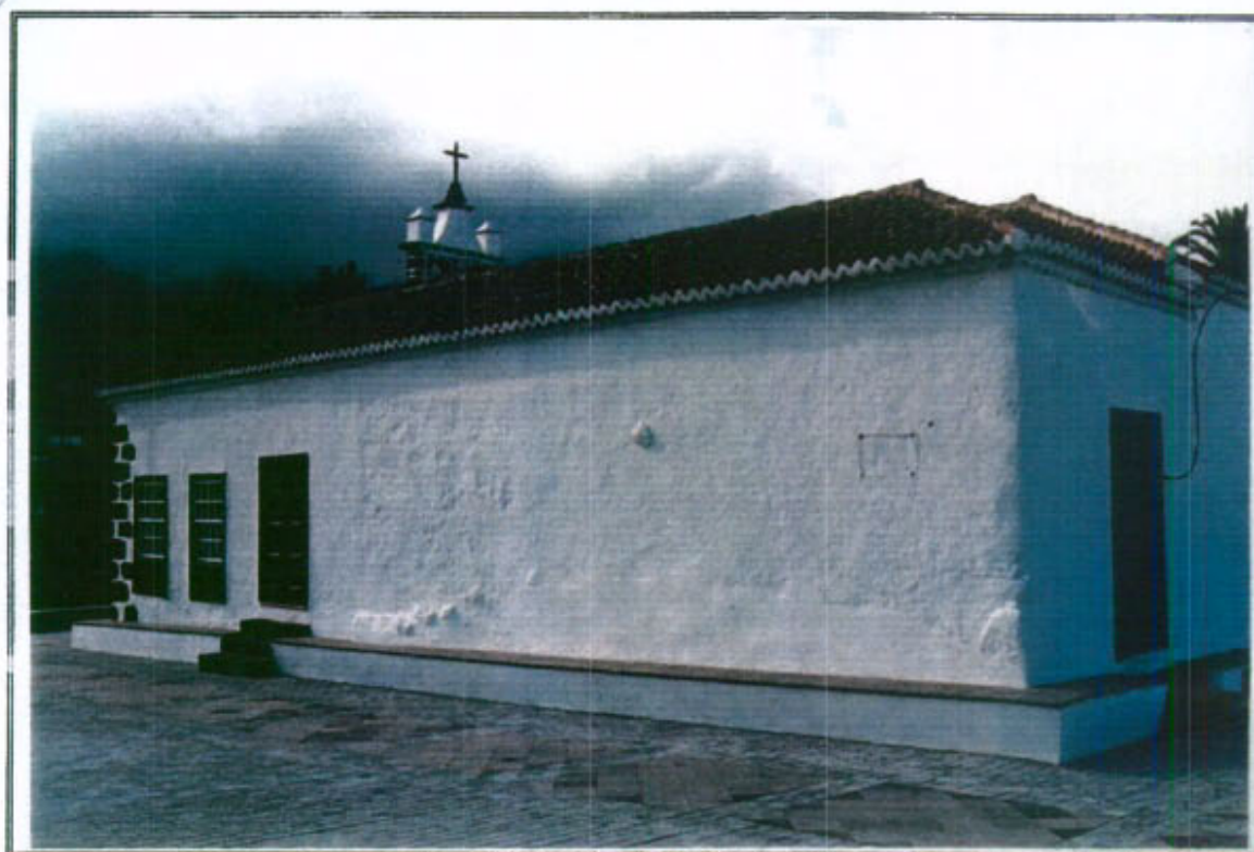
22.2 - Vista parcial de la fachada Este
