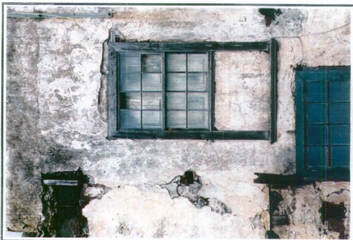
27.6 - Detalle de carpintería exterior de madera con contraventanas interiores
