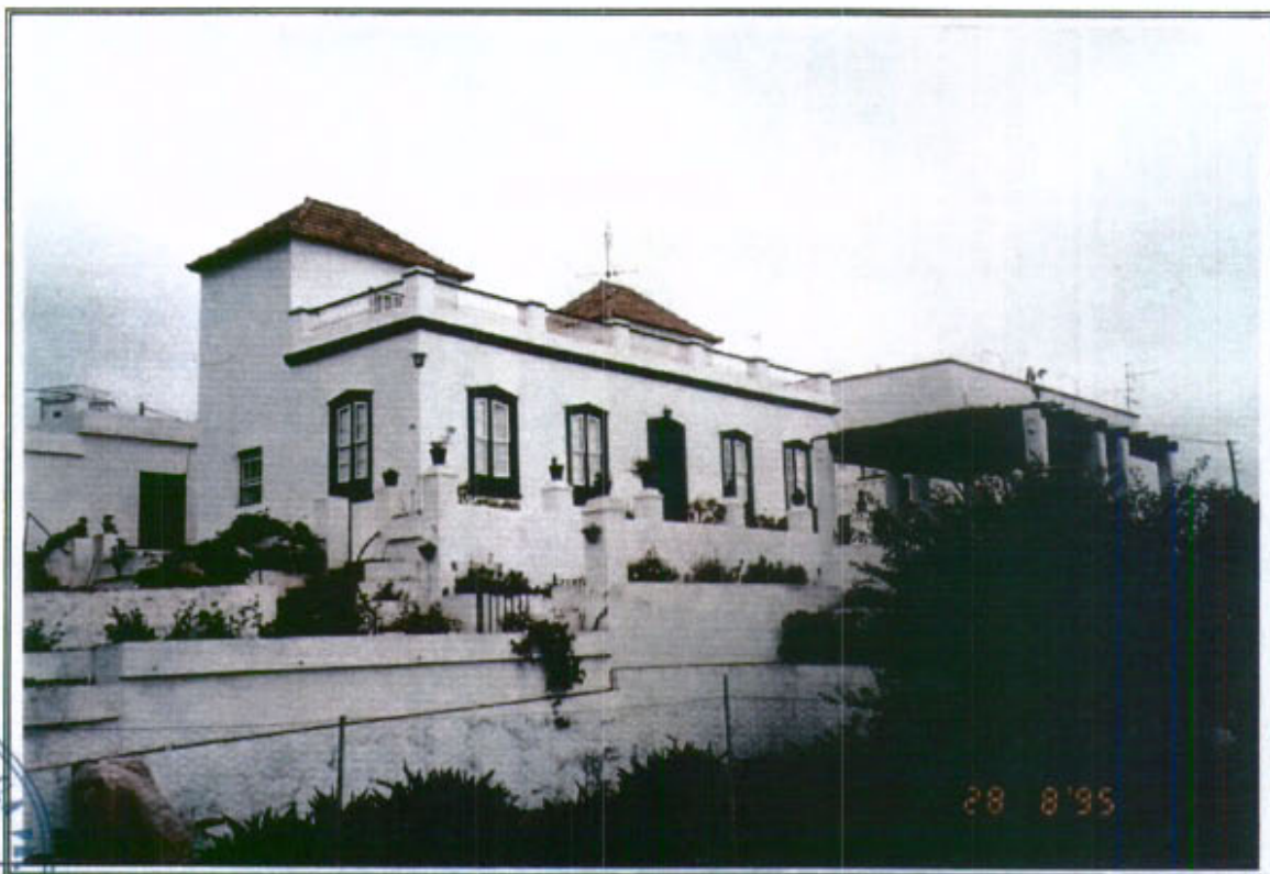
21.1 - Vista general de la edificación desde el Suroeste
