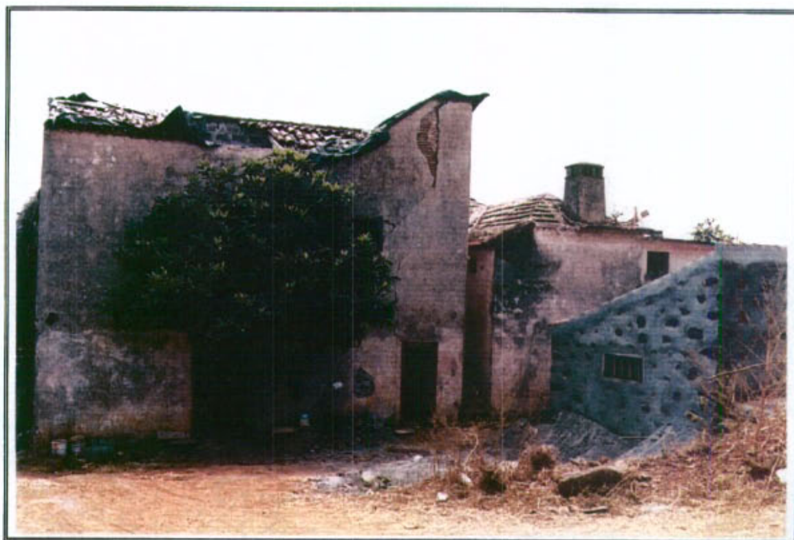
18.4 - Vista parcial de la edificación desde el Oeste
