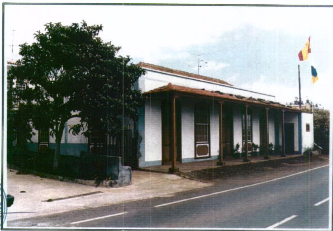
25.1 - Vista general de la edificación desde el Sureste
