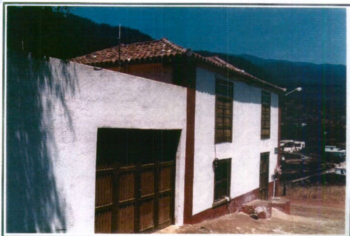
17.2 - Vista general fachada Este
