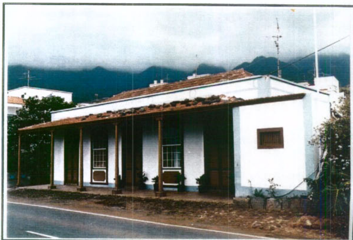
25.2 - Vista general de la edificación desde el Noreste
