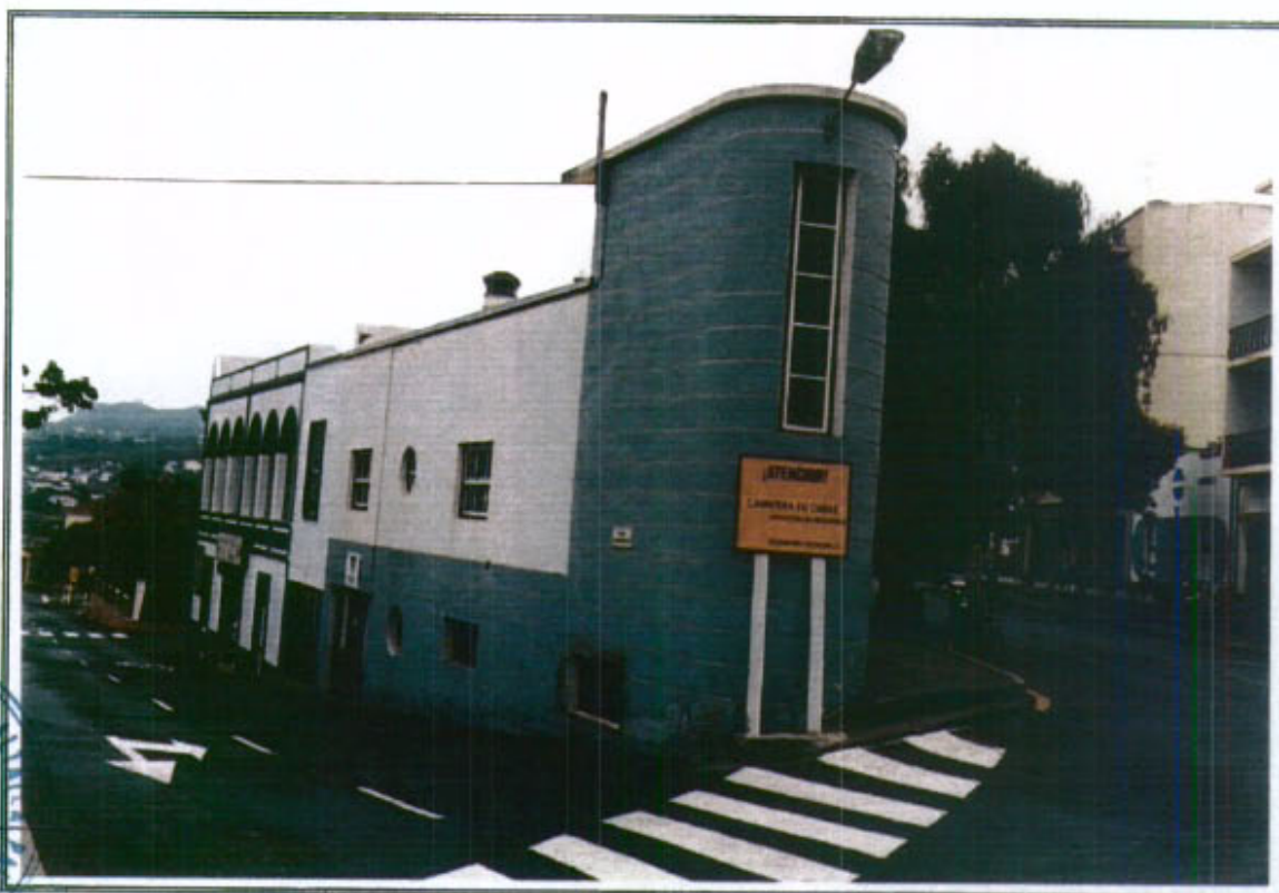
29.1 - Vista general de la edificación desde el Norte
