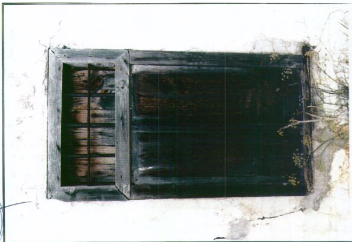
24.5 - Detalle de carpintería exterior de madera (puerta)
