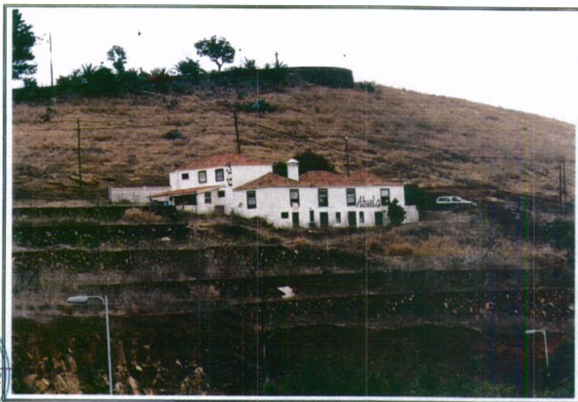
23.1 - Vista general de fachada Sur-Este
