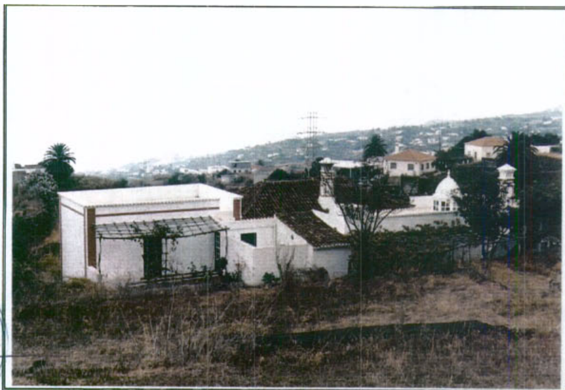
26.1 - Vista general de la edificación desde Noroeste
