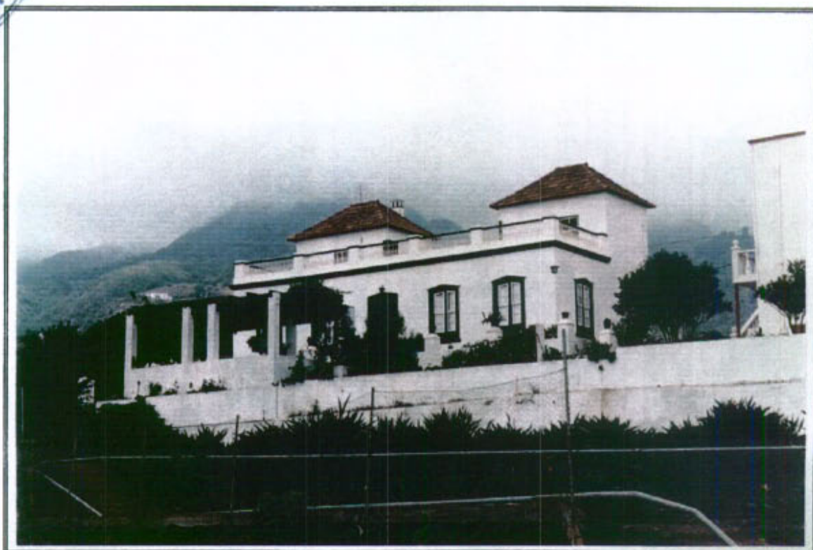
21.2 - Vista general de la edificación desde el Sureste
