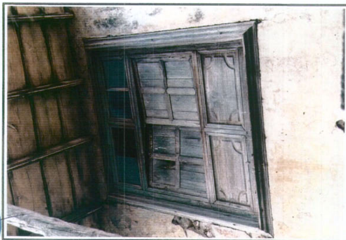
27.5 - Detalle de carpintería exterior de madera con contraventanas interiores
