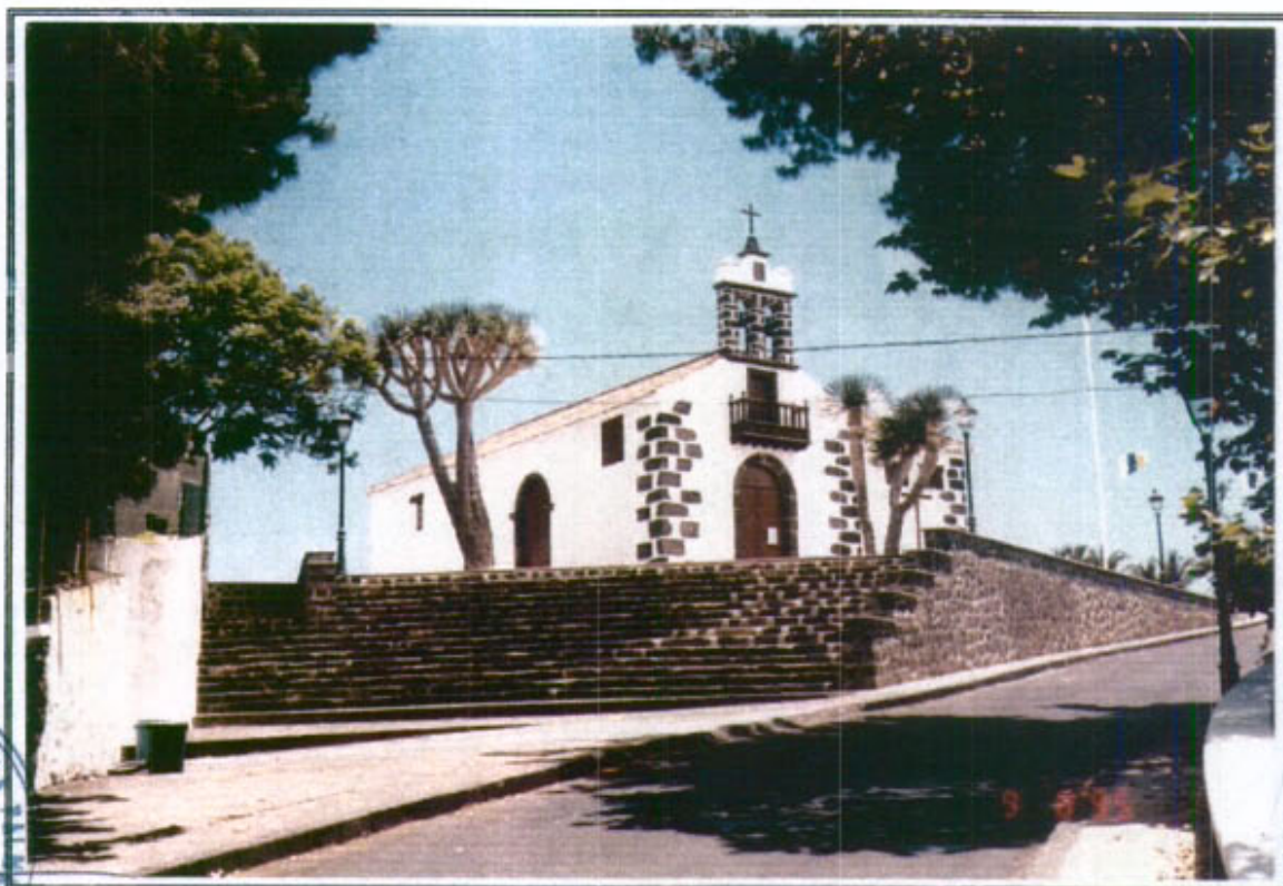
22.1 - Vista general desde la carretera de acceso
