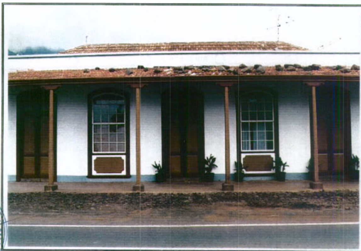
25.3 - Detalle del alpendre, en la fachada Este
