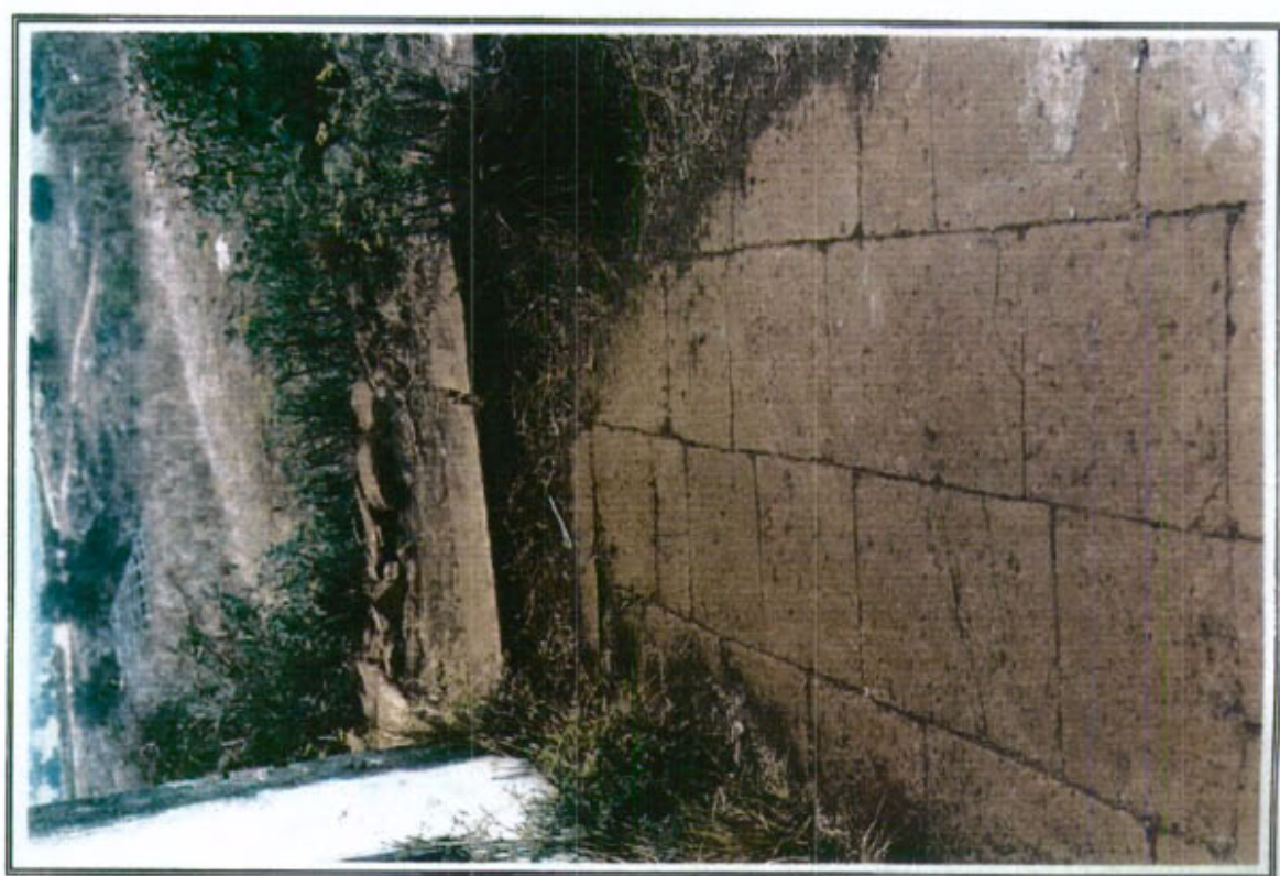
24.8 - Detalle de pavimento de piezas regulares serradas de piedra basáltica en acceso a vivienda
