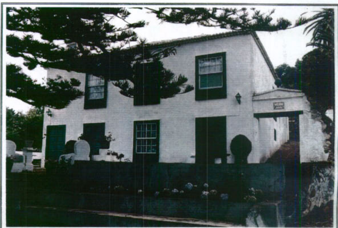
20.2 - Vista parcial de la edificación desde el Este
