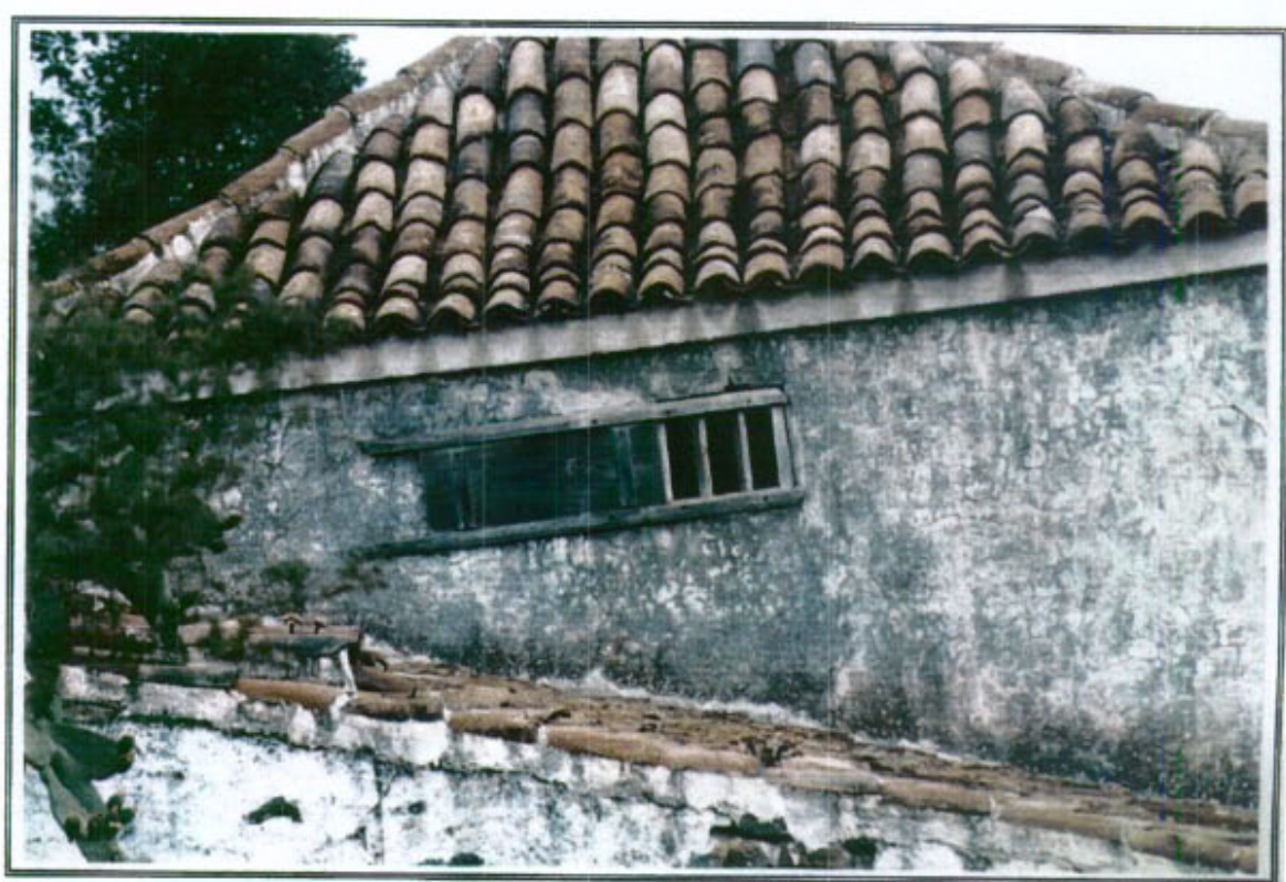
24.4 - Detalle de cubierta y carpintería de ventana en fachada Sur
