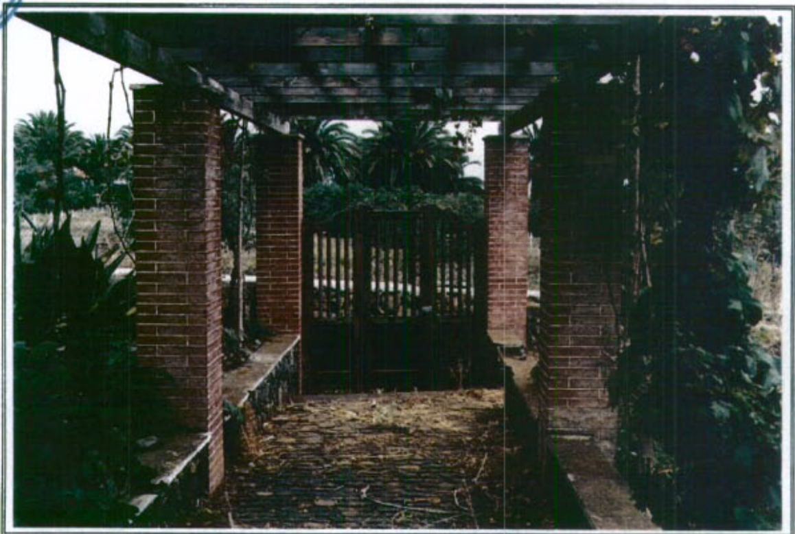
13.4 - Detalle de la pérgola de entrada desde el Norte
