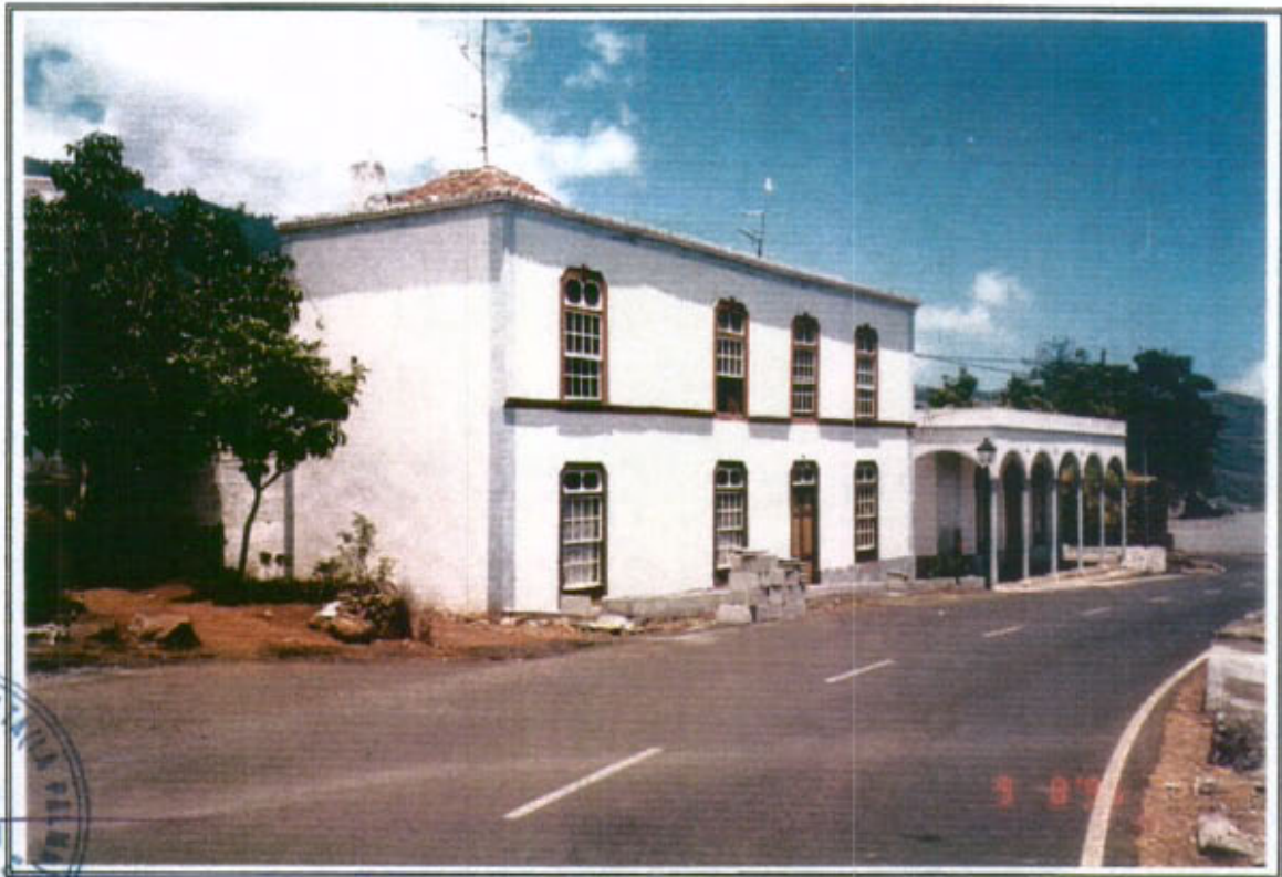
6.1 - Vista general de la edificación desde su fachada Sureste
