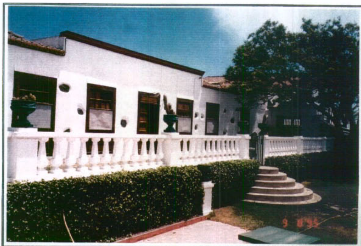
12.2 - Detalle del edificio en su fachada Oeste
