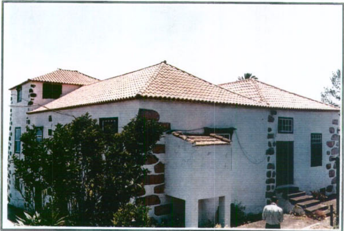
16.4 - Vista General desde el Este. Detalle de horno.
