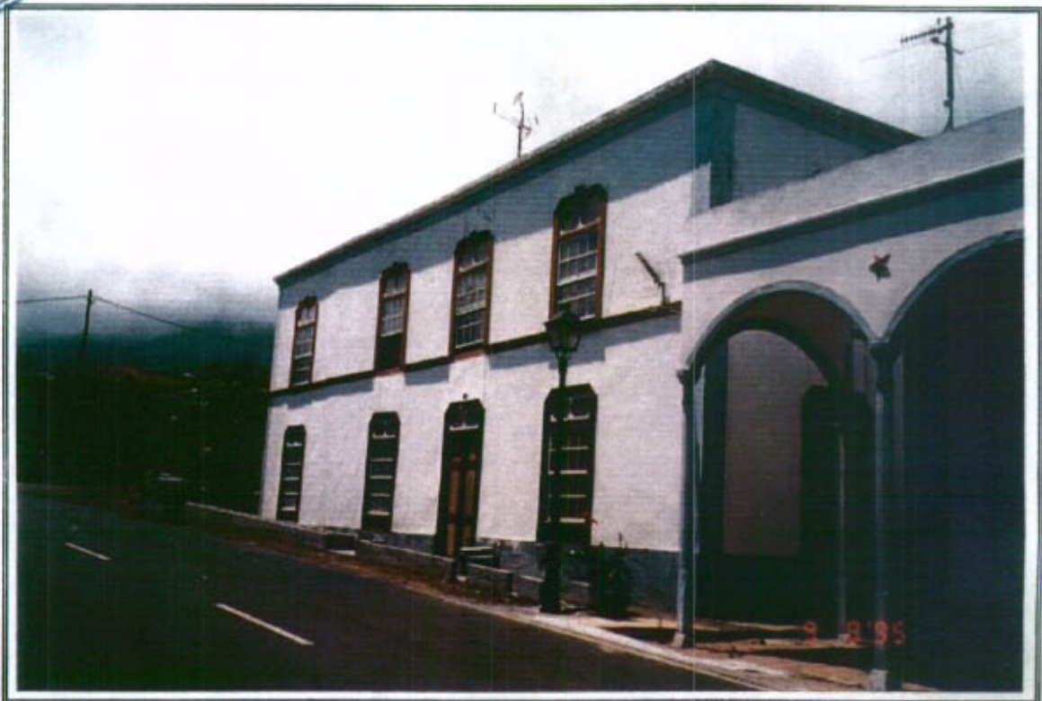
6.2 - Vista general de la edificación desde su fachada Noreste
