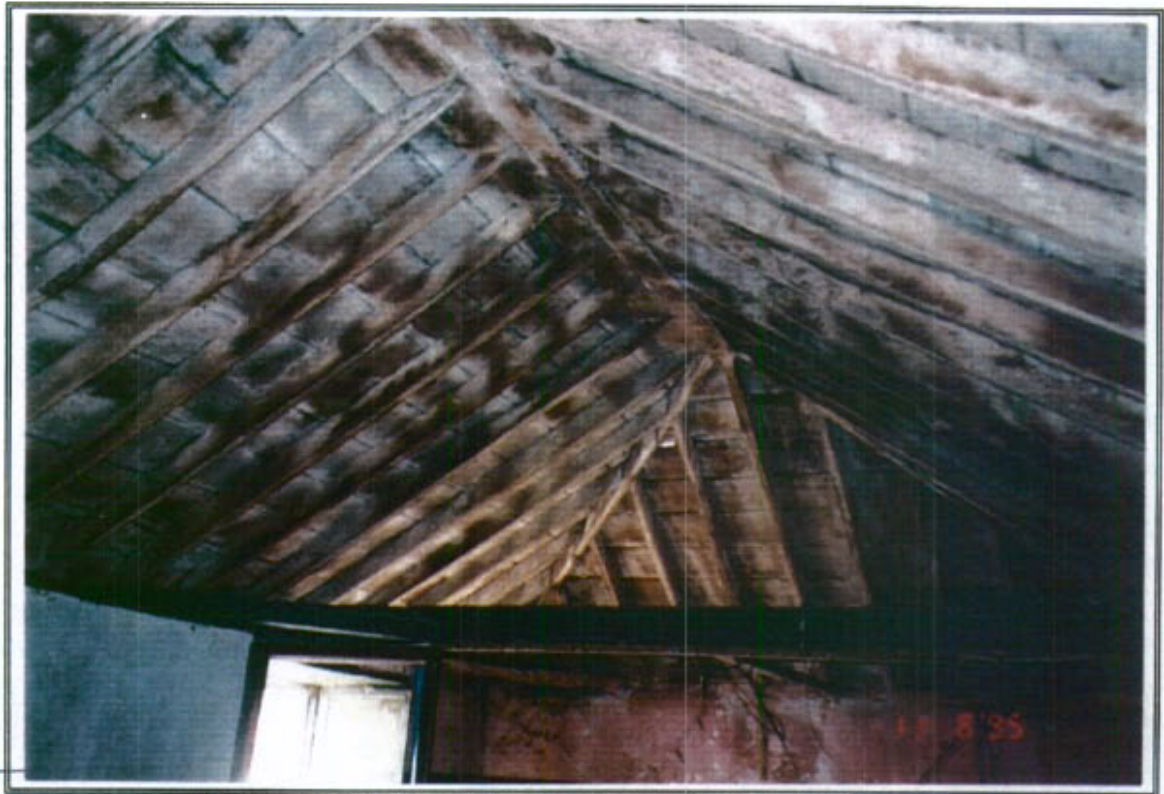
14.9 - Detalle del interior de la cubierta en antigua zona de almacenes
