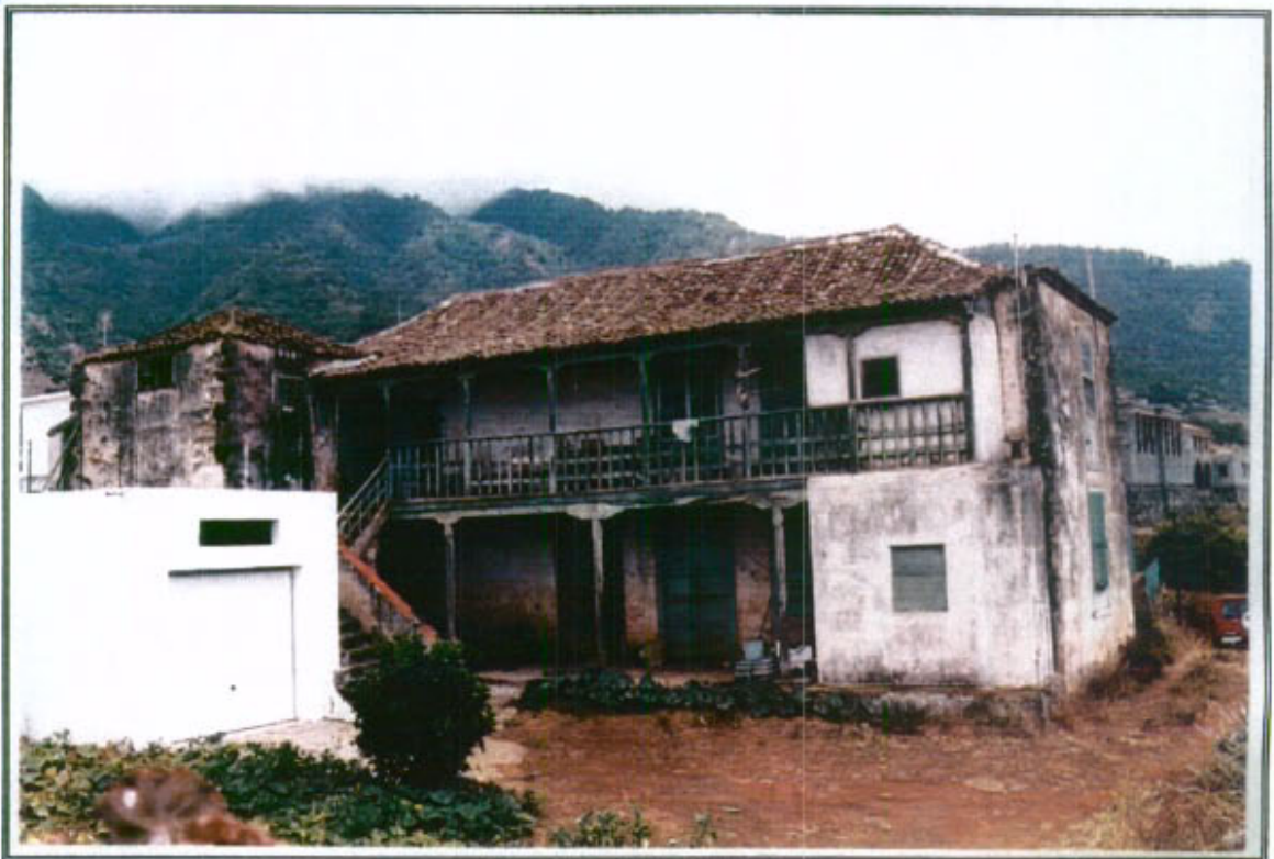
15.2 - Vista Fachada Sur
