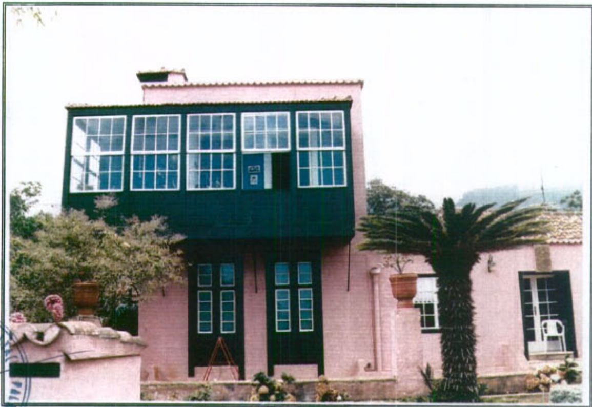
14.3 - Vista parcial de la fachada Este. Detalle de la balconada cerrada
