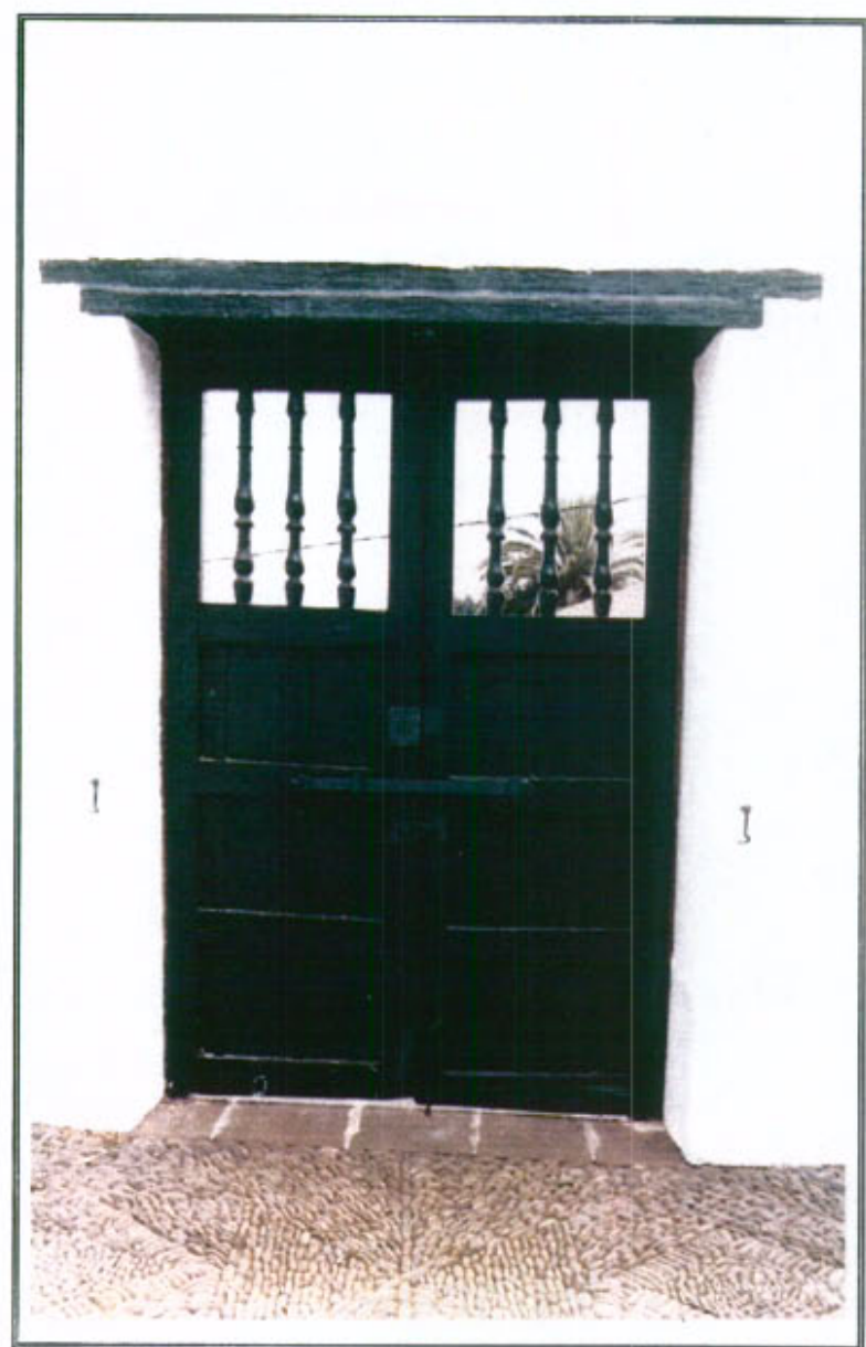
8.3 - Vista interior puerta de acceso. Detalle de carpintería
