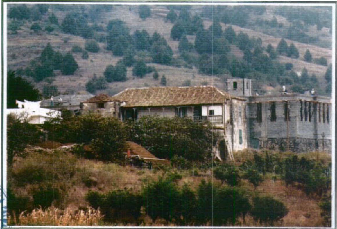
15.1 - Vista General de la edificación
