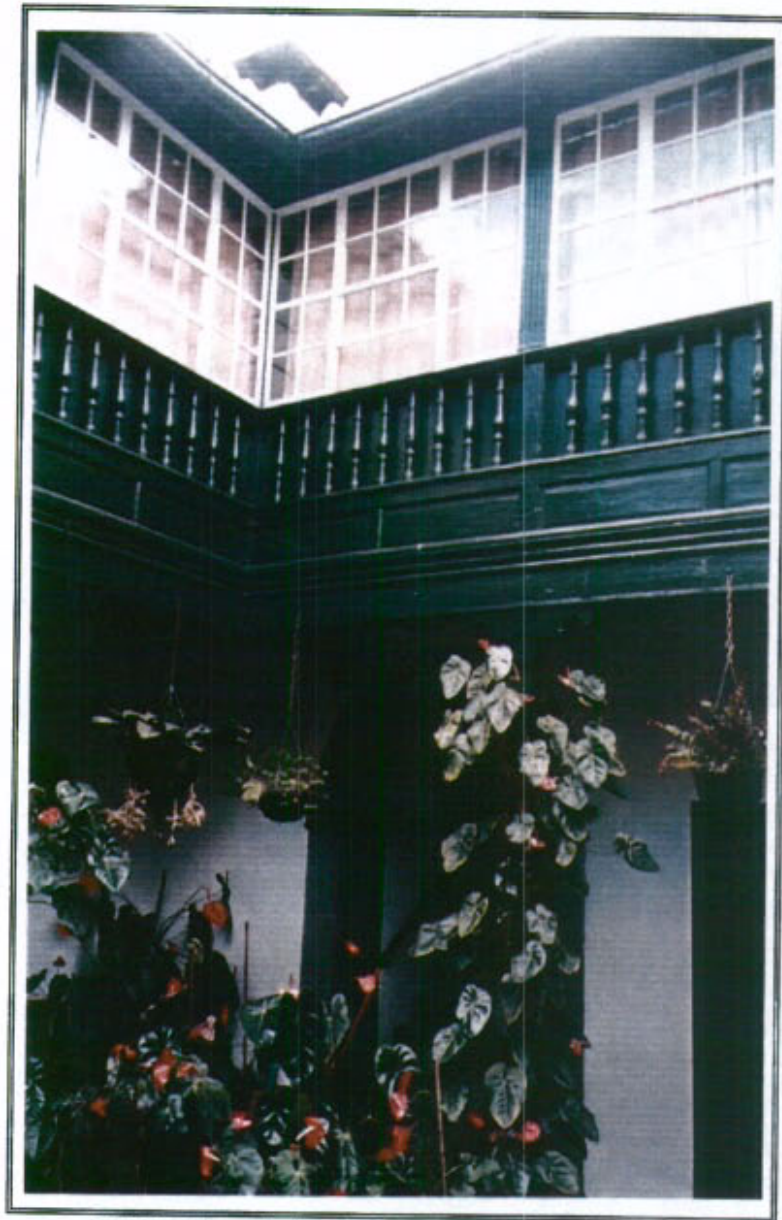
7.3 - Detalle patio interior. Detalle galería tradicional
