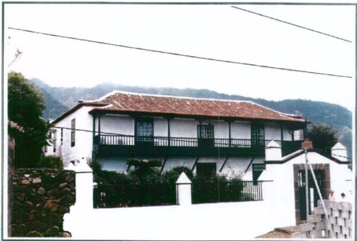
7.2 - Vista fachada Sur
