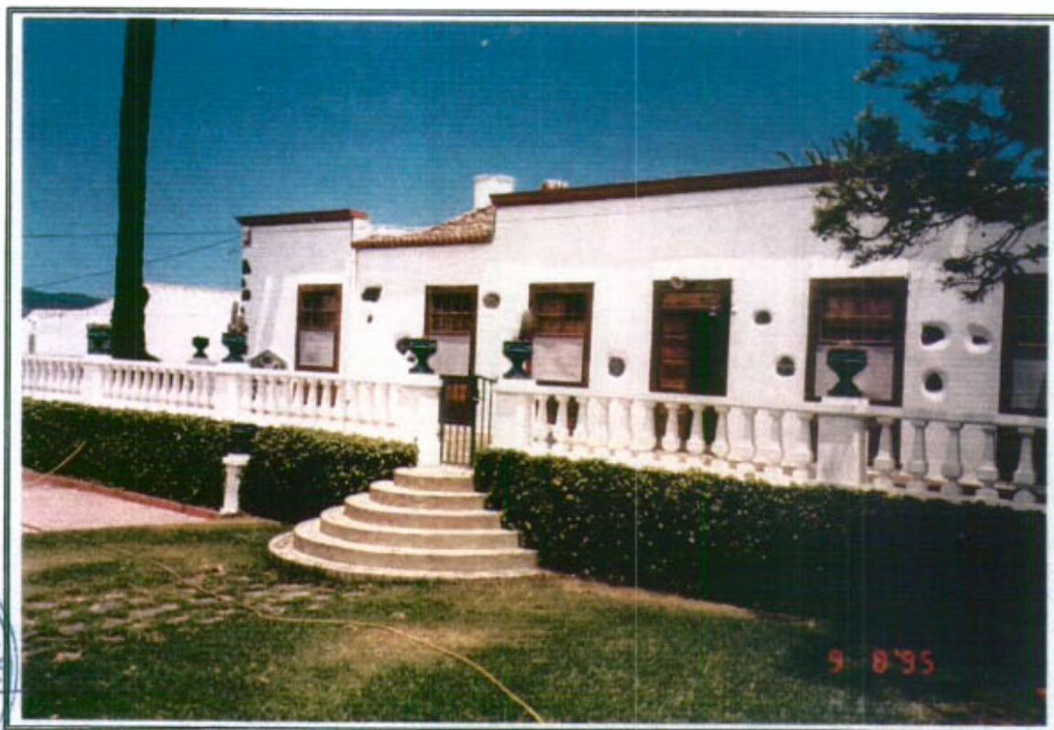
12.1 - Vista general de la edificación en sus fachada Oeste
