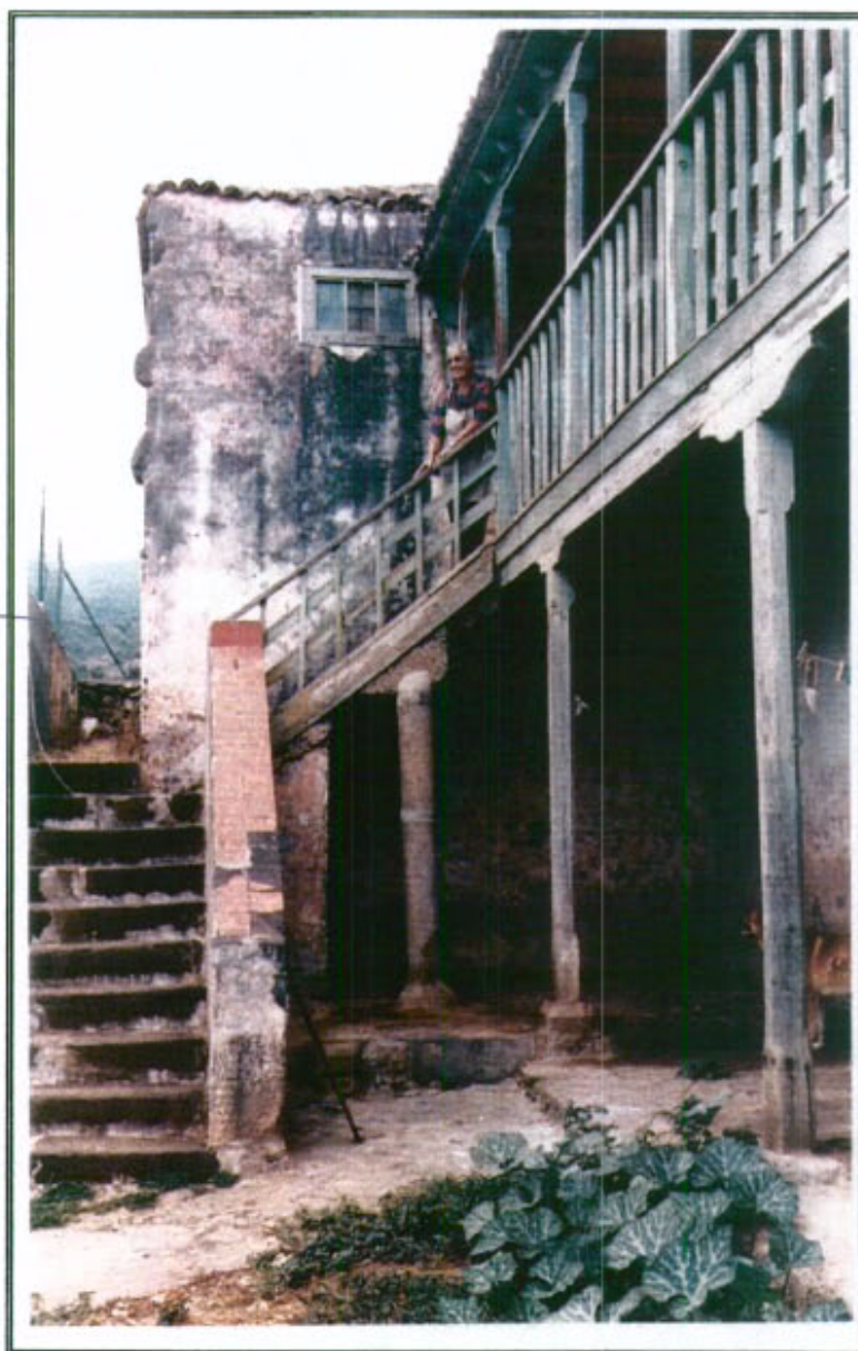
15.5 - Detalle de galería exterior y acceso a planta inferior
