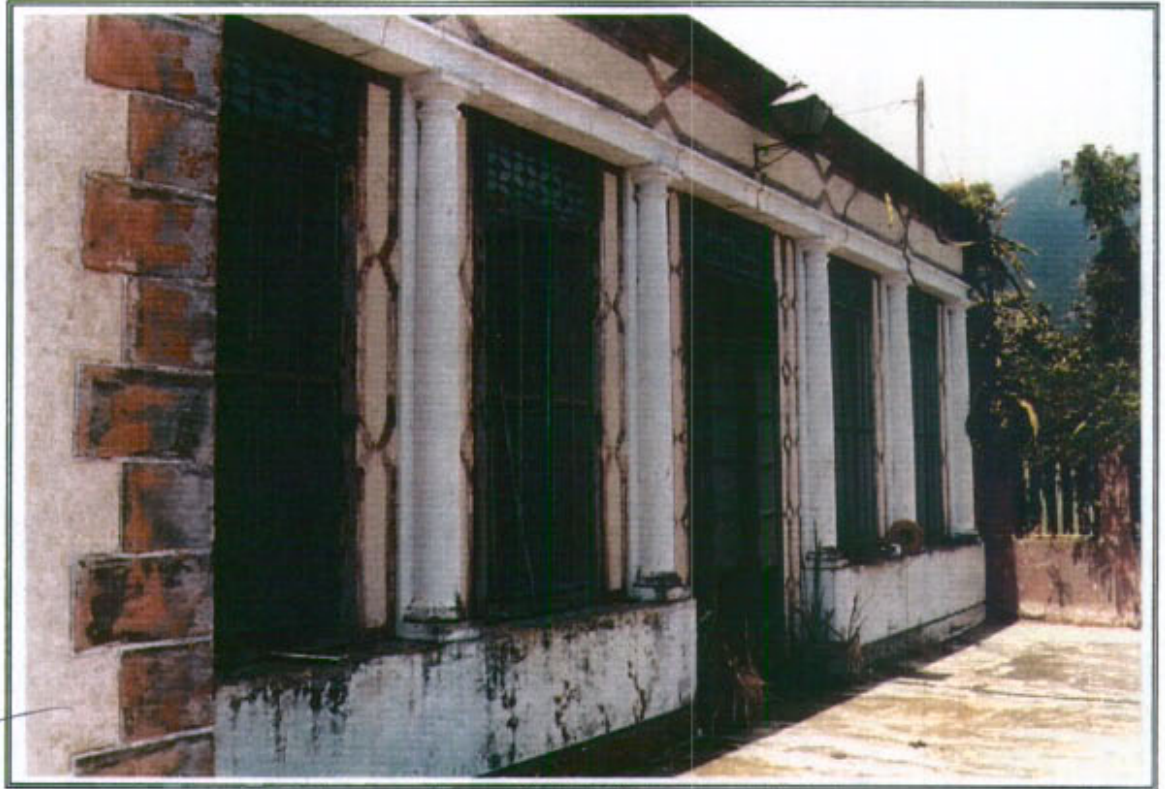
9.7 - Vista general de un Ala del edificio en su fachada Norte
