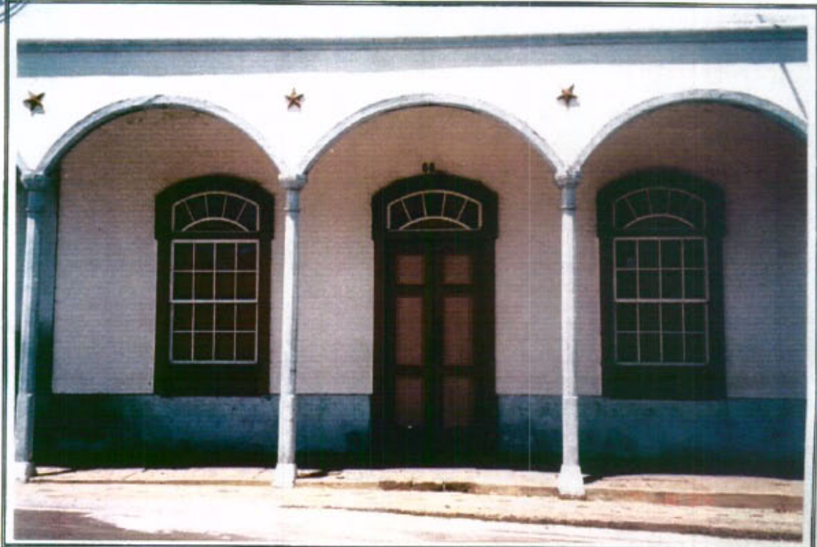
5.2 - Detalle del alpendre en su fachada Este
