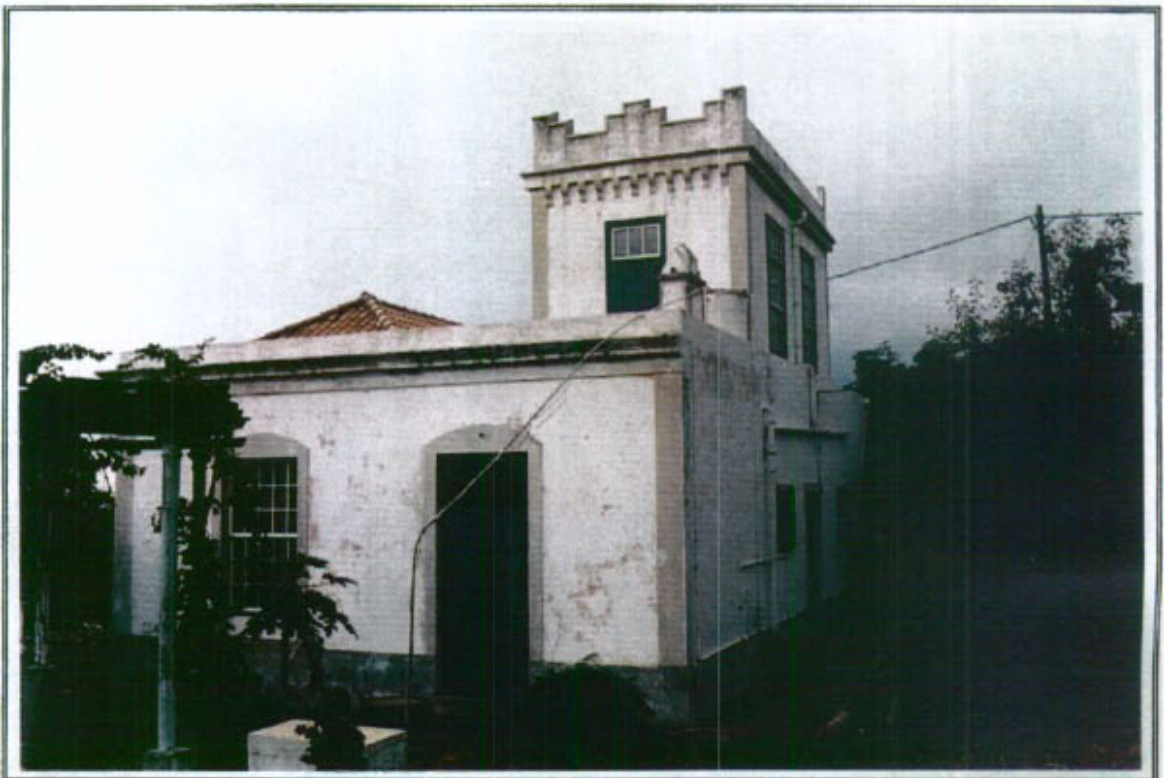
13.2 - Vista general de la edificación desde el sureste
