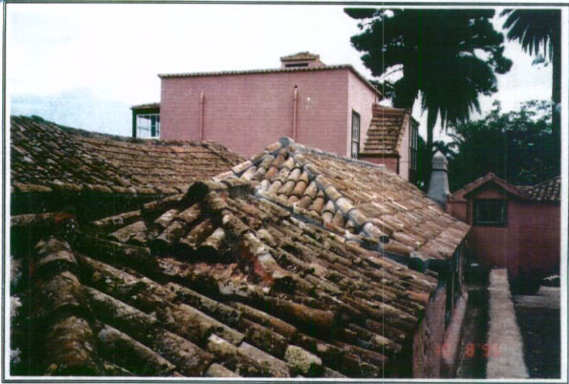
14.4 - Vista parcial de la fachada Norte. Cubiertas.
