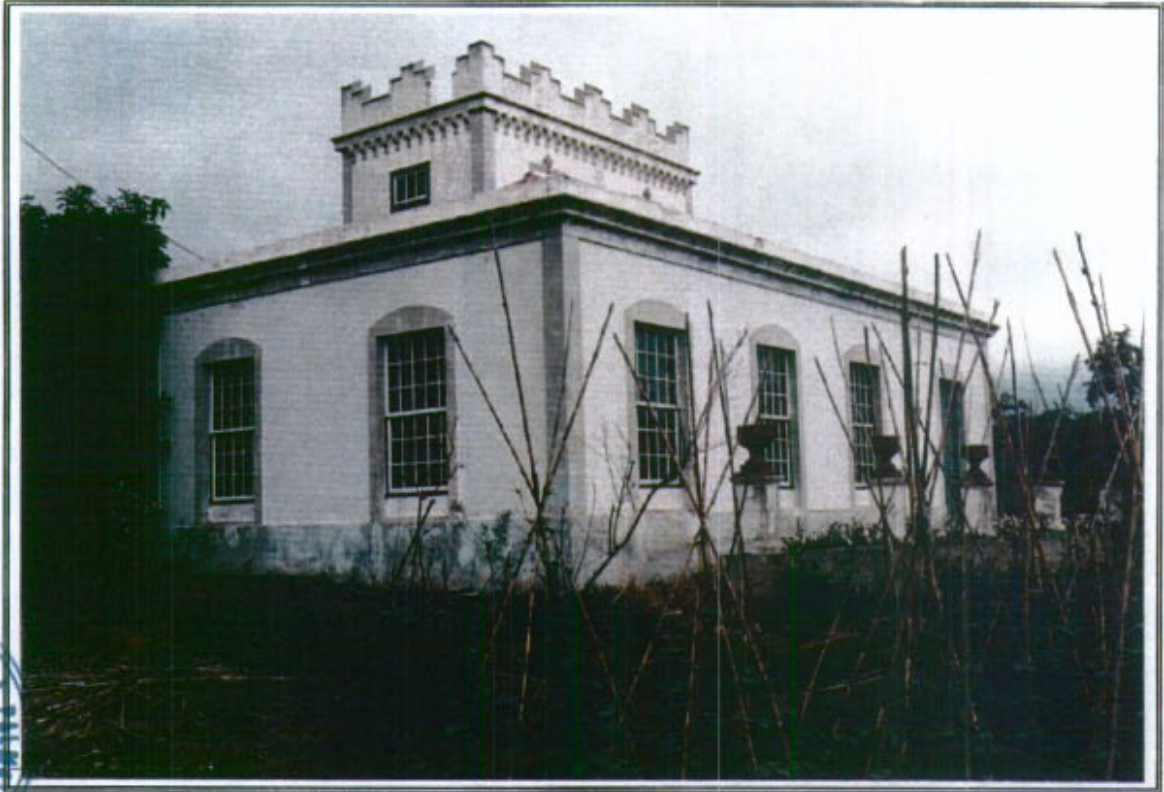
13.1 - Vista general de la edificación desde el Noreste
