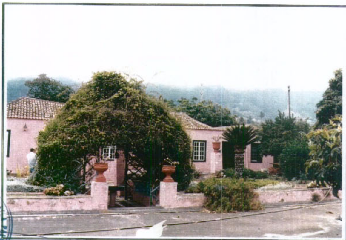
14.1 - Vista general del edificio desde su fachada Este
