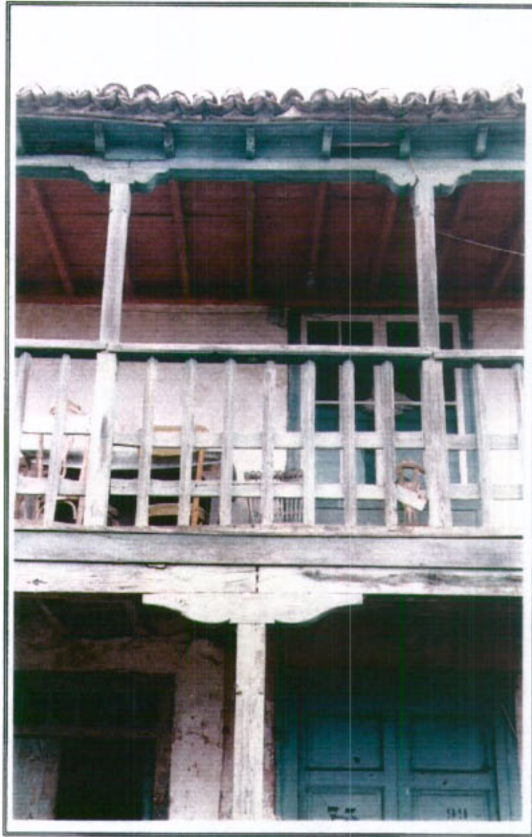
15.6 - Detalle galería exterior y estructura tradicional de cubierta
