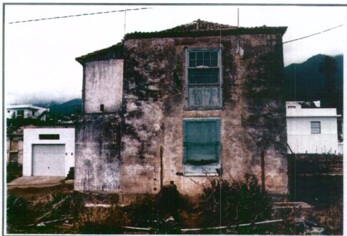
15.4 - Vista Fachada Este. Detalle de esgrafiados
