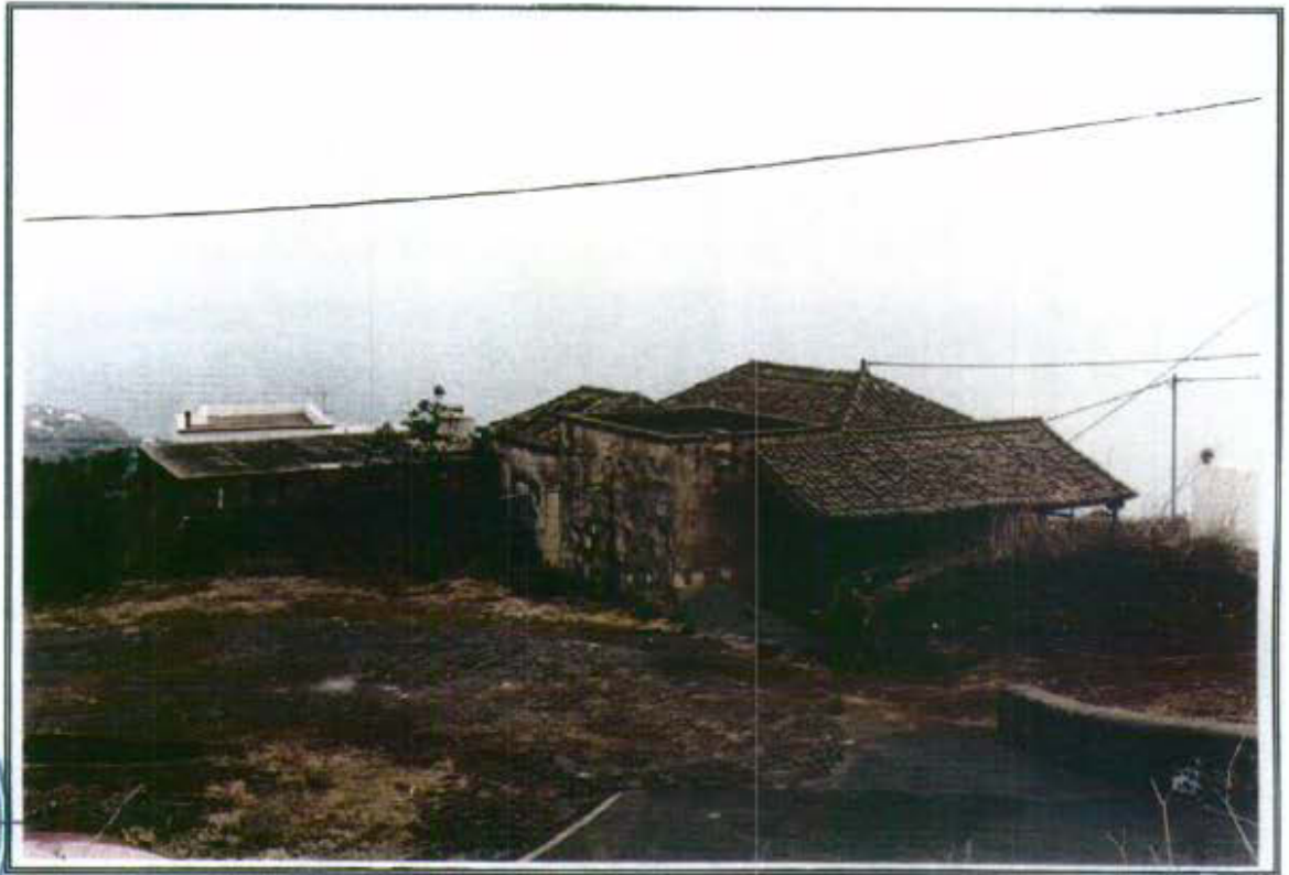
4.1 - Vista general de la edificación desde el Suroeste
