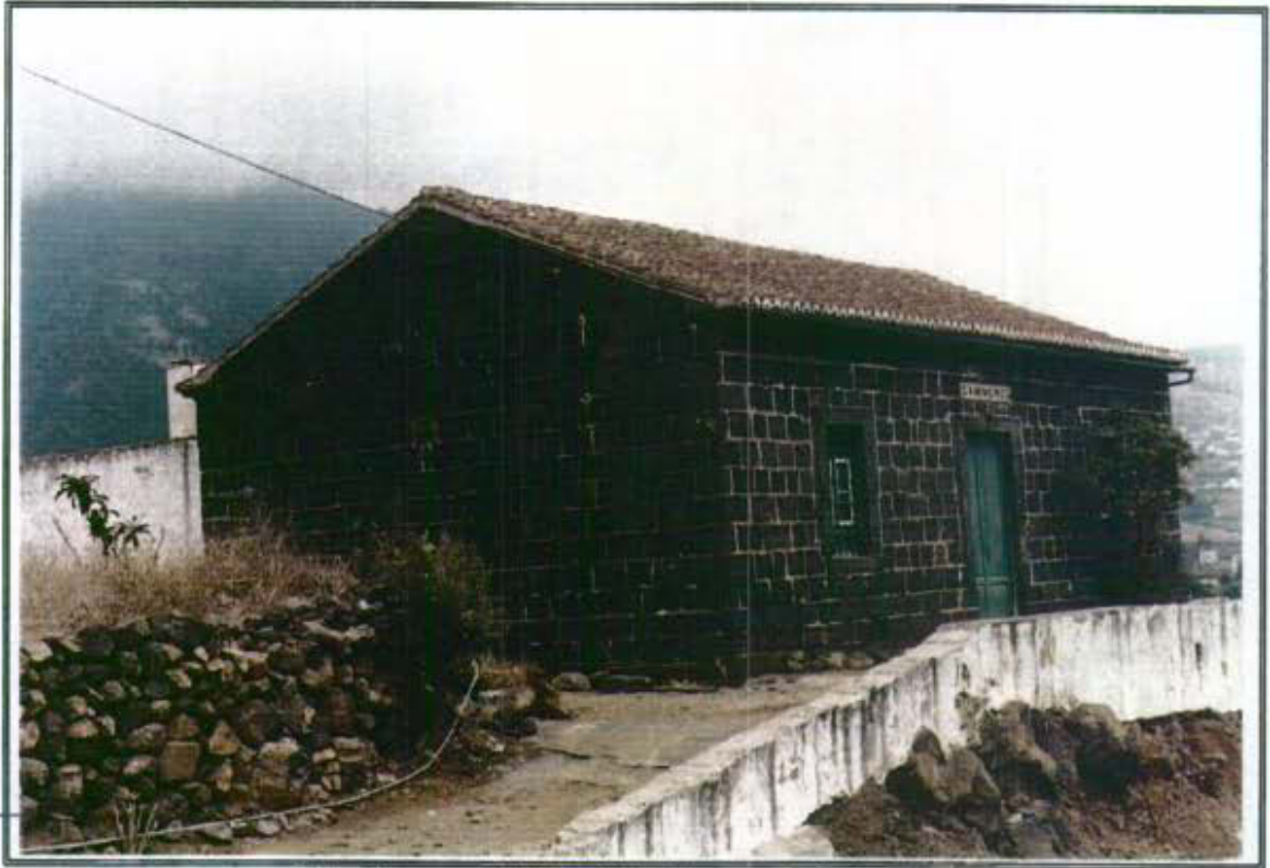
3.1 - Vista general de la edificación en su fachada Este
