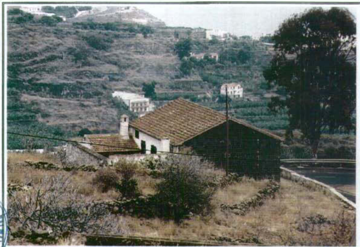
3.3 - Vista general de la edificación en su fachada Sur
