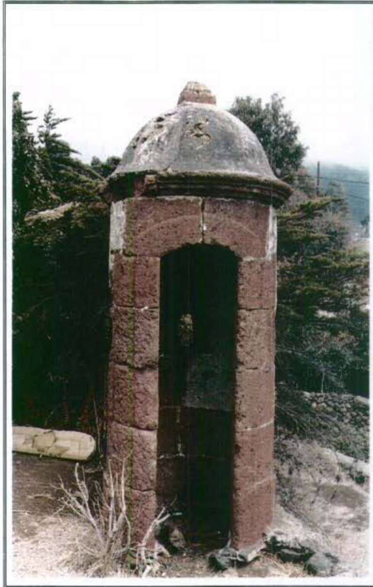
1.1 - Vista general de la edificación desde el Este
