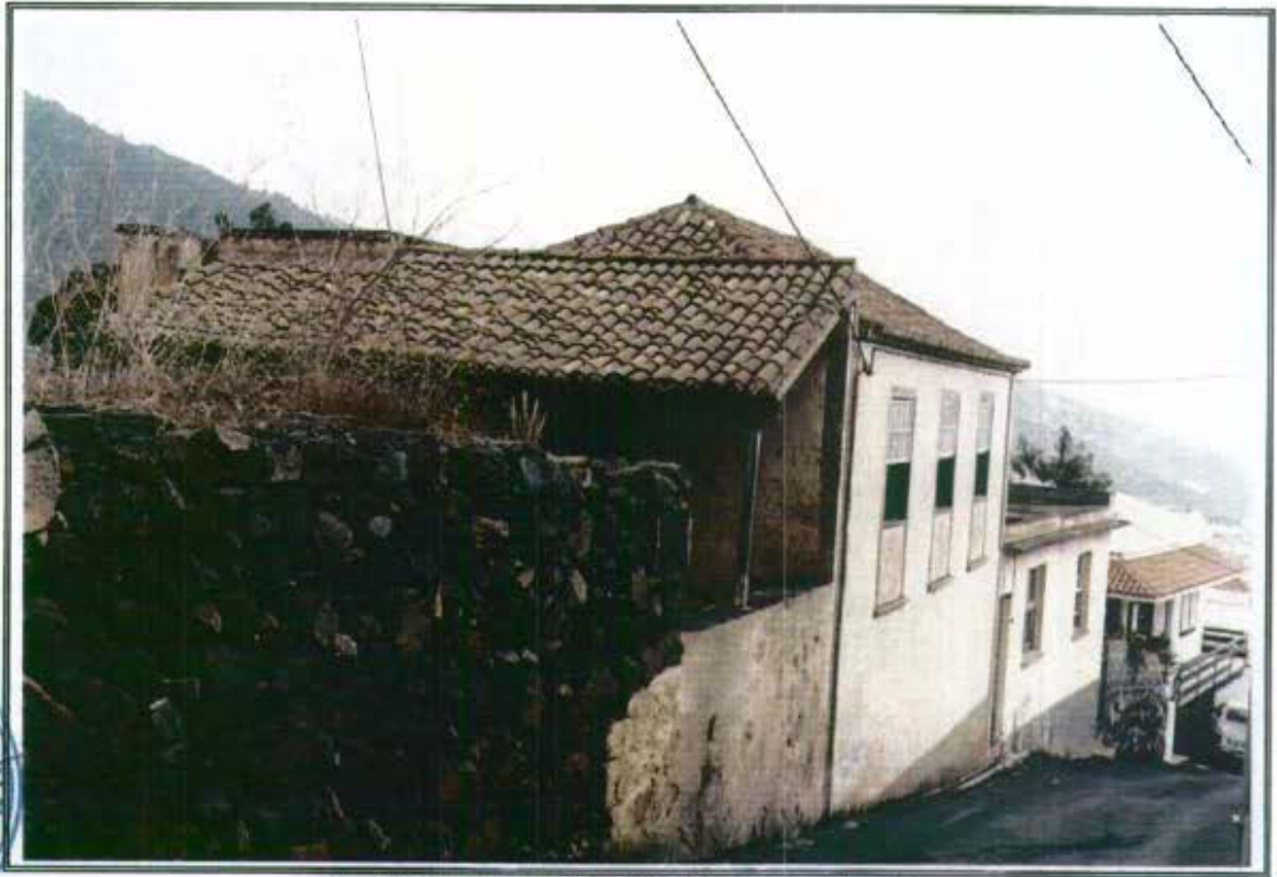
4.3 - Vista parcial de la edificación desde el Sureste
