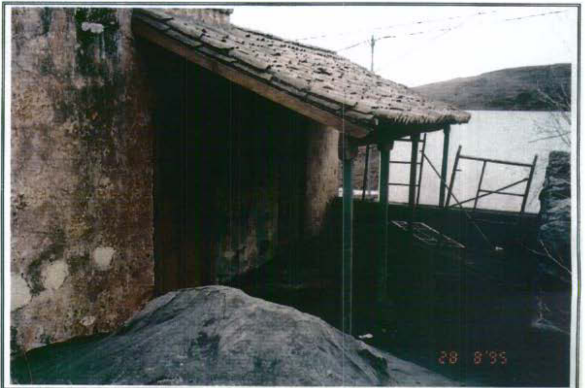
4.2 - Vista del alpendre desde el oeste
