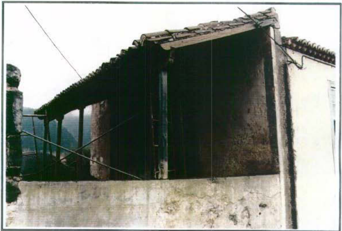
4.4 - Vista del alpendre desde el este
