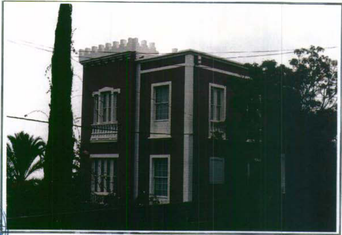
2.1 - Vista general de la edificación en su fachada Norte
