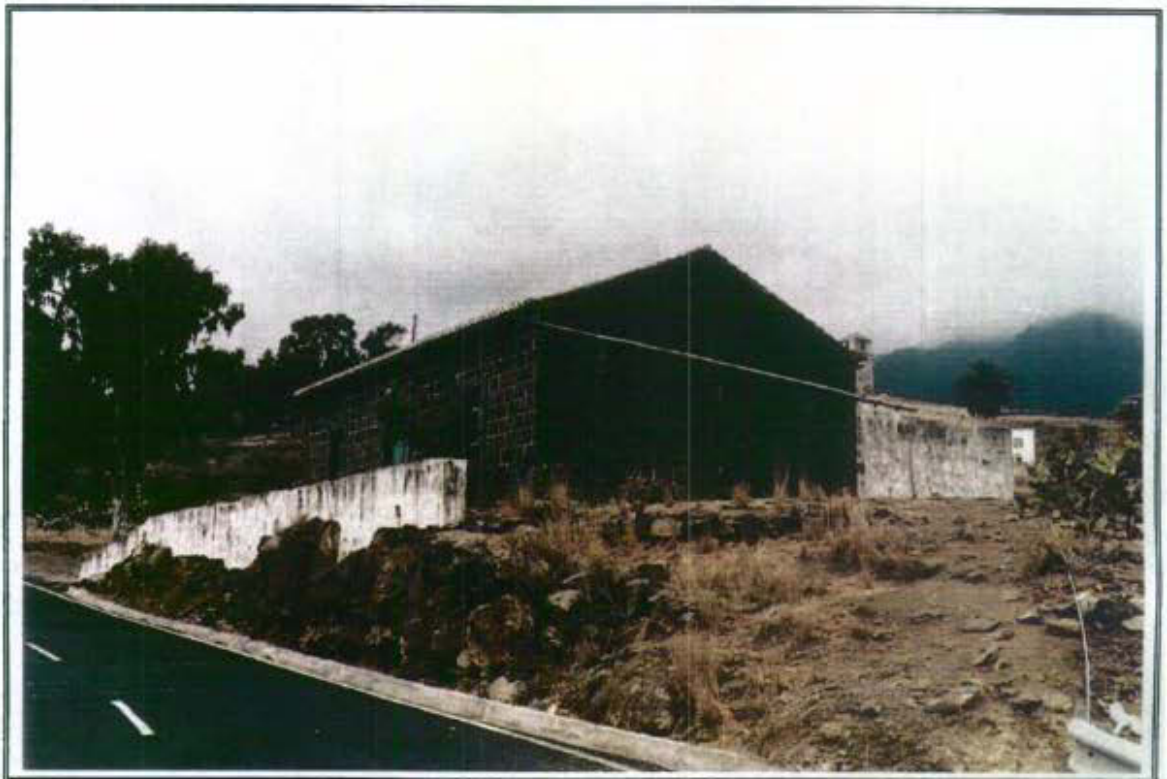
3.2 - Vista general de la edificación en su fachada Norte
