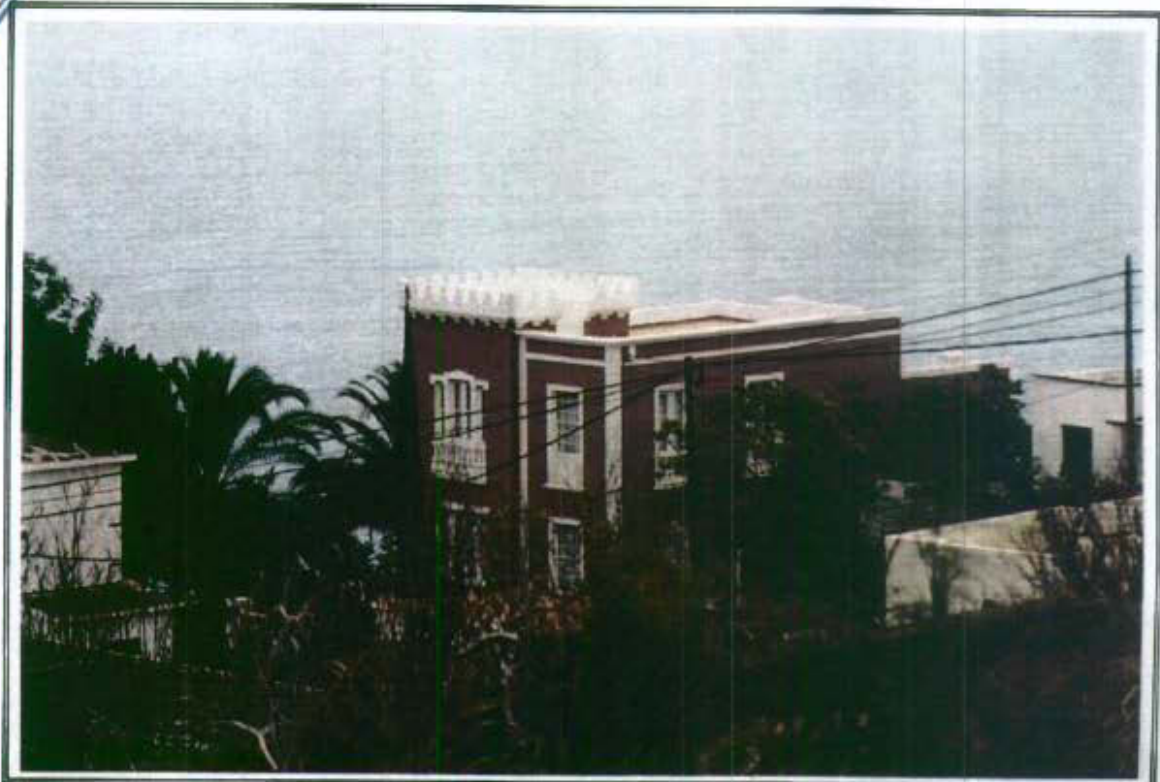
2.2 - Vista general de la edificación en su fachada Oeste
