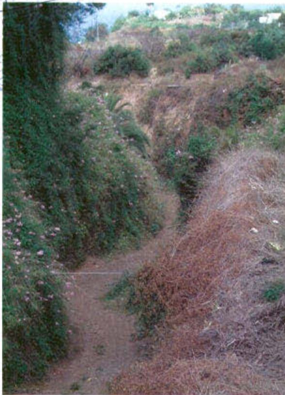
Imagen del Cauce del Llanito aguas abajo del puente metros aguas arriba.
