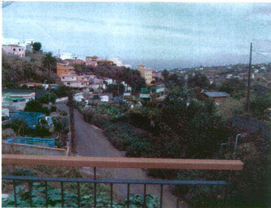
Imagen del cauce de Aguacencio invadido por viviendas
