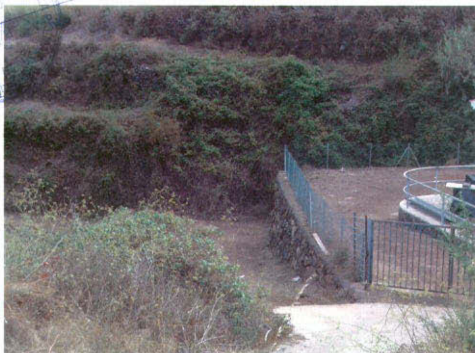
Imagen de Invasión del cauce por edificaciones
