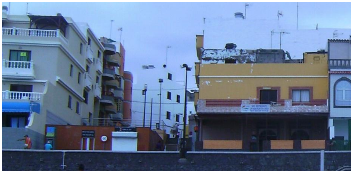
Fotografía de detalle de la fachada del tramo 2
