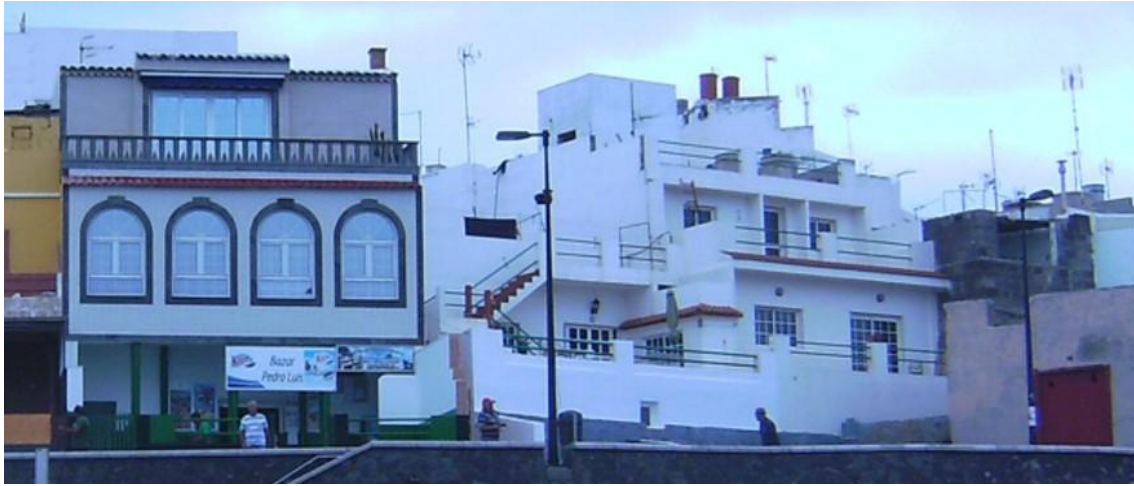
Fotografía de detalle de la fachada del tramo 2
