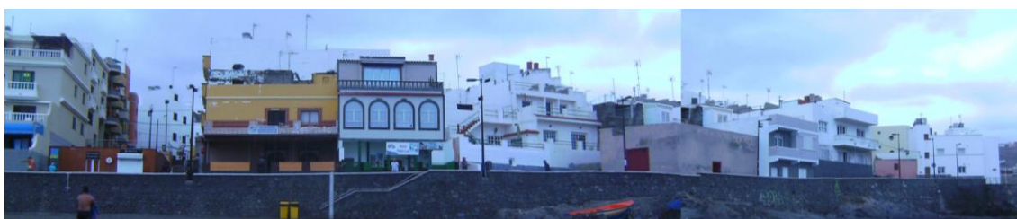
Fotografía de fachada del tramo 2
