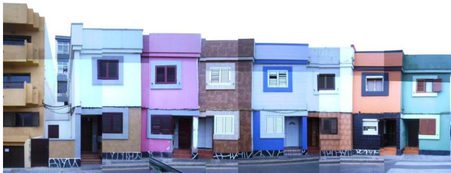
Fotografía de fachada del tramo I
