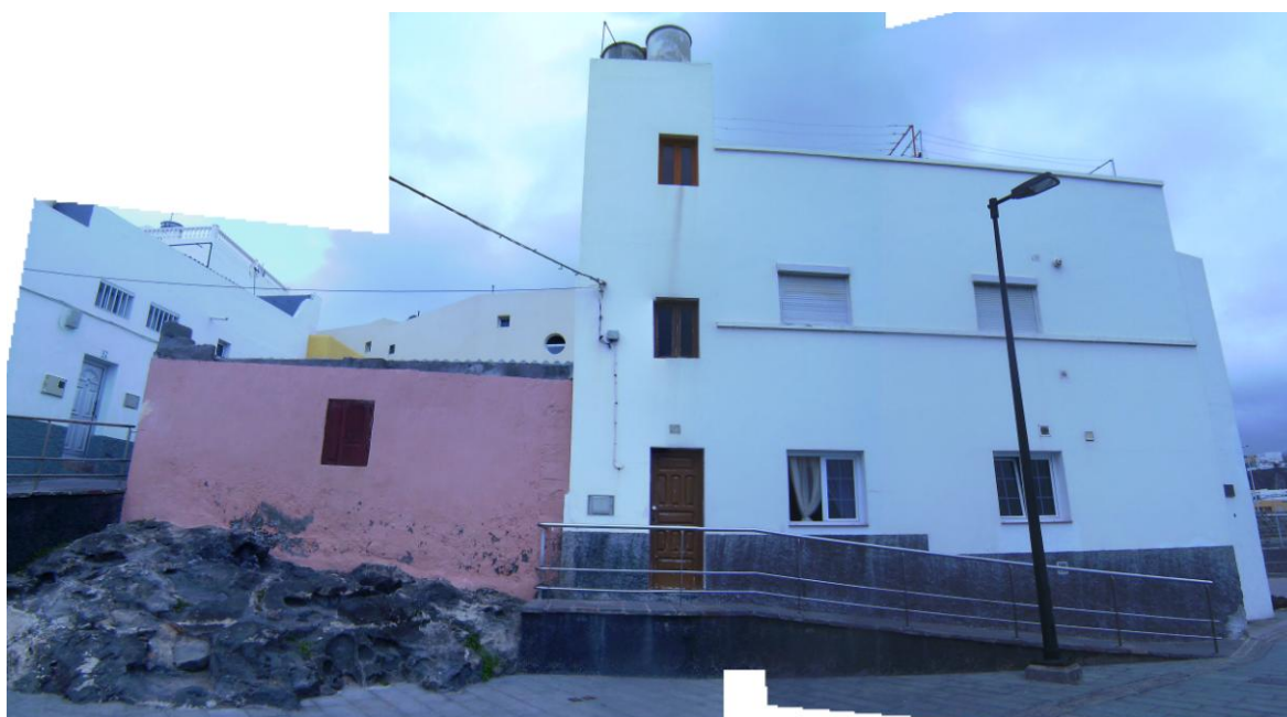
Fotografía de detalle de la fachada del tramo 4
