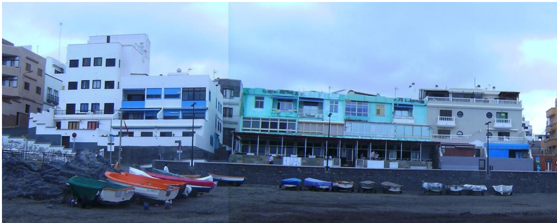
Fotografía de fachada del tramo I
