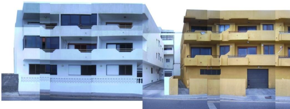
Fotografía de detalle de la fachada del tramo 2
