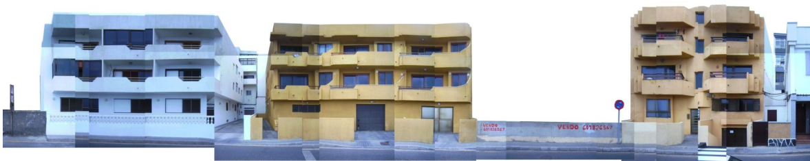
Fotografía de fachada del tramo 2
