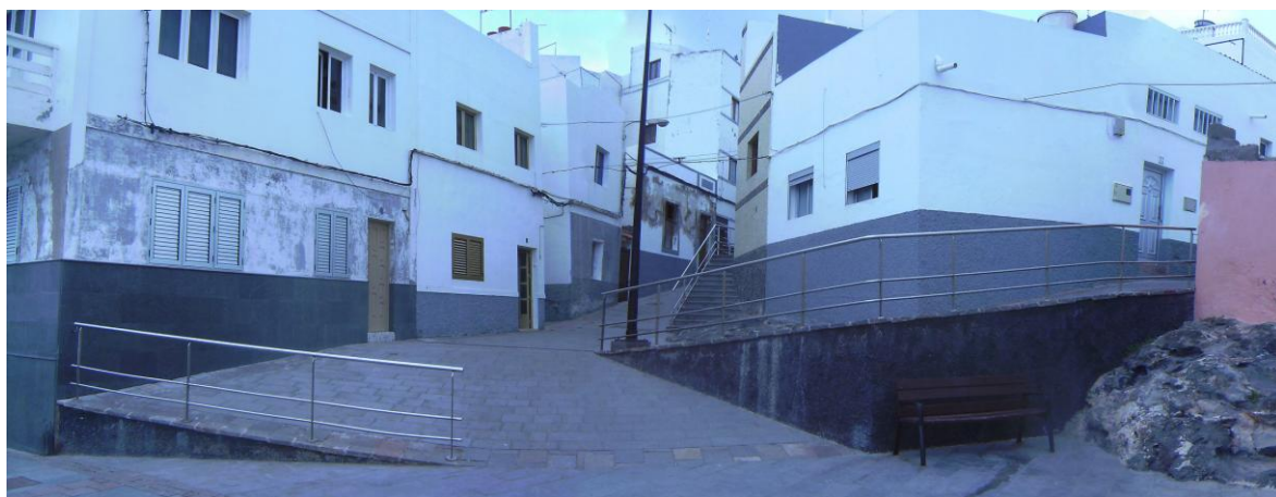
Fotografía de la fachada del tramo 3
