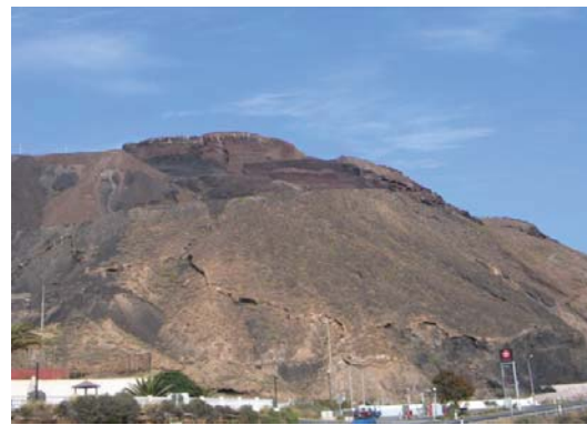
Riesgo por desprendimientos o deslizamientos en cono volcánico. Pico Negro
