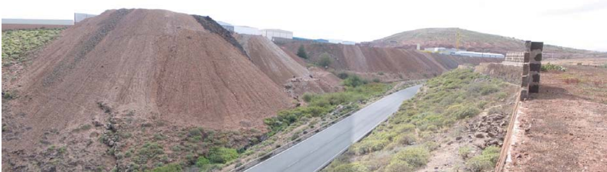
Taludes artificiales con numerosas incisiones. Montaña Blanca
