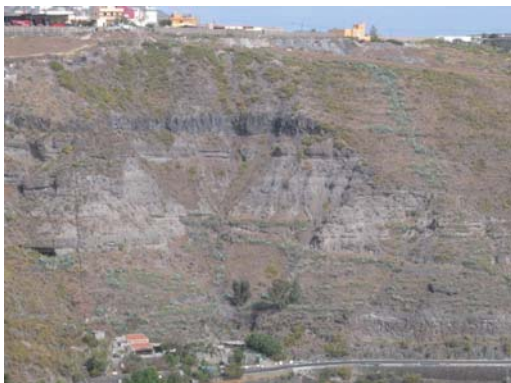
Riesgo por desprendimientos en laderas acentuadas sobre materiales fácilmente deleznales. Lomo Grande.
