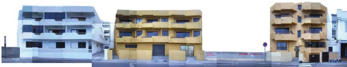
Fotografía de fachada del tramo 2
