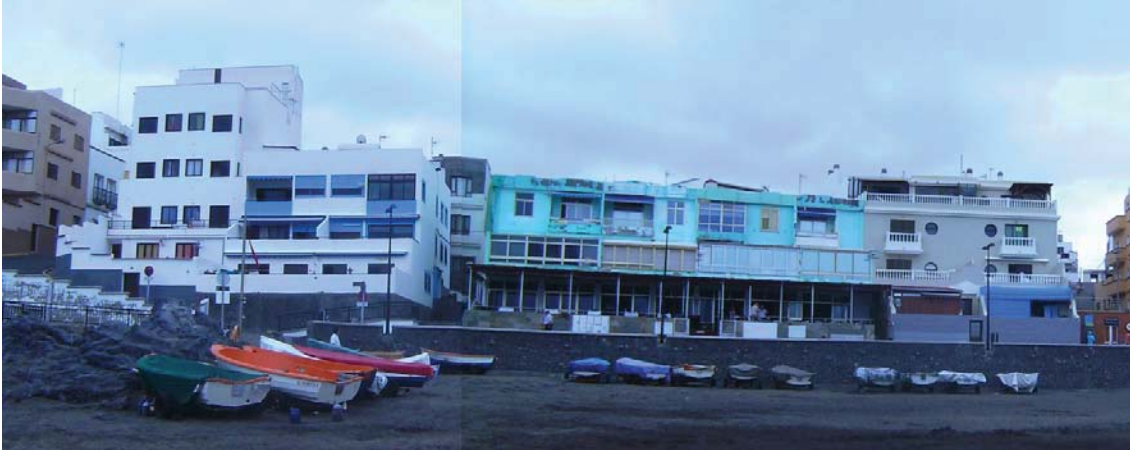
Fotografía de fachada del tramo I
