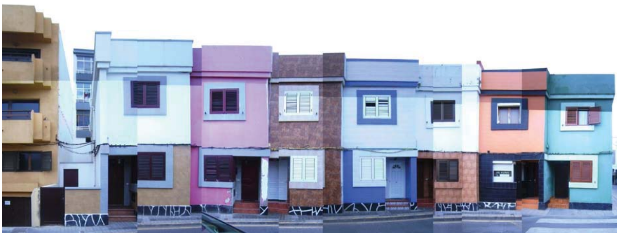
Fotografía de fachada del tramo I
