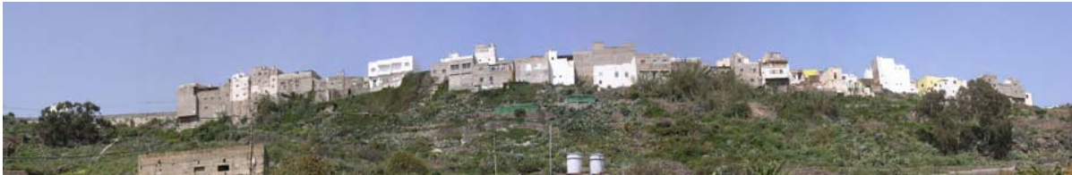
Impacto visual por falta de adecentamiento de fachadas. Lomo San Pedro-La Goleta
