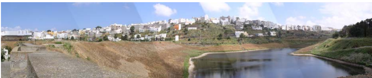
Infraestructura hidráulica existente en la Vega de Arucas. Estanque de los Alemanes
