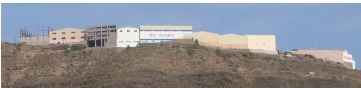
Borde de área industrial con notable impacto visual. Zona industrial de Montaña Blanca
