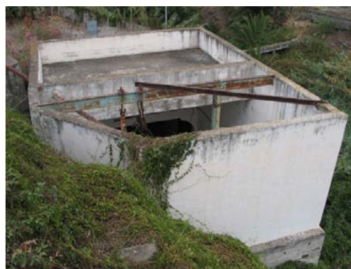
Pozo en explotación. Barranco de Tenoya
