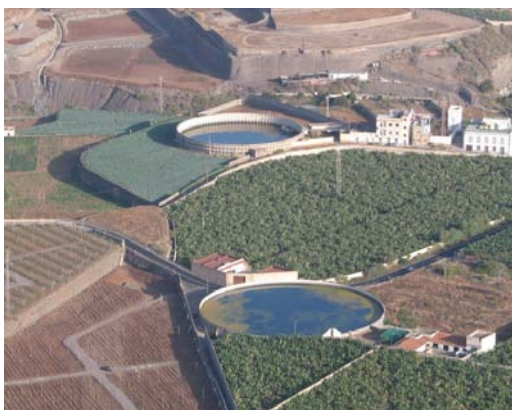
Estanques de hormigón
