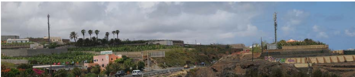
La proliferación de antenas de telefonía trae consigo que se localicen varias cercanas entre sí. El Guincho
