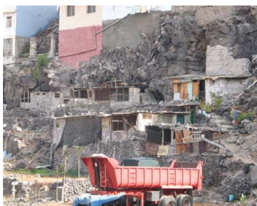
Chamizos y vertidos sólidos en el borde del núcleo urbano de Tinocas en contacto con el Bco. de Tenoya
