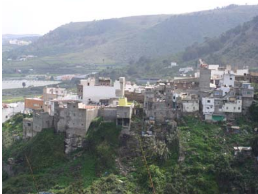
Vertidos sólidos y líquidos en traseras de viviendas y sobre ladera de barranco. La Goleta
