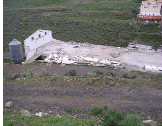
Granja avícola en abandono con un gran deterioro de sus instalaciones. Lomo Grande
