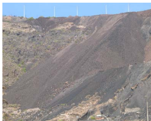
Riesgo erosivo por deslizamientos en taludes de materiales deleznable (picón) y sobre vertientes acentuadas. Pico Negro
