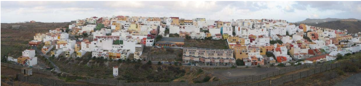
La falta de una adecuada ordenación y normativa “en ladera” trae consigo que se desarrollen conjuntos urbanos con escasa integración paisajística, en el que destacan las amplias medianeras vistas. Urbanización de San Francisco Javier
