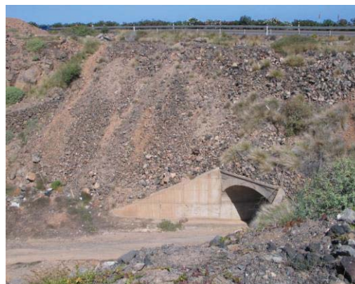
Talud de carreteras sobre cauce de barranco. GC-2 en Rosa Silva
