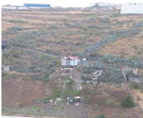
Edificaciones en precario (chamizos) y taludes de escombros. Lomo de Arucas-Hoya Ariñez
