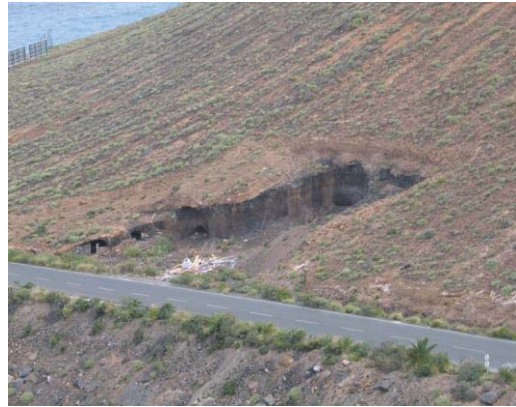
Vertidos sólidos (escombros) aprovechando las huellas de antigua cantera de picón abandonada. Pico Negro
