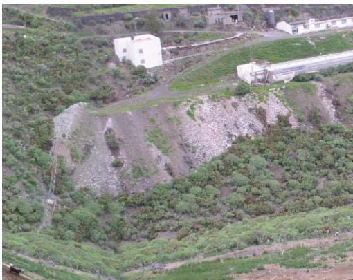
Talud sobre vertiente de barranco y granja avícola en abandono. Urb. San Fernando-Lomo de Arucas
