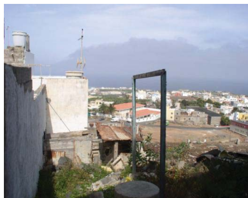
Chamizo y acumulación de vertidos en borde de suelo urbano. Llano Blanco
