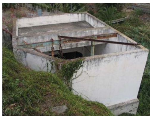
Pozo en abandono. Barranco de Arucas
