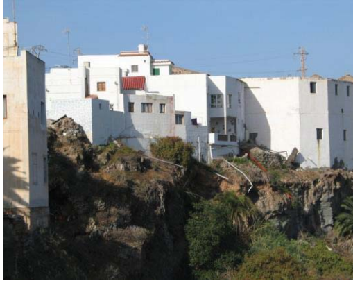
Ejemplo de vertidos líquidos de edificaciones residenciales sobre ladera de barranco
