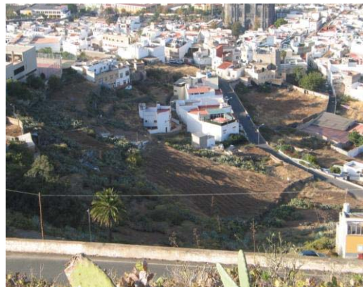
Espacios residuales, en borde de suelo urbano, de baja calidad paisajística por el abandono agrícola y la presión urbana. Vertiente oriental de Montaña de Arucas
