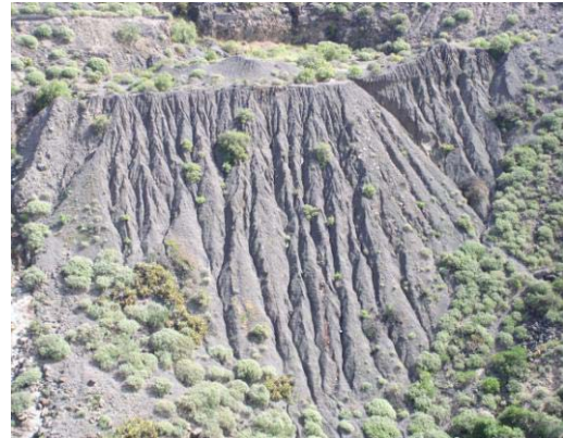
Ejemplos de procesos erosivos sobre taludes, en este caso incisiones o cárcavas. El Portichuelo
