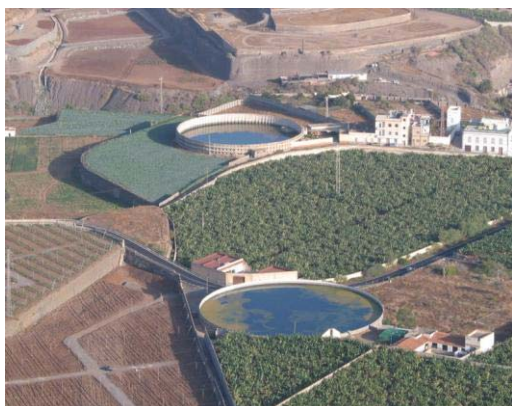
Estanques de hormigón
