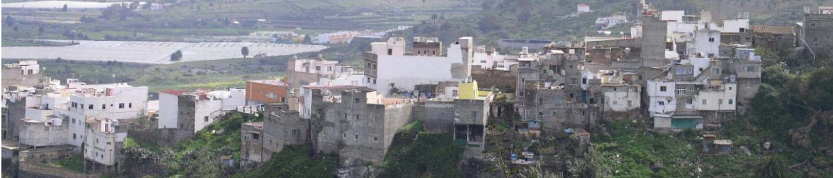
Ejemplo de Baja Calidad Visual, destacando el predominio de edificaciones en ladera, medianeras vistas, sin enfoscar y vertidos solidos y liquidos a la vertiente del barranco. Lomo San Pedro
