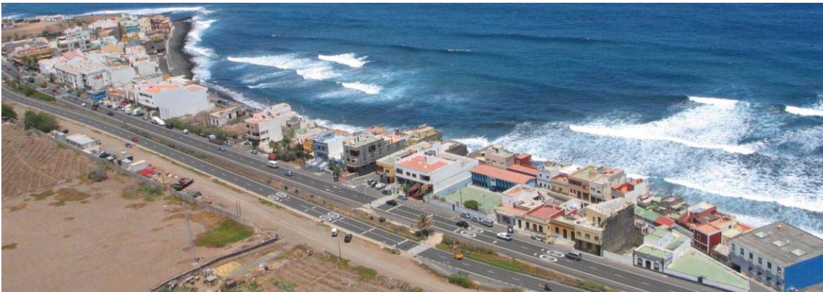
Ejemplo de Calidad Visual Media; si bien existen patologías edificatorias negativas, como las medianeras vistas, el impacto se mitiga gracias a la tipología, altura y cromatismo del conjunto de las edificaciones de la unidad, unido a la existencia de edificios con valor cultural. San Andrés.
