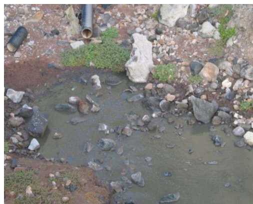
Vertidos de aguas residuales. Playa de Tinocas
