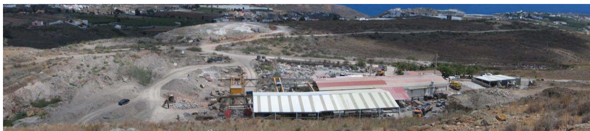
Instalaciones para transformación de la piedra de la cantera de Lomo Tomás de León
