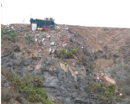
Vertidos incontrolados en borde de barranco. El Lomito
