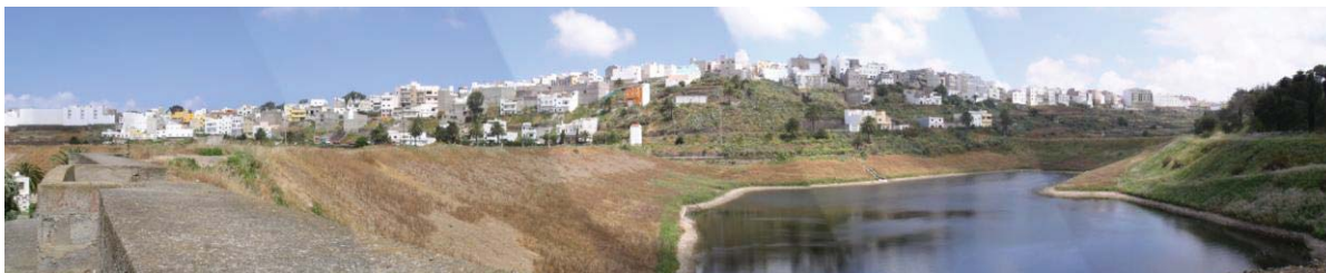
Infraestructura hidráulica existente en la Vega de Arucas. Estanque de los Alemanes
