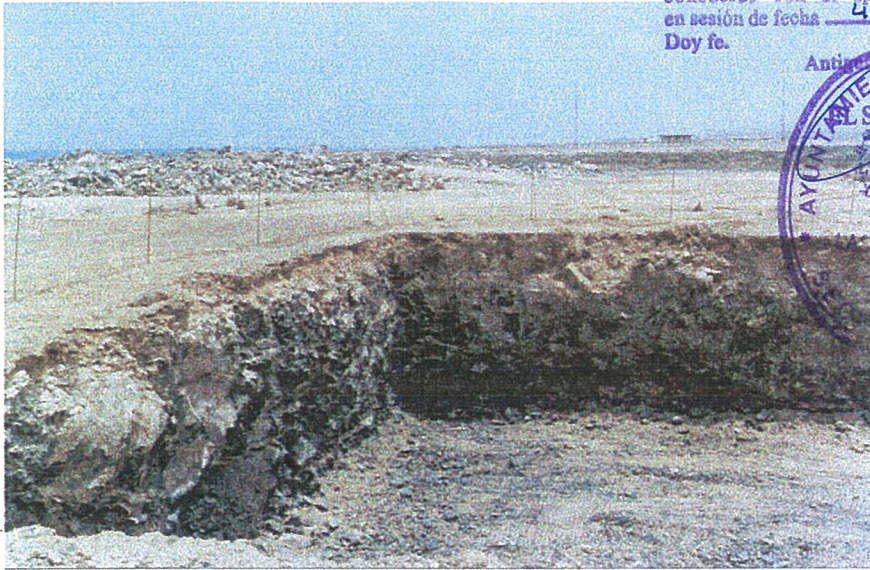
Zanja y vertido de roca
