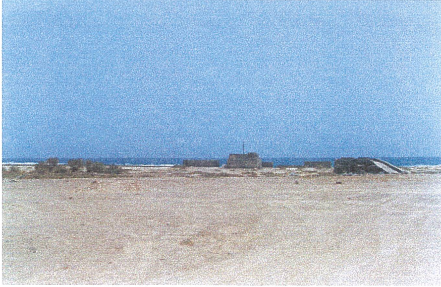
Movimientos de tierra próximos a los Hornos de La Guirra
