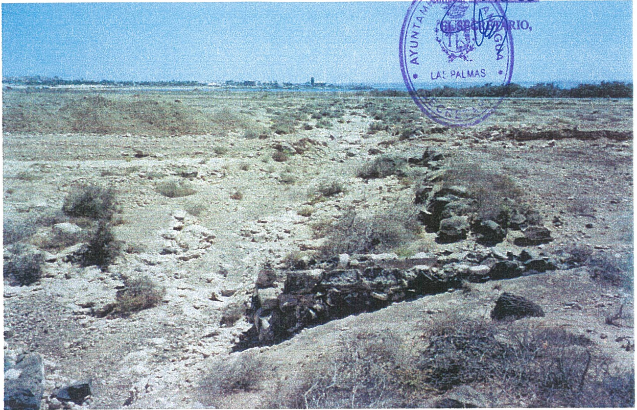
Edificio de captación y bombeo existente del agua de mar
