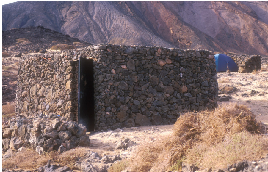
Figura 8. Choza rehabilitada (El Veril, Montaña Clara).
