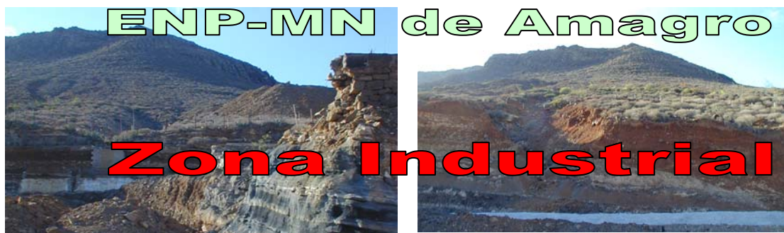
Obras de urbanización en la zona de uso industrial denominada San Isidro el Viejo en la falda sur de la ladera de Amagro, próximo al Espacio Natural Protegido Monumento Natural C-13
