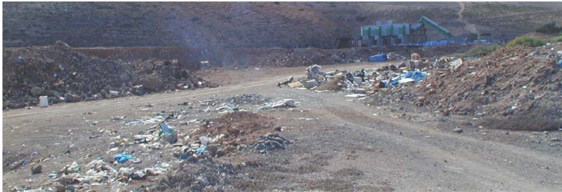
Visita realizada en septiembre de 2003 al Monumento Natural, donde se observan nuevos aportes de tierra en la zona del antiguo vertedero
