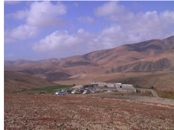
Estado y detalle de las instalaciones. Dirección norte.
